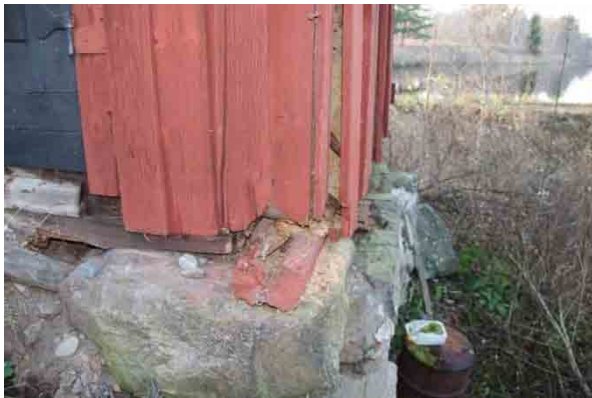
Bild t.v. skador i lutans norra syll och vägg.
