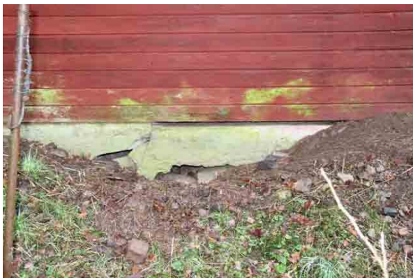
Bild t.v. grävling har skadat grunden, nordvästra fasaden. Bild t.h. äldre kvarvarande vattbräda på nordvästra takfallet.
