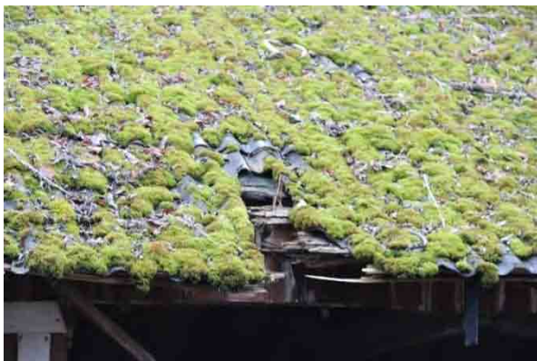
Bild t.v. hål i östra takfallet, mosspåväxt. Bild t.h. Stolpe och panel, hög marknivå, rötskador.
