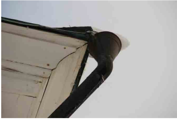
Bild t.v. Sydvästra hörnet isbildning utanpå stuprör. Bild t.h. Sprickor i lisen samt sprickor i putsen vid sidan av och under fönster.
