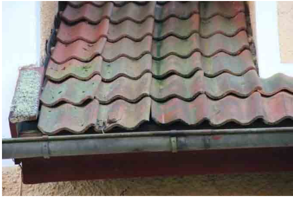
Bild t.v. norra takfallet, pannor glipar och ståndsivor mot fasad saknas. Bild t.h. östra takfallet på frontespis mot norr, spräckt tegelpanna.
