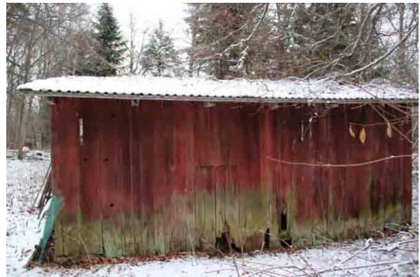
Bild t.v. södra gaveln, skador i väggen och i takfotsbräda samt hög marknivå.
