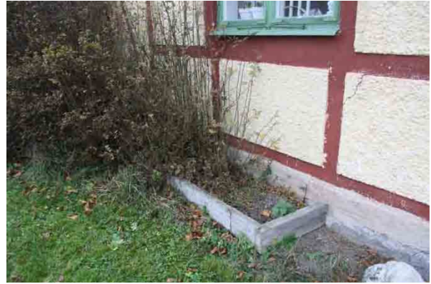
Bild t.v. spricka i puts och pågjuten betong på grunden. Norra fasaden. Bild t.h. rabatt in på norra fasaden.
