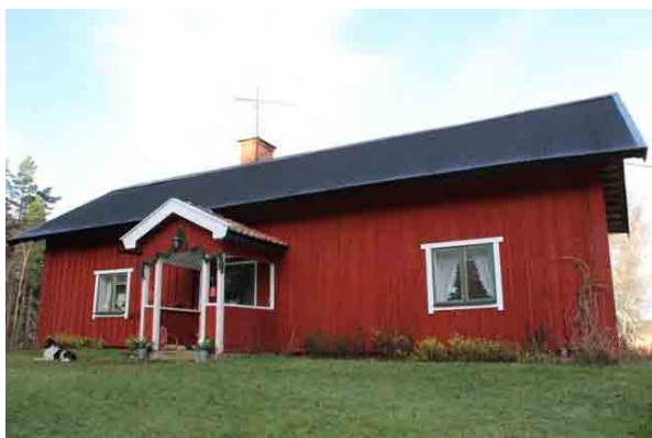
Bild t.v. Byggnadens södra fasad.
