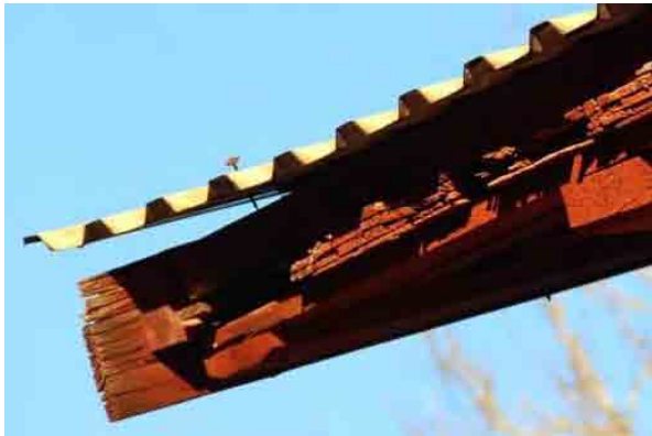
Bild t.v. Takplåten är spikad och spikarna har börjat släppa från underlaget
