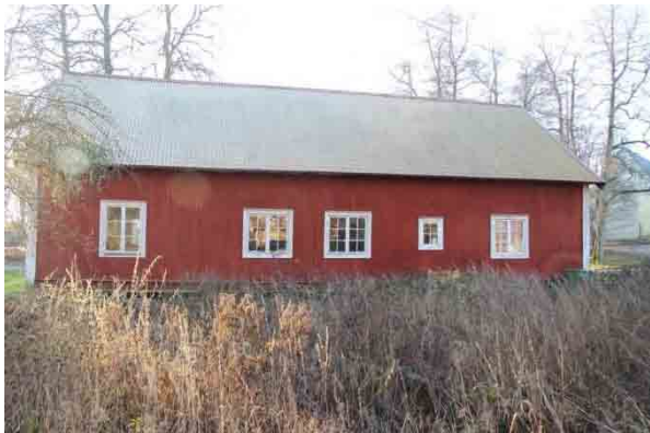
Bild t.v. norra fasaden.
