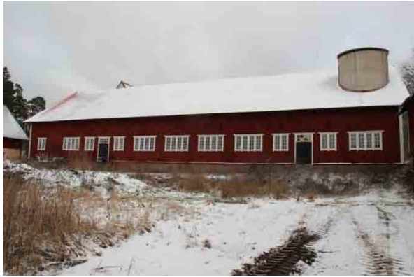
Bild t.v. västra fasaden.
