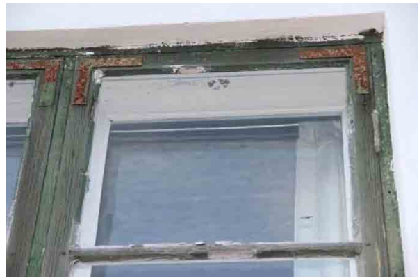
Bild t.h. putslagningar utförda med puts med avvikande sammansättning jämfört med äldre puts.
