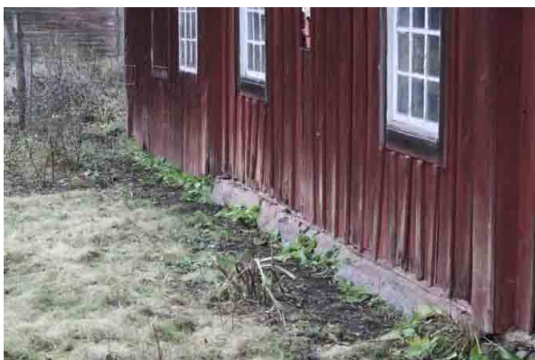
Bild t.v. Betong på grunden, håller fukt som skadar panel och ev. syll. Bild t.h. Fönster i behov av renovering.
