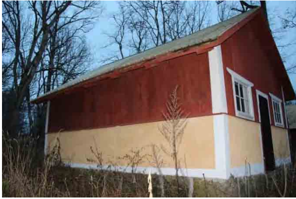
Bild t.v. Norra fasaden.
