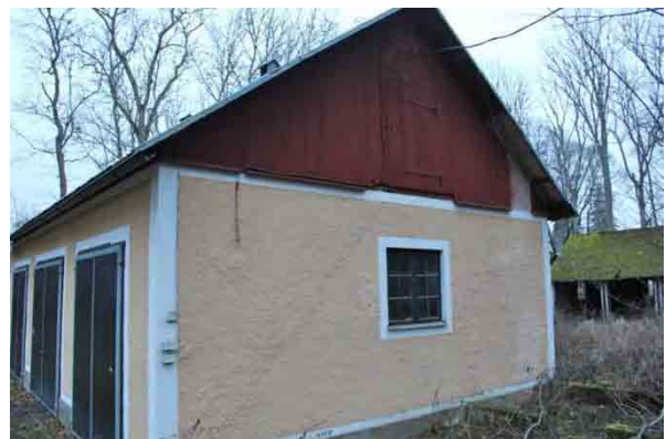
Bild t.h. norra gaveln i bild syns avsaknad av ett par panelbrädor samt vattbräda i gavelspets.
