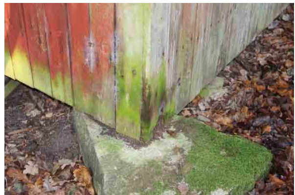
Bild t.v. Östra väggen, timmerstockar har brustit upp till och ned till i vägg samt rötskadats.
