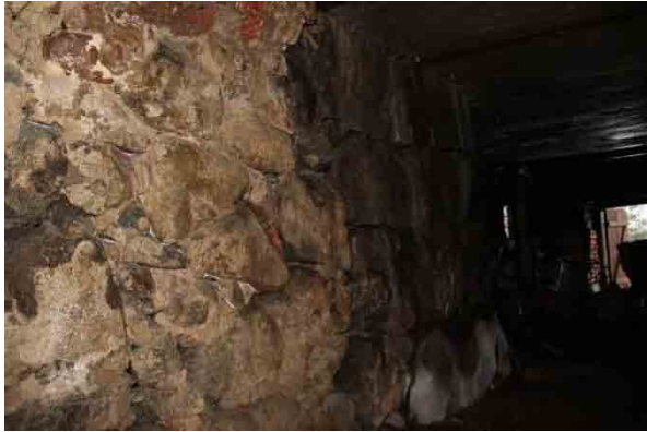
Bild t.v. väggar i källargång.
