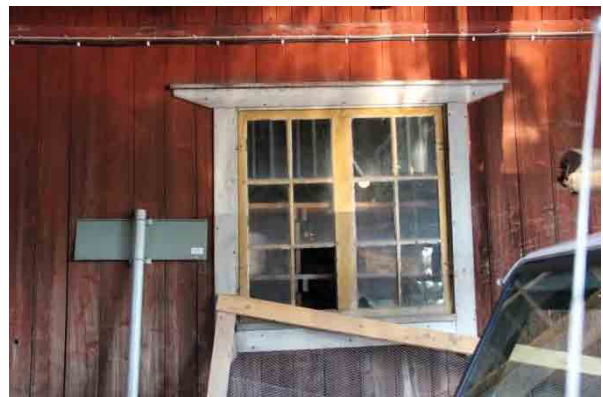
Bild t.h. äldre bevarad färgsättning på fönster. Södra fasaden, västra delen.
