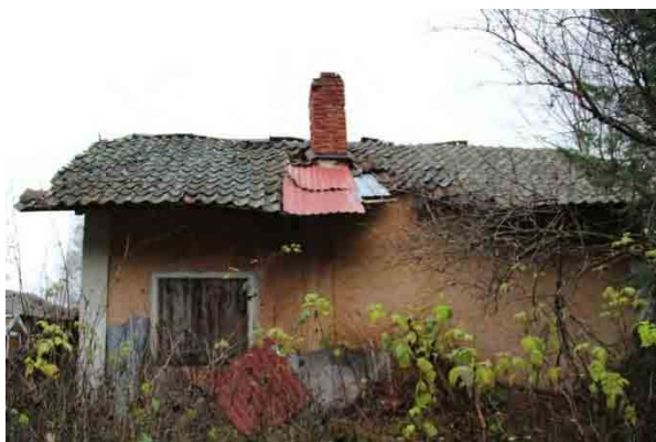
Bild t.v. sydvästra fasaden. Växtlighet och bråte inpå byggnaden. Omfattande skador i tak.
