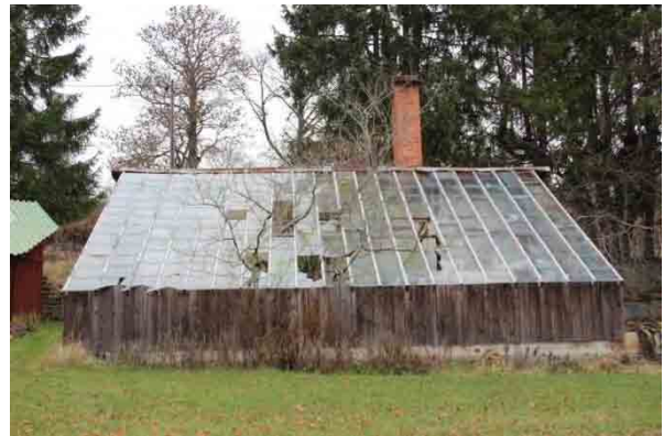
Bild t.v. Sydvästra gaveln. Bild t.h. Vinkast sedd från sydöst. Trasiga glas och Persikoträd som växt genom glastaket.
