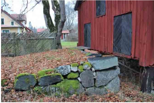
Bild t.v. Kallmurad körbro.
