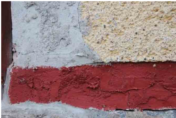
Bild t.v. lagningar med cementputs.
