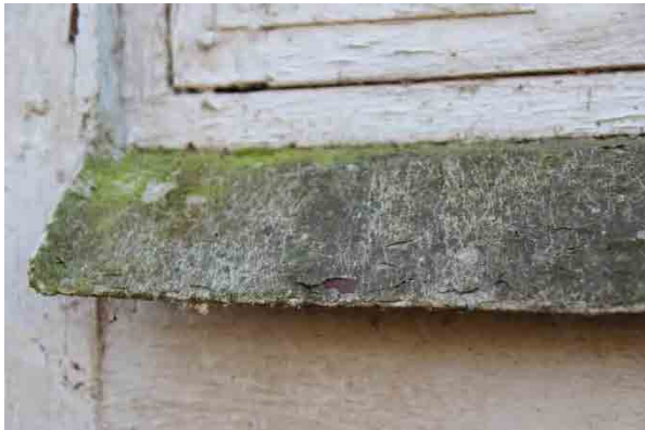
Bild t.v. fönsterbleck i behov av rostskyddsbehandling och ommålning,
