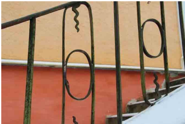
Bild t.v. Rostangripet smidesräcke till trappan.
