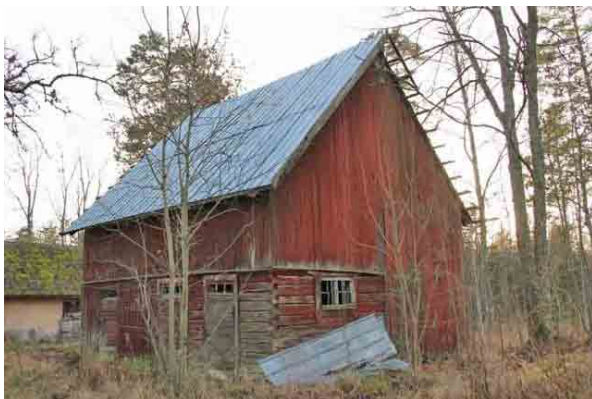
Bild t.v. nordvästra gaveln. takplåt saknas mot gaveln, fönsterglas sakas.
