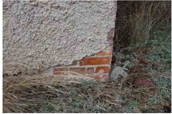
Bild t.v. östra takutsprånget med skador. Notera dekorativa detaljer i fasaden. Bild t.h. hög marknivå, putssläpp.
