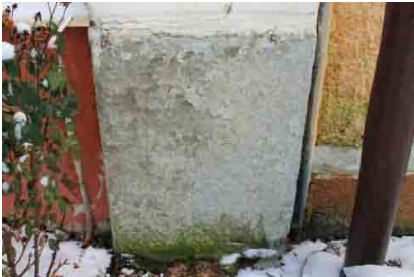
Bild t.v. Kalkstenen under hörnkedja har en yta som spjälkar loss. Algangreppen i nedre delen tyder på fukt. Bild t.h. Entrédörr med överljusfönster med monogram.
