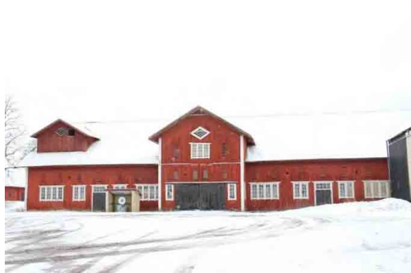
Bild t.v. östra fasaden.
