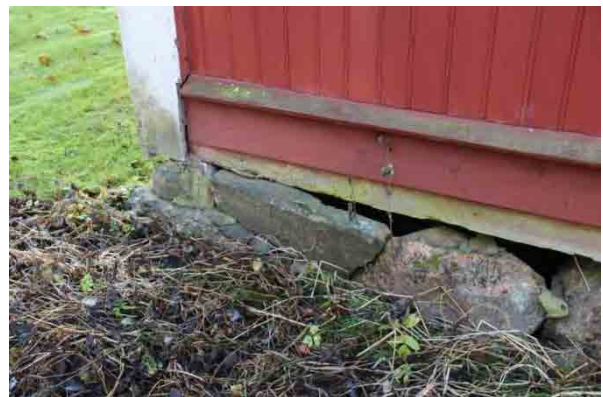
Bild t.h. norra fasaden, mot öster, grundstenar ur läge, ev. orsakad av grävlingar.
