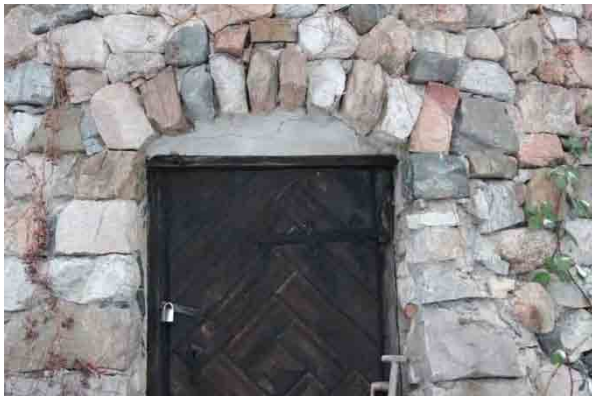
Bild t.v. Entré till källare med betong mellan det välvda överstycket och karmen.
