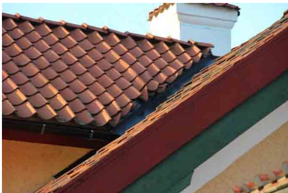
Bild t.v. tegelpanna vid rännedal ej på plats.
