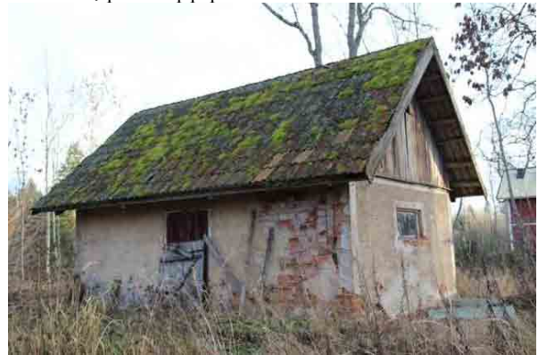
Bild t.v. nordöstra gaveln och sydöstra fasaden. Vattbrädor saknas, puts_släpp på fasaden.
