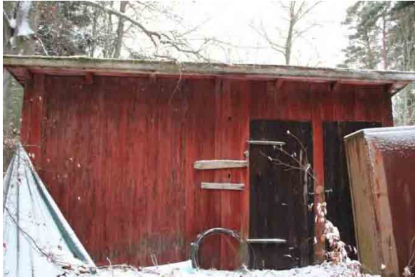
Bild t.v. östra fasaden, skador i takfotsbräda och hög marknivå.
