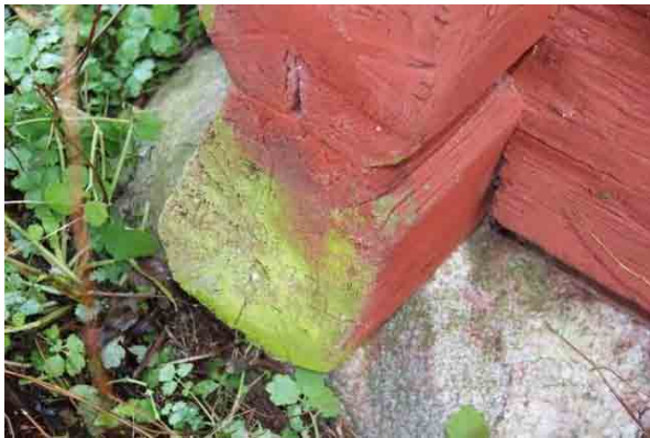
Bild t.v. nordvästra kuten med trapetsoid form på syllen.
