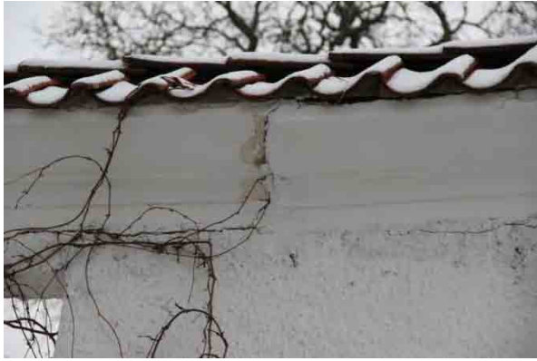
Bild t.v. och bild t.h. kraftiga sprickor i murverket.
