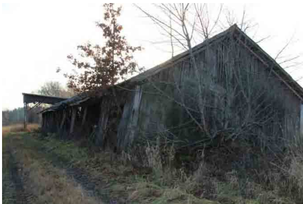
Bild t.v. Byggnad i öster fotad från norr. Bild t.h. Regelkonstruktion söder om östra byggnadslängan.
