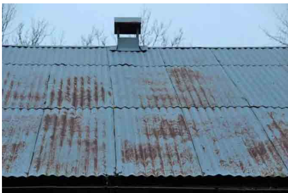
Bild t.v. östra takfallet med rostangrepp.
