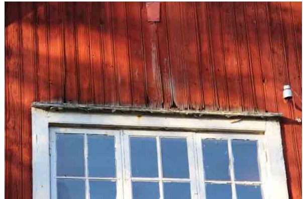
Bild t.v. fönsterbleck i behov av rostskyddsbehandling och ommålning,
