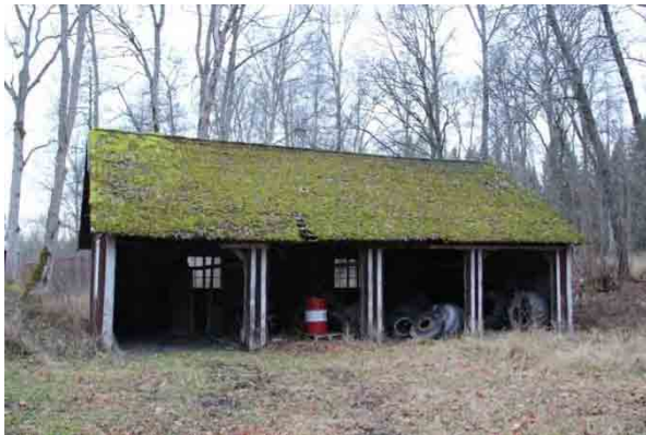
Bild t.v. östra fasaden.
