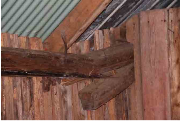
Bild t.v. Östra väggen, timmerstock har brustit.
