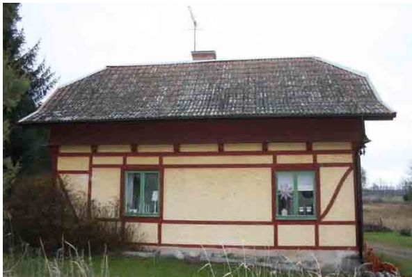
Bild t.v. västra fasaden.
