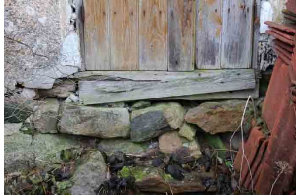
Bild t.v. del av nordöstra fasaden. Växtlighet och bråte in på byggnaden.
