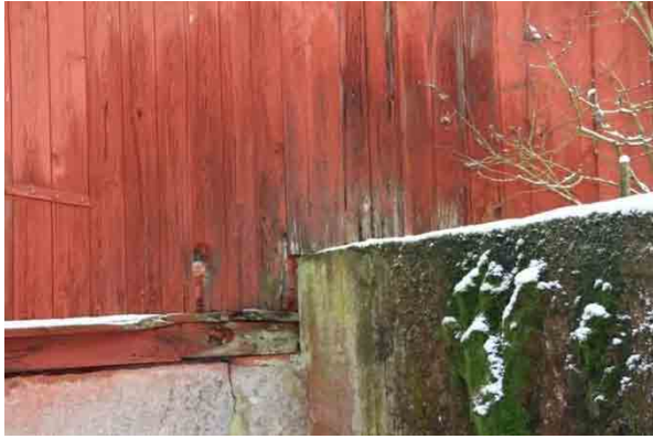
Bild t.v. skador i panel och troligen syll bakom betongkonstruktion på västra fasaden. Bild t.h. syll kraftigt skadad, ev. insektsangrepp, norra fasaden vid lastbryggan.
