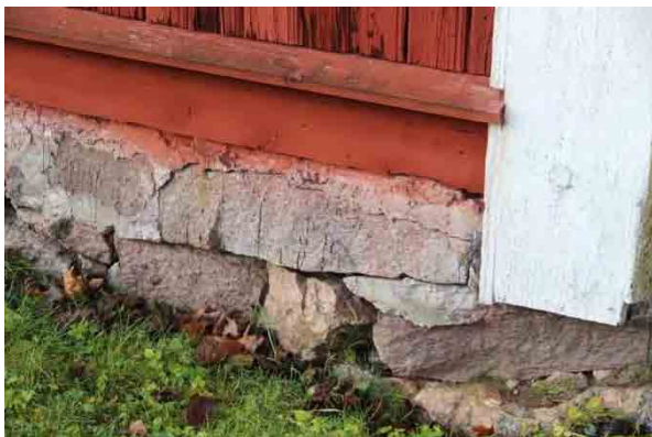
Bild t.v. östra gaveln, mot norr, lagningar med cement.
