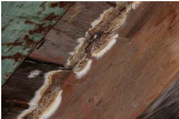
Bild t.v. rötskada med svampangrepp i norra takfallet, från insidan. Bild t.h. mindre rötskada med svampangrepp i södra takfallets östra del, från insidan.
