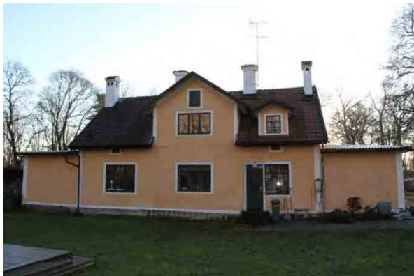
Bild t.v. norra fasaden.
