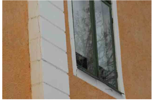
Bild t.v. Sydvästra hörnet isbildning utanpå stuprör. Bild t.h. Sprickor i lisen samt sprickor i putsen vid sidan av och under fönster.
