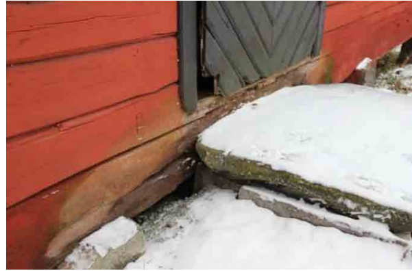
Bild t.v. plint av tegelmurverk under knutkedja i norra väggen, frostsprängda stenar. Bild t.h. skador i timmer bakom trappsten, norra fasaden.
