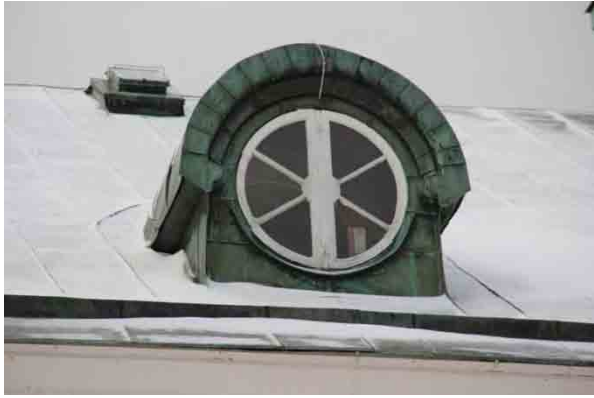
Bild t.v. Takkupa på östra takfallet. Kopparklädd.
