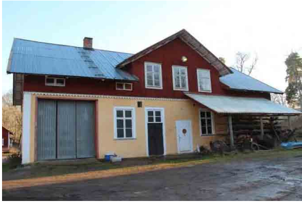
Bild t.v. västra fasaden.
