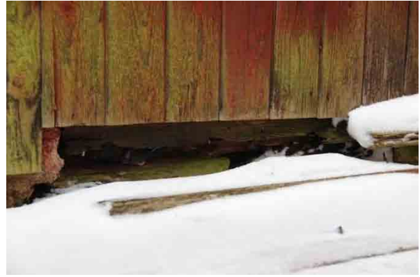
Bild t.v. skador i panel och troligen syll bakom betongkonstruktion på västra fasaden. Bild t.h. syll kraftigt skadad, ev. insektsangrepp, norra fasaden vid lastbryggan.
