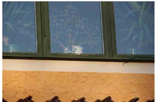
Bild t.v. tegelpanna ur läge och ståndsivor mot fasad saknas, södra takfallet. Bild t.h. fönster i behov av underhåll.
