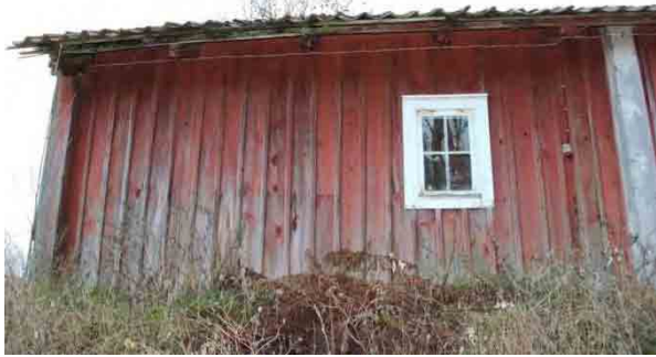
Bild t.v. del av nordvästra fasaden.
