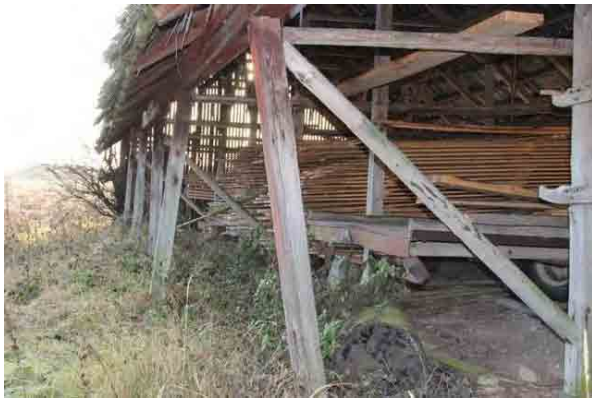
Bild t.v. takbärande stolpar i nordöstra fasaden kalvar åt olika håll. Bild t.h. stolpe är rötskadad nedtill och har glidit av grundsten.
