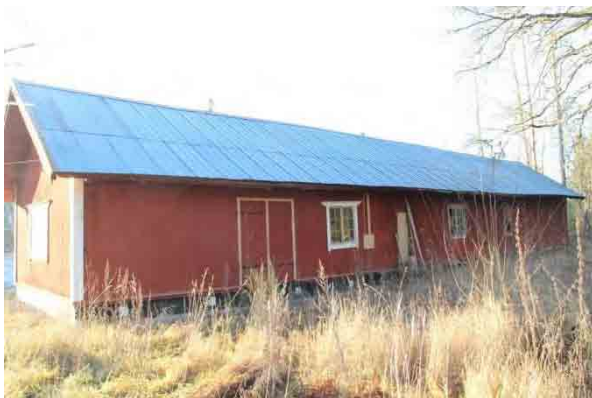
Bild t.v. norra fasaden.
