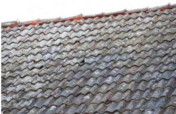
Bild t.v. norra takfallet, exempel på skador i taktegelet Bild t.h. mindre rötskada med svampangrepp i norra takutsprånget.
