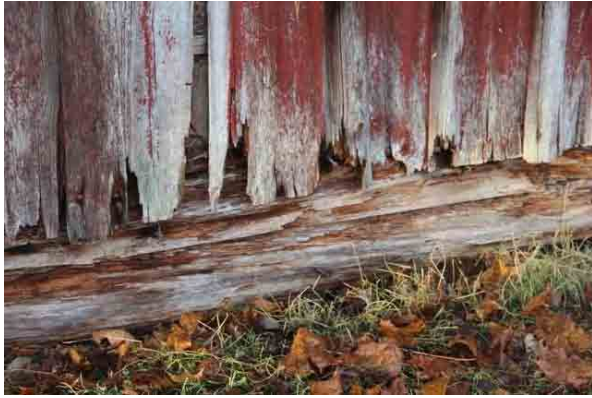
Bild t.v. Marknivån alltför hög mot byggnaden. Fotbräda saknas. Omfattande rötskador i panel.
