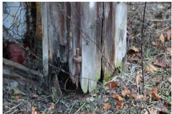
Bild t.v. hål i östra takfallet, mosspåväxt. Bild t.h. Stolpe och panel, hög marknivå, rötskador.
