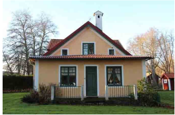
Bild t.h. östra gaveln, uteplats med betonggolv och rostigt smidesräcke.
