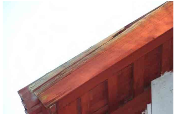
Bild t.v. Takplåten är spikad och spikarna har börjat släppa från underlaget
