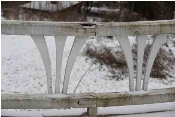
Bild t.v. träräcke med mindre skada Bild t.h. stödmur, skolsten saknas, sprickbildning i murverket
