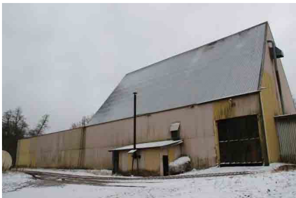
Bild t.v. Fasad mot nordväst
