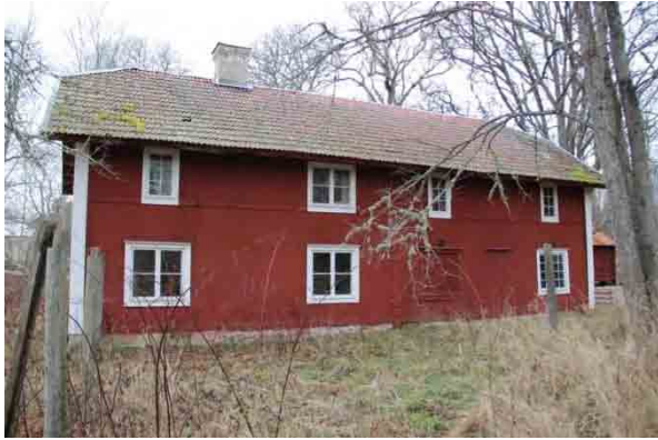
Bild t.v. östra fasaden.
