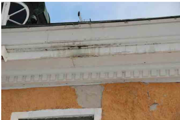
Bild t.v. Putsskador i fasad och missfärgning av takfotslist på västra fasaden efter tidigare åtgärdat takläckage.
