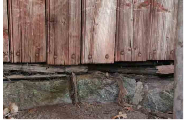
Bild t.h. äldre bevarad panel och röstskadad syll. Södra fasaden, västra delen.
