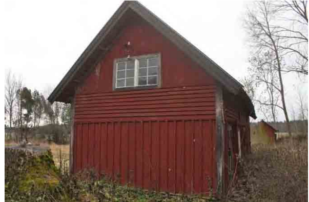
Bild t.v. östra fasaden. Mossbevuxet tak och skorsten utan väderskydd. Bild t.h. norra gaveln.
