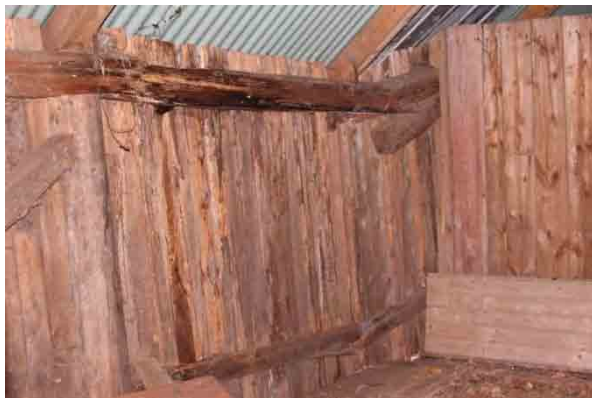
Bild t.v. Östra väggen, timmerstockar har brustit upp till och ned till i vägg samt rötskadats.
