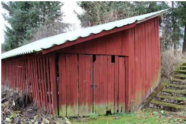
Bild t.v. Östra gaveln, fuktskadad panel och dörrar. Bild t.h. Del av östra gaveln och norra fasaden med slyppslag.
