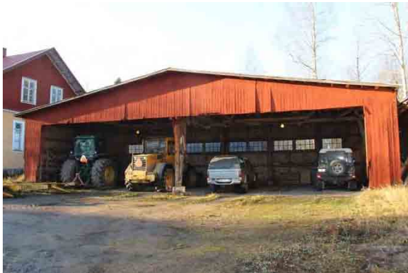
Bild t.v. byggnaden från öster Bild t.h. västra gaveln.
