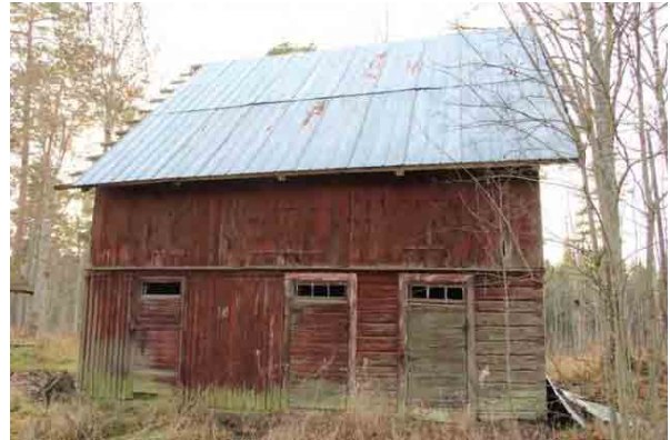
Bild t.h. nordöstra fasaden, takplåt saknas mot södra gaveln, glas saknas i dörrarnas överljus.
