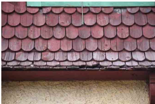
Bild t.v. väderbitna spån, gavelspets mot norr.
