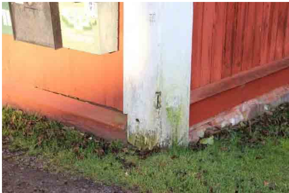
Bild t.v. och bild t.h. vid sydöstra knuten har syllarna gått isär och syllen mot söder ligger troligen mot marken.
