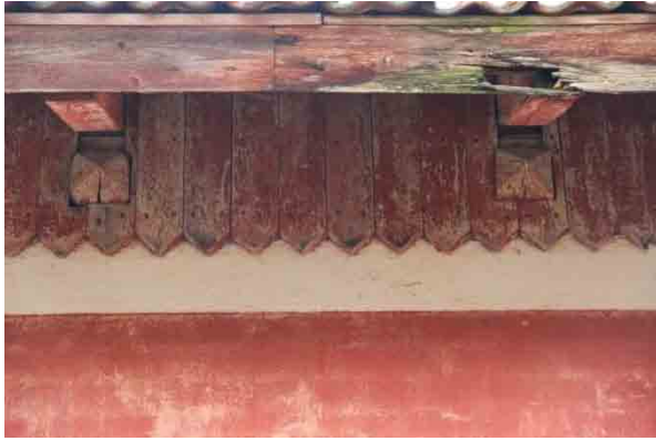
Bild t.v. östra takutsprånget med skador. Notera dekorativa detaljer i fasaden. Bild t.h. hög marknivå, putssläpp.
