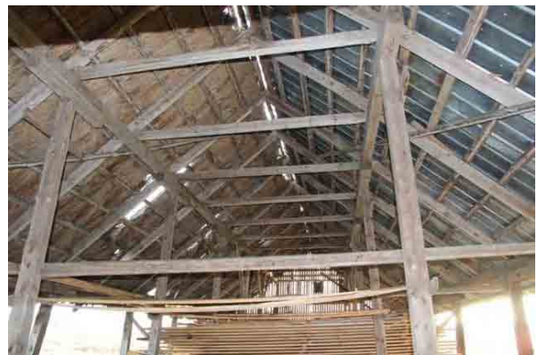
Bild t.v. nordvästra gaveln med förrådsutrymme. Bild t.h. taket inifrån med halmtak och pannplåt. Otillräcklig täckning syns.
