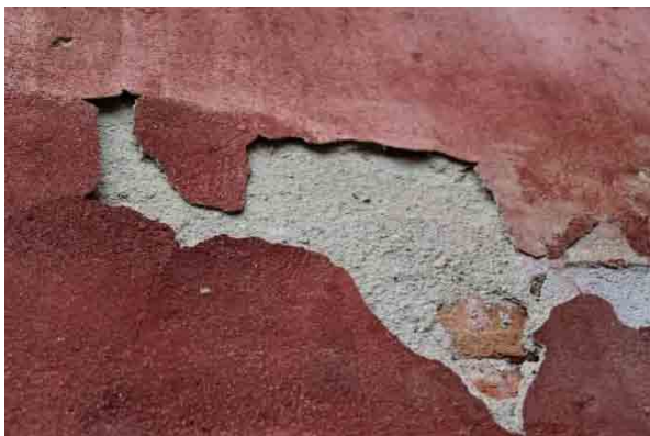
Bild t.v. putssläpp. Bild t.h. västra takfallet med skador och handslaget lertegel.
