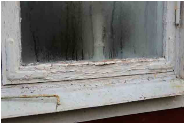
Bild t.v. fönster med sprucket färgskikt och början till kittbortfall. Bild t.h. rötskada med svamptillväxt nordvästra takutsprånget.
