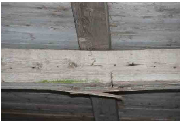
Bild t.v. bärlina under byggnaden har brutit. Bild t.h. stolpe med skador nertill.
