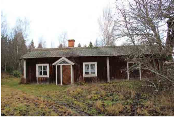
Bild t.v. sydöstra fasaden.
