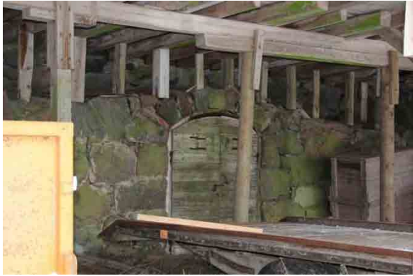
Bild t.v. grundmur med ingång till jordkällare under byggnaden. Stenarna är gröna av alger p.g.a. fukt. Bild t.h. bärlinor och strävor är borttagna
