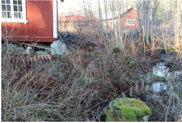
Bild t.v. Marken är sank intill Dagsverkstugans nordöstra knut.
