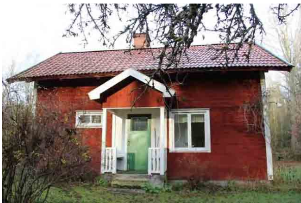
Bild t.v. sydöstra fasaden
