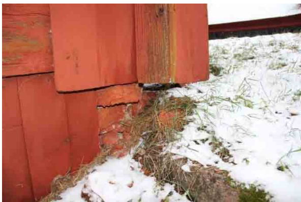
Bild t.v. plint av tegelmurverk under nordöstra knuten, frostsprängda stenar. Bild t.h. skador i timmer i östra gaveln.
