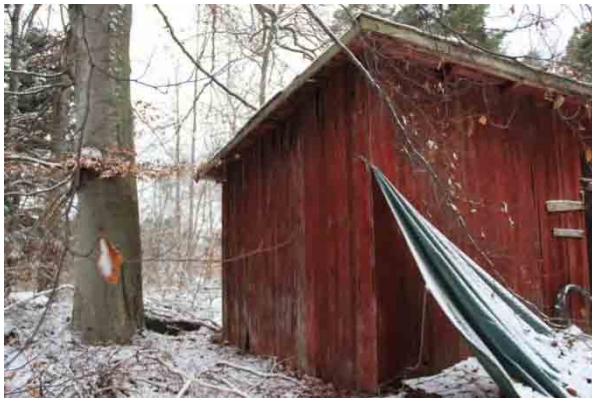
Bild t.v. södra gaveln, skador i väggen och i takfotsbräda samt hög marknivå.
