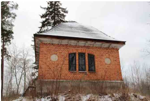
Bild t.v. östra fasaden.
