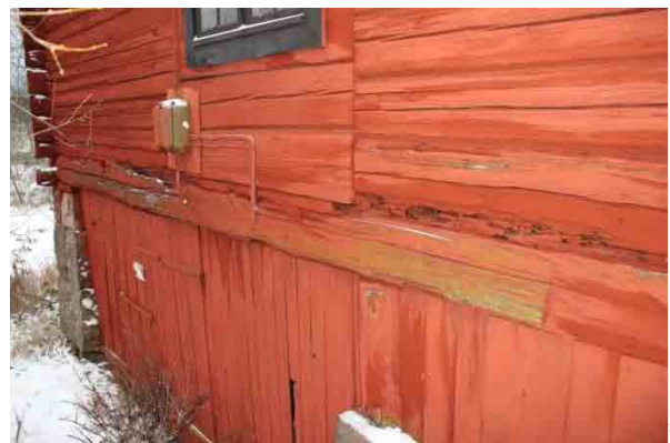
Bild t.v. plint av tegelmurverk under nordöstra knuten, frostsprängda stenar. Bild t.h. skador i timmer i östra gaveln.
