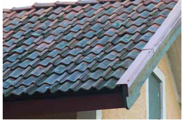
Bild t.v. norra takfallet, pannor glipar och ståndsivor mot fasad saknas. Bild t.h. östra takfallet på frontespis mot norr, spräckt tegelpanna.
