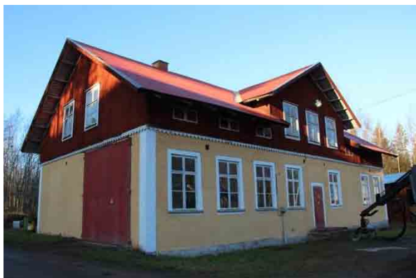
Bild t.v. östra fasaden.
