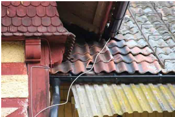
Bild t.v. spräckt tegelpanna tafall mot söder. Bild t.h. rostig plåt i ränn dal och kring skorsten.
