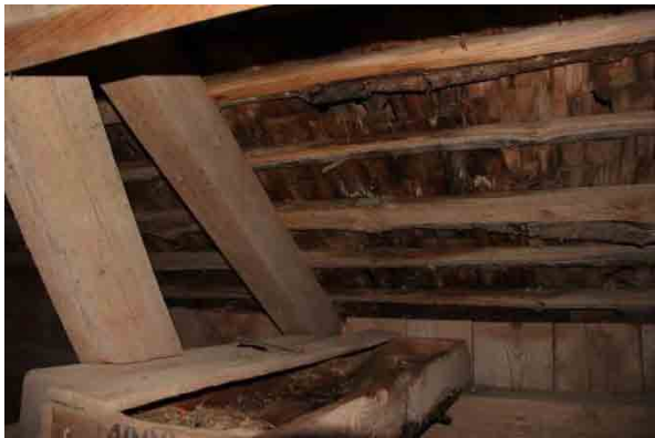
Bild t.v. och bild t.h. takläckage i södra takfallet.
