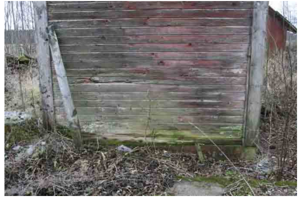
Bild t.h. Del av norra fasaden, hög marknivå, skador i nederdel av panel.
