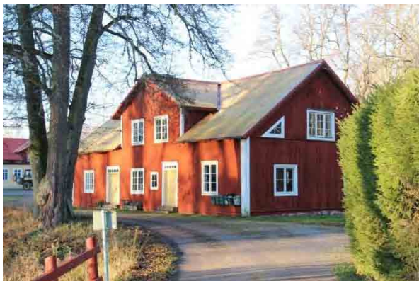
Bild t.v. södra fasaden och östra gaveln.
