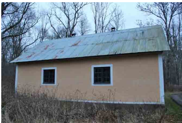
Bild t.v. västra fasaden.
