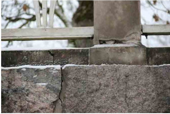
Bild t.v. sprickbildning i murverket och överliggande delar av betong.
