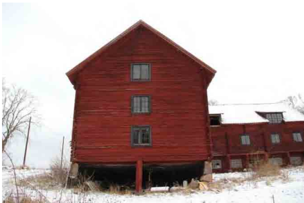
Bild t.v. södra gaveln. Bild t.h. östra fasaden
