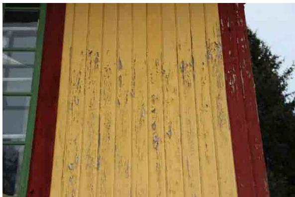
Bild t.v. färg flagnar, färgtyp? Panelad fasad mot söder.
