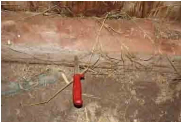
Bild t.v. norra väggens syll från insidan visar att än så länge behöver inte hela syllen bytas.
