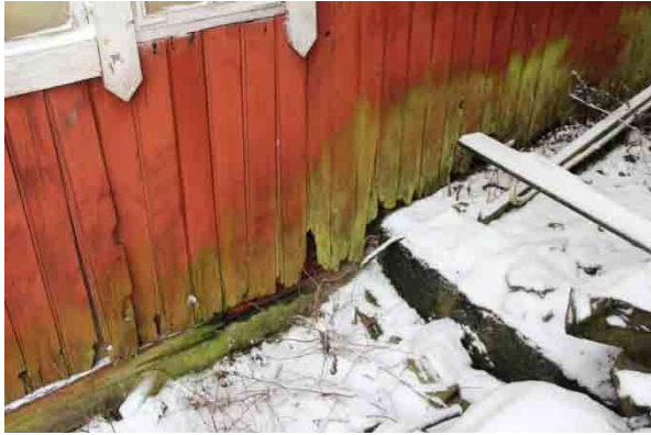
Bild t.v. rötskador i östra väggen mellan byggnad 13 och 15.
