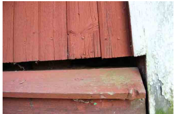
Bild t.v. och bild t.h. vid sydöstra knuten har syllarna gått isär och syllen mot söder ligger troligen mot marken.
