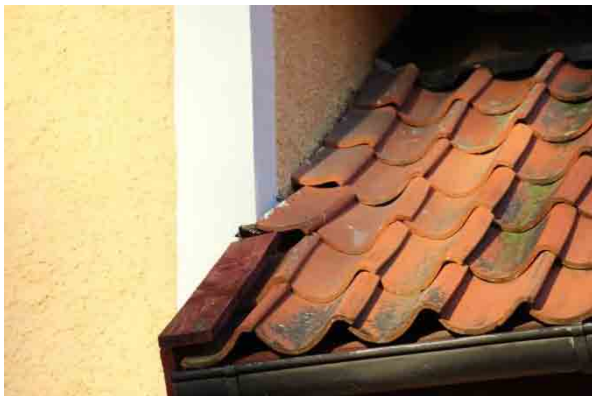
Bild t.v. tegelpanna ur läge och ståndsivor mot fasad saknas, södra takfallet. Bild t.h. fönster i behov av underhåll.
