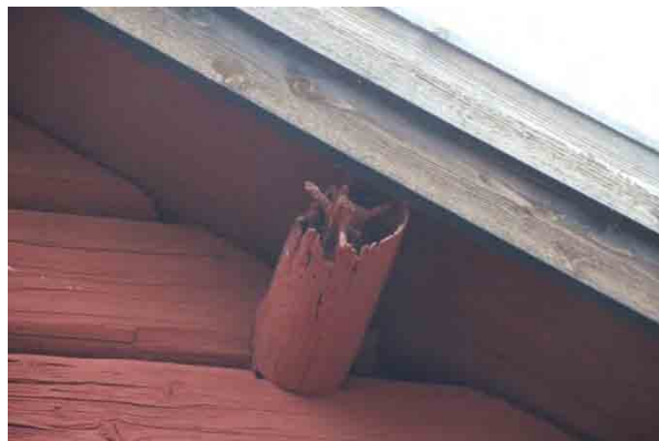
Bild t.v. Ev. innanrutten takås, södra takutsprånget.
