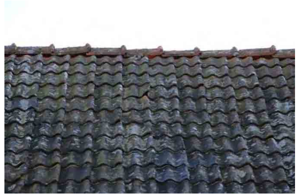
Bild t.v. rostig vindflöjel i öster med årtal 1773. Nocktäckningen är otillräcklig. Bild t.h. norra takfallet, exempel på spräckt panna
