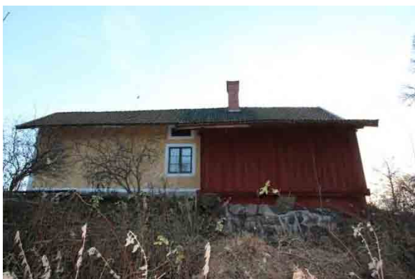
Bild t.v. norra fasaden.
