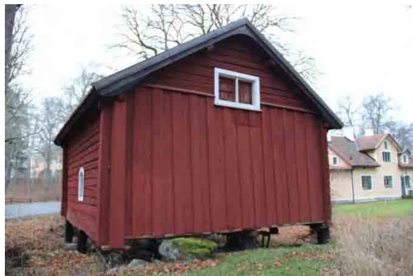
Bild t.v. Norra gaveln. Bild t.h. Västra fasaden.
