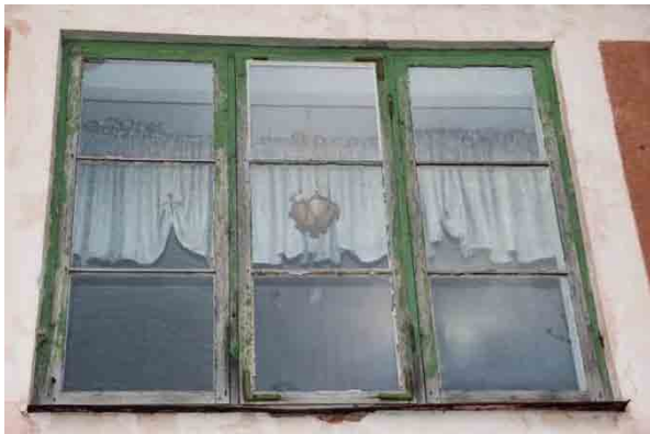
Bild t.v. fönster i renoveringsbehov. Bild t.h. hög marknivå, putssläpp.
