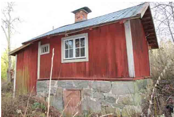
Bild t.v. sydvästra fasaden Bild t.h. nordvästra gaveln
