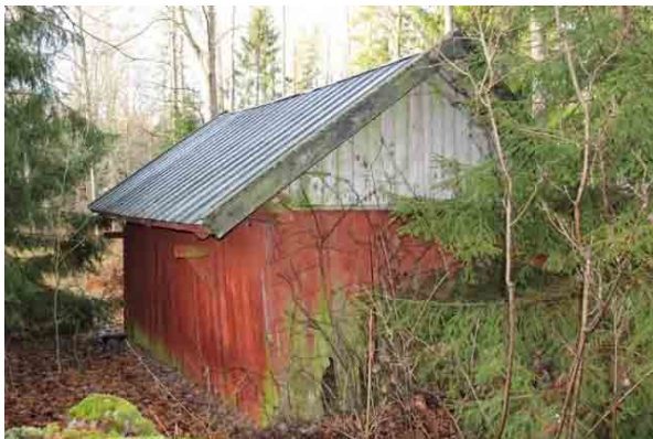
Bild t.v. norra gaveln och östra fasaden, rötskador och hög marknivå.
