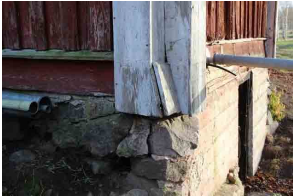
Bild t.v. nordvästra knuten med specialanpassning av knutbrädan p.g.a. syllens trapetsoida form
