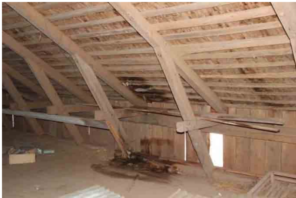
Bild t.v. takläckage i norra takfallet. Bild t.h. skador i norra takfallet.
