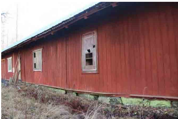
Norra fasaden med äldre bevarade fönster.
