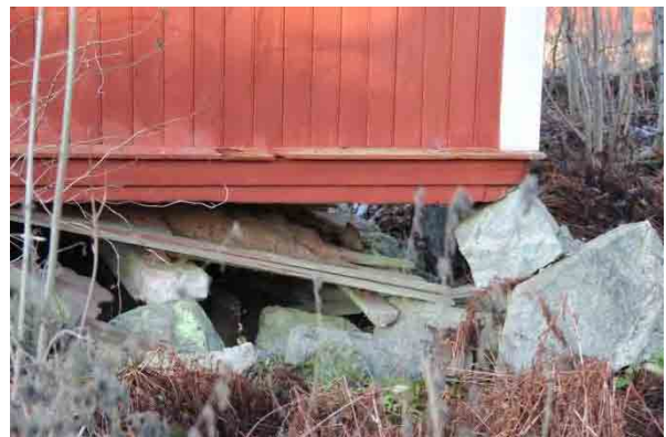
Bild t.v. Skador i grunden mot söder, ett ev grävlingbo kan ha underminerat stengrunden.
