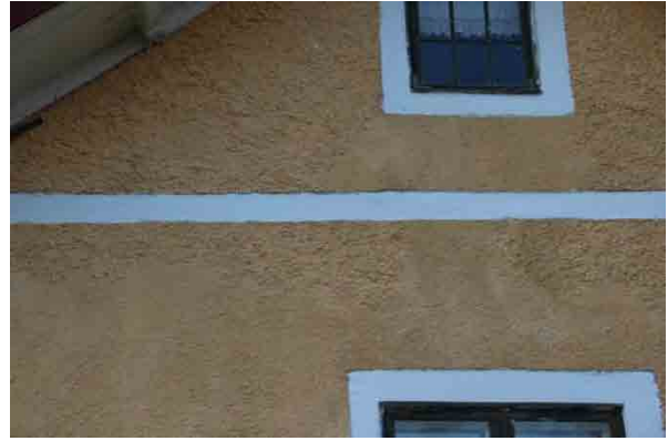
Bild t.h. putslagningar utförda med puts med avvikande sammansättning jämfört med äldre puts.
