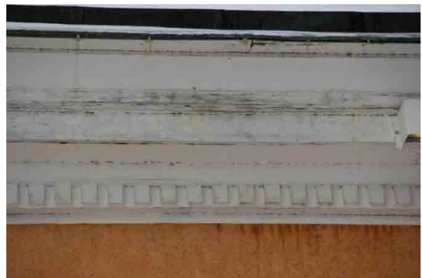
Bild t.v. Putsskador i fasad och missfärgning av takfotslist på västra fasaden efter tidigare åtgärdat takläckage.
