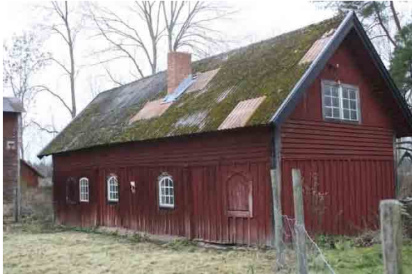
Bild t.v. östra fasaden. Mossbevuxet tak och skorsten utan väderskydd. Bild t.h. norra gaveln.
