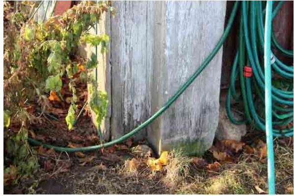
Bild t.v. Marknivån alltför hög mot byggnaden. Fotbräda saknas. Omfattande rötskador i panel.
