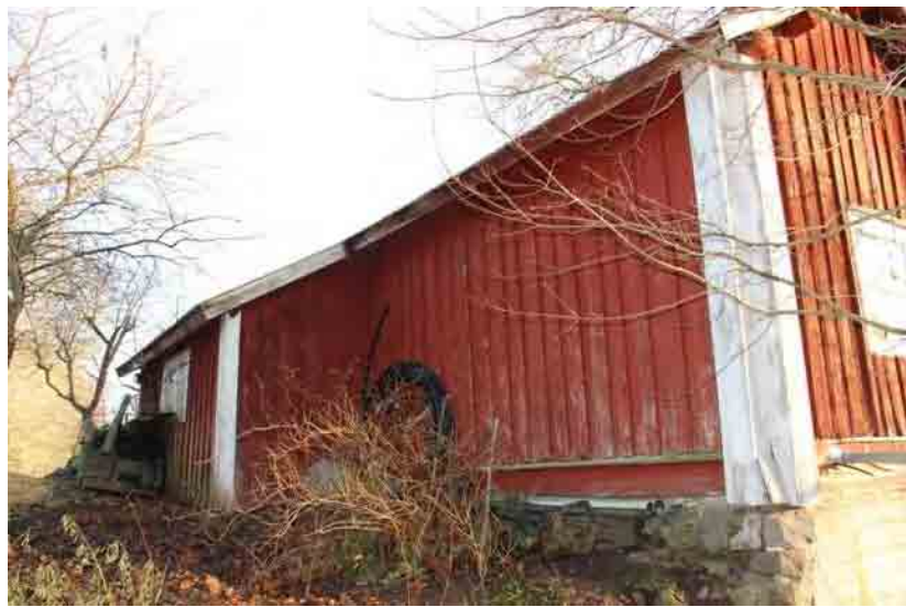
Bild t.h. Östra fasaden med vindslucka och dörr till den tillbyggda lutan. Takets åsar synliga. Panel och stomme är skadade nertill.
