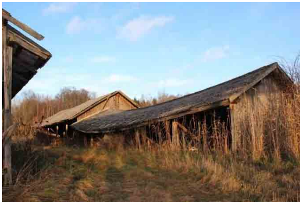
Bild t.v. Byggnad i väster fotad från söder. Bild t.h. Byggnad i öster fotad från söder.
