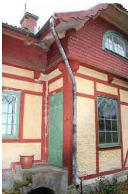
Bild t.v. äldre bevarad takavvattning med skarpa vinklar av galvad plåt.
