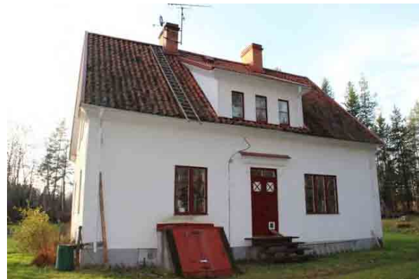
Bild t.v. östra fasaden Bild t.h. norra gaveln.
