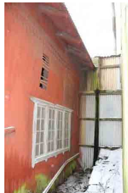
Bild t.v. rötskador nertill under takutsprång där hängrännor saknas, se bild ovan. Bild t.h. utrymme mellan byggnad 13 och 15, kraftiga fuktskador i väggen.
