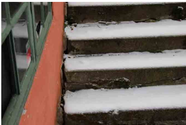
Bild t.v. Sättning i trappa, lutar in mot fasaden. Sprickor finns i den gjutna betongtrappan.
