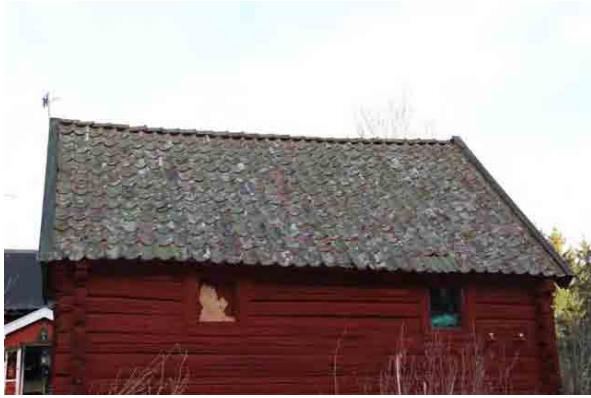
Bild t.v. Södra takfallet
