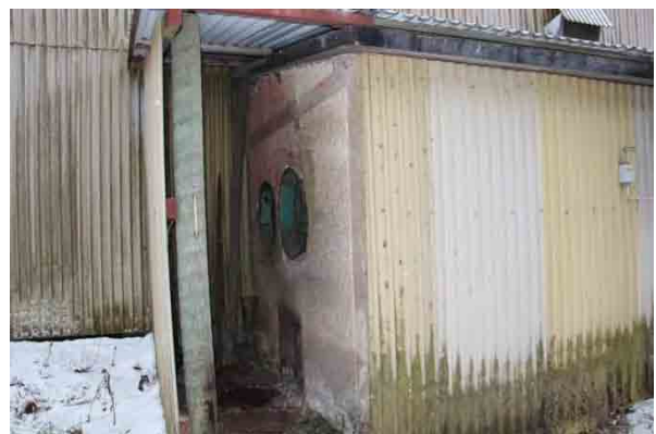
Bild t.h. Äldre bevarad byggnadsdel av fasad till en tidigare byggnad, nordvästra fasaden.
