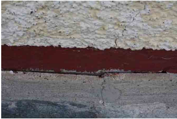
Bild t.v. spricka i puts och pågjuten betong på grunden. Norra fasaden. Bild t.h. rabatt in på norra fasaden.
