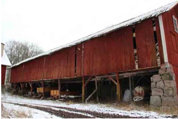
Bild t.v. norra fasaden
