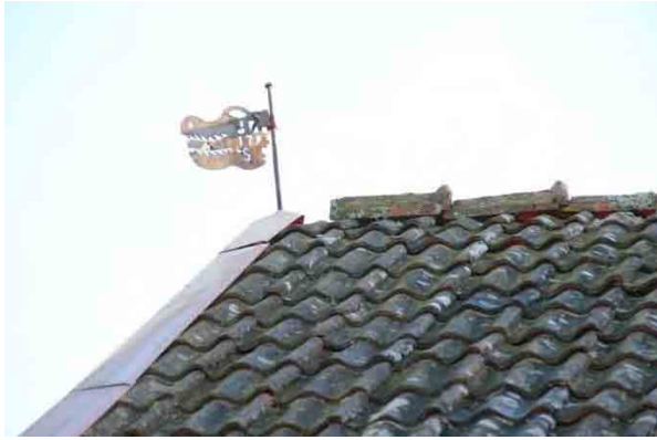
Bild t.v. rostig vindflöjel i öster med årtal 1773. Nocktäckningen är otillräcklig. Bild t.h. norra takfallet, exempel på spräckt panna
