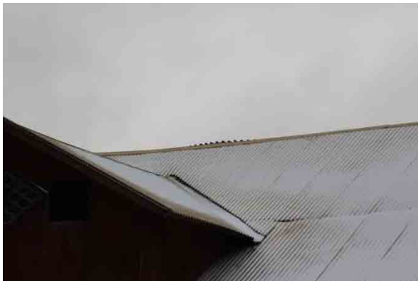
Bild t.v. takplåt har släppt vidnock. Bild t.h. hängrännor saknas, östra takfallet.
