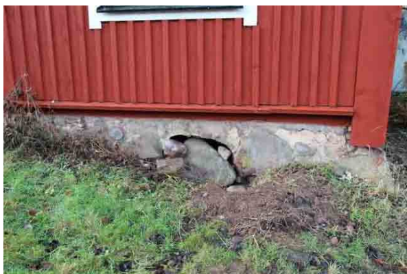
Bild t.v. Grävlingboet under byggnaden har underminerat stengrunden.
