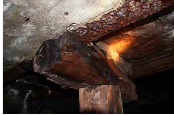
Bild t.v. sprickbildning i murverket och överliggande delar av betong.
