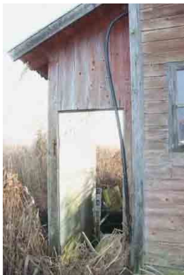
Bild t.v. byggnadsdel mot väster.
