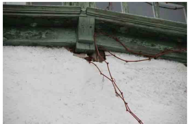
Bild t.h. Muren har fyllts i med cement där skolstenar har lossnat. Påverkar arkitekturen negativt.
