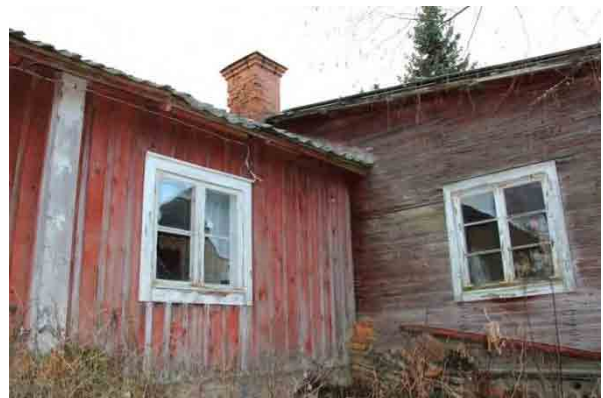
Bild t.h. byggnadsvinkel mot norr, äldre byggnads och sekundär utbyggnad.
