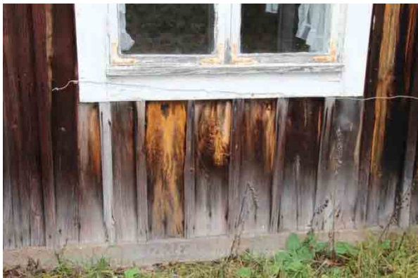
Bild t.v. sekundärt pågjutet betong på grunden bildar en hylla. Betongen gör grunden för tät.
