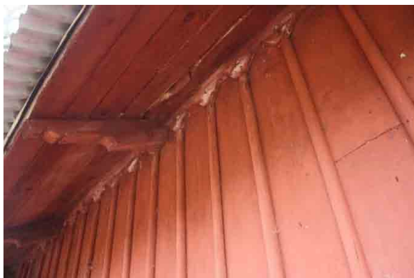
Bild t.v. dekorativ list, rundade locklister och kontursågad taktass.
