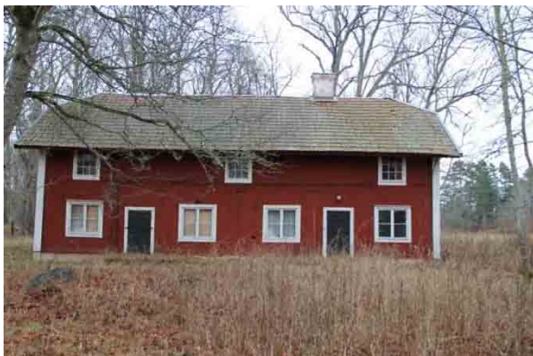
Bild t.v. västra fasaden.
