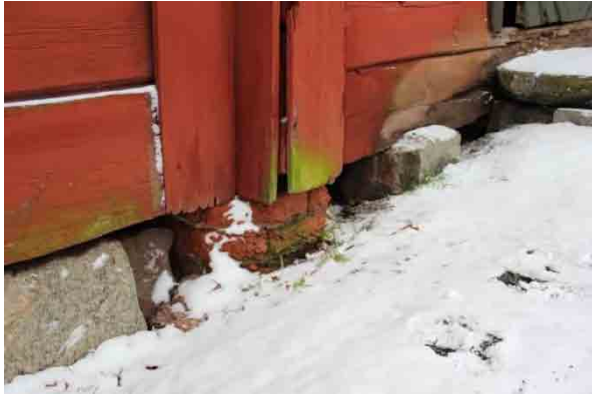
Bild t.v. plint av tegelmurverk under knutkedja i norra väggen, frostsprängda stenar. Bild t.h. skador i timmer bakom trappsten, norra fasaden.
