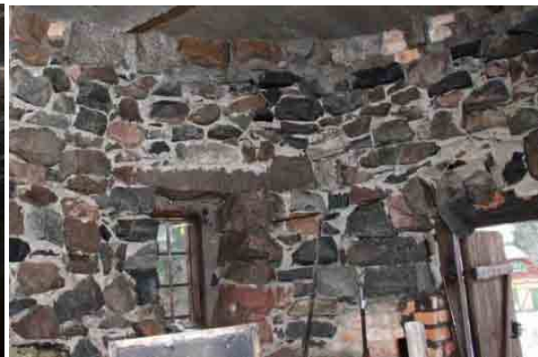
Bild t.h. Murade grunden sett från insidan. Lös sten synlig ovan dörröppning.
