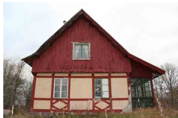
Bild t.h. Järnässtugan sedd från väster med tilläggsisolerat gavelröste med ytskikt av asfaboard och locklister. I nedre kanten av gavelröstet anas skador i asfaboarden.
