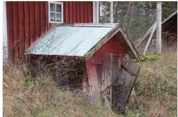
Bild t.h. Byggnaden sedd från nordväst med saknad takplåt och blottlagt undertak.
