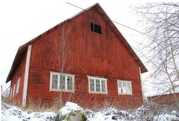
Bild t.v. västra gaveln. Bild t.h. del av norra fasaden.
