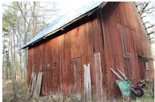
Bild t.v. nordvästra gaveln. takplåt saknas mot gaveln, fönsterglas sakas.
