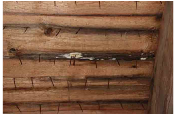
Bild t.v. rötskada med svampangrepp i norra takfallet, från insidan. Bild t.h. mindre rötskada med svampangrepp i södra takfallets östra del, från insidan.
