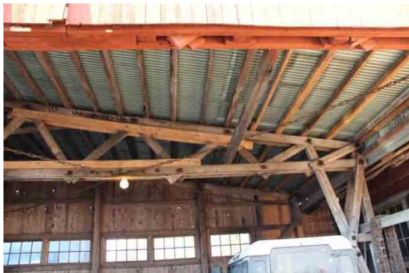
Bild t.v. takstolskonstruktion. Bild t.h. västra väggen från insidan.
