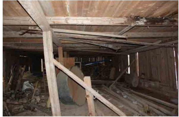
Bild t.h. interiört, stolpar kalvar åt olika håll och rötskada finns i bjälklaget.
