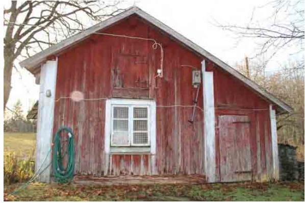
Bild t.h. Östra fasaden med vindslucka och dörr till den tillbyggda lutan. Takets åsar synliga. Panel och stomme är skadade nertill.
