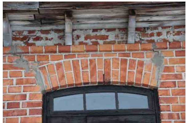
Bild t.v. östra fasaden, sprickor i hörn och äldre sprickor lagade med cementbruk.
