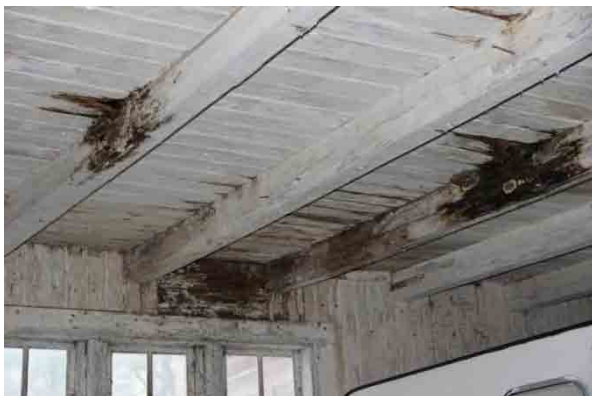
Bild t.v. rötskador i bjälklag i östra delen
