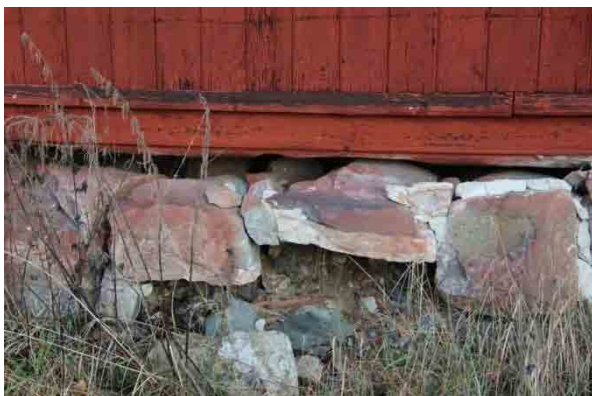
Bild t.v. Skador i grunden mot söder, ett ev grävlingbo kan ha underminerat stengrunden.
