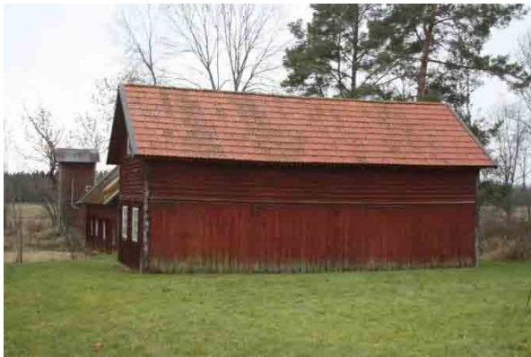
Bild t.v. norra fasaden
