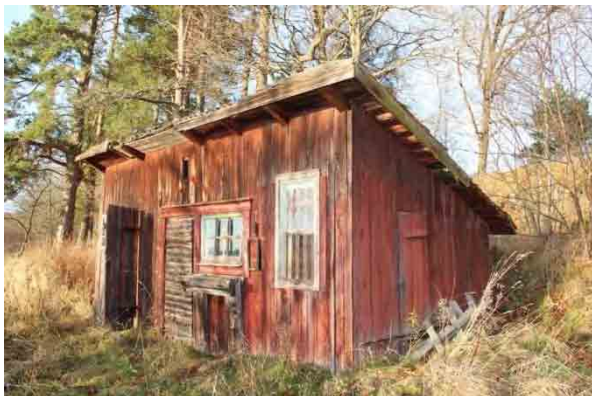
Bild t.v. södra fasaden och östra gaveln.
