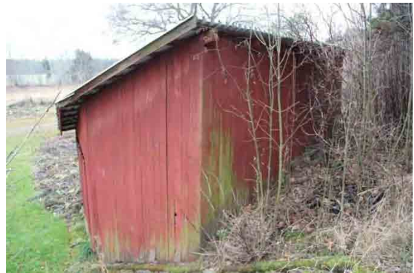
Bild t.v. Östra gaveln, fuktskadad panel och dörrar. Bild t.h. Del av östra gaveln och norra fasaden med slyppslag.
