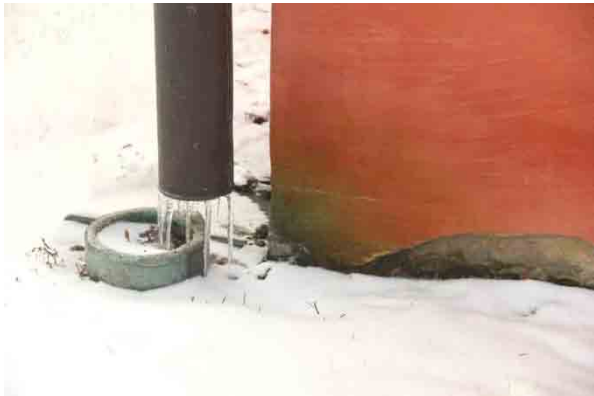
Bild t.v. Stupröret når inte riktigt markanslutningen och har felaktig placering vilket leder till fukt och alger på grunden.
