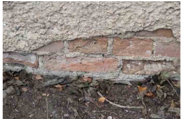
Bild t.v. östra takutsprånget med skador. Notera dekorativa detaljer i fasaden. Bild t.h. hög marknivå, putssläpp.
