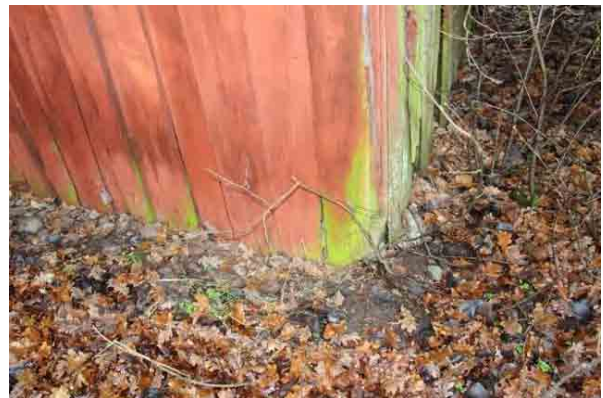
Bild t.v. norra gaveln och östra fasaden, rötskador och hög marknivå.
