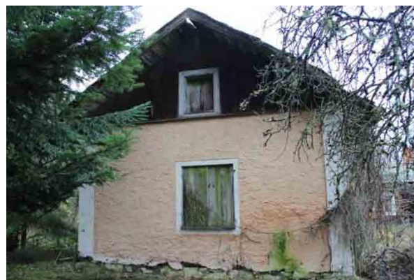
Bild t.v. sydvästra fasaden. Växtlighet och bråte inpå byggnaden. Omfattande skador i tak.
