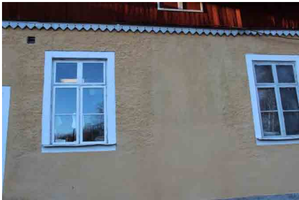
Bild t.v. putslagningar utförda med puts med avvikande sammansättning jämfört med äldre puts.
