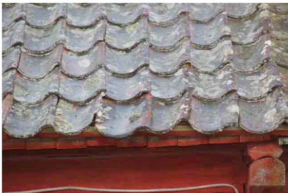
Bild t.v. Taket täcks med ett gammalt enkupigt tegel. Undertak av slätt liggande bräder. Bild t.h. Östra gaveln med utknutar.
