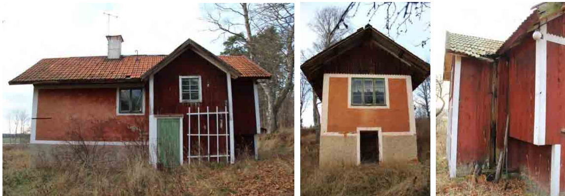
Bild t.v. östra fasaden.
