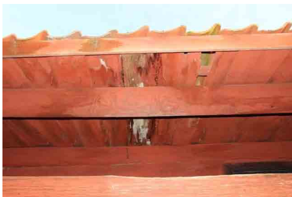
Bild t.v. Västra takfoten med rötskada.
