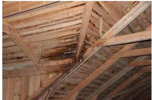
Bild t.h. interiört, stolpar kalvar åt olika håll och rötskada finns i bjälklaget.
