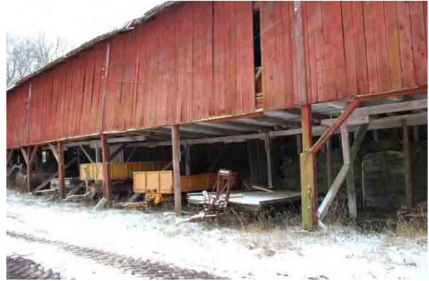
Bild t.v. grundmur med ingång till jordkällare under byggnaden. Stenarna är gröna av alger p.g.a. fukt. Bild t.h. bärlinor och strävor är borttagna
