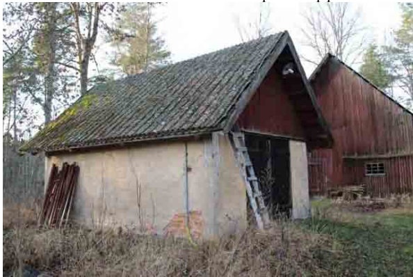
Bild t.v. nordöstra gaveln och sydöstra fasaden. Vattbrädor saknas, puts_släpp på fasaden.
