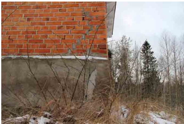
Bild t.v. östra fasaden, sprickor i hörn och äldre sprickor lagade med cementbruk.
