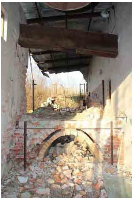
Bild t.h. Utrymme interiört i öster.
