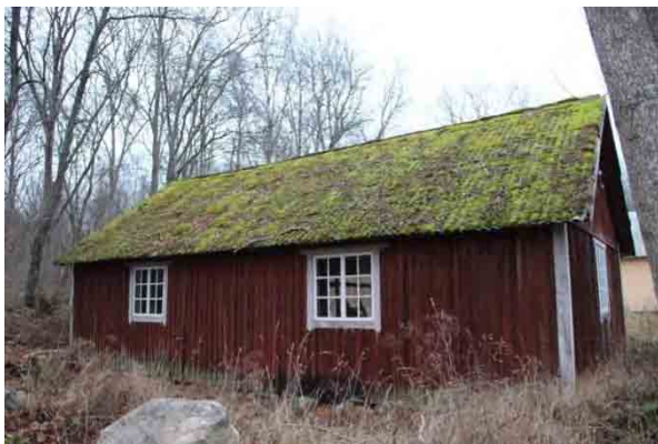
Bild t.v. västra fasaden.
