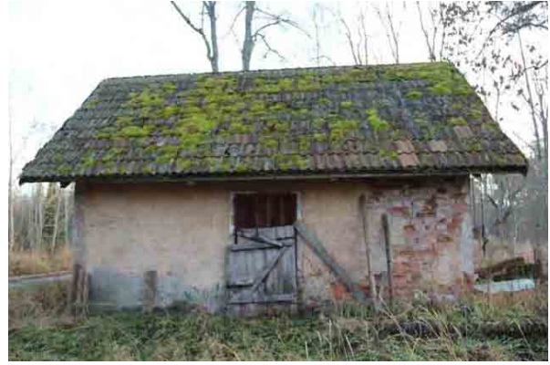
Bild t.v. nordöstra gaveln och nordvästra fasaden. Vattbrädor saknas.
