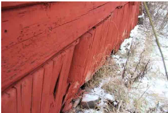
Bild t.v. stöttande kubbe under västra väggen kalvar inåt. Bild t.h. vattbräda under fönsterbågar är rötskadad.
