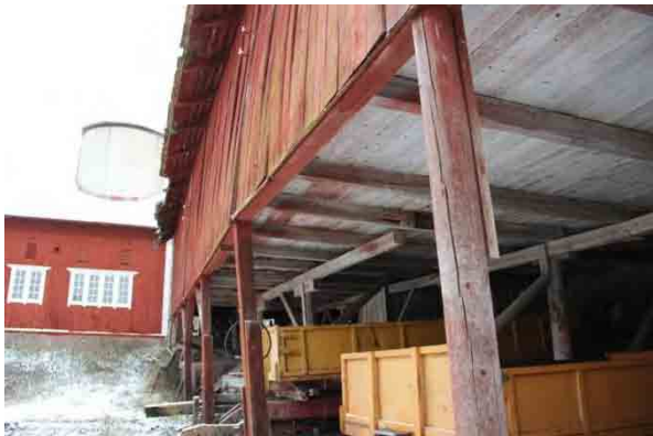
Bild t.v. bärlinor och strävor är borttagna, byggnaden kalvar. Bild t.h. bärlinor och strävor är borttagna
