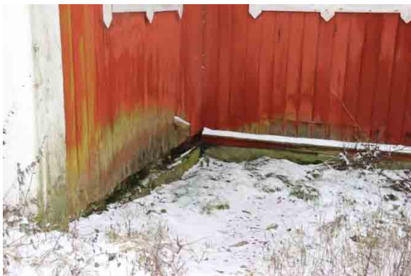
Bild t.v. rötskador nertill under takutsprång där hängrännor saknas, se bild ovan. Bild t.h. utrymme mellan byggnad 13 och 15, kraftiga fuktskador i väggen.
