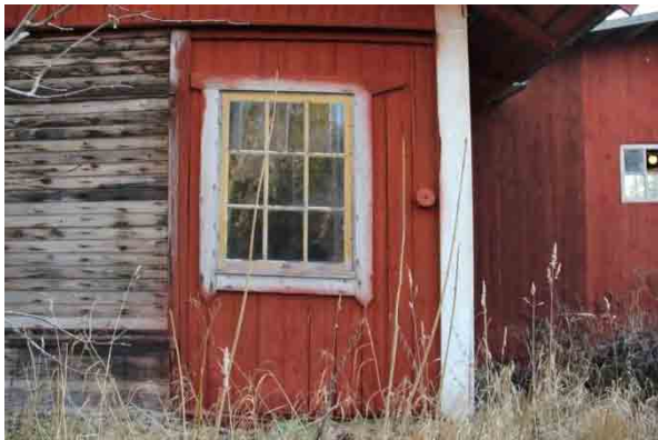
Bild t.v. sättning i sydvästra hörnet. Fönster med äldre bevarad färgsättning.
