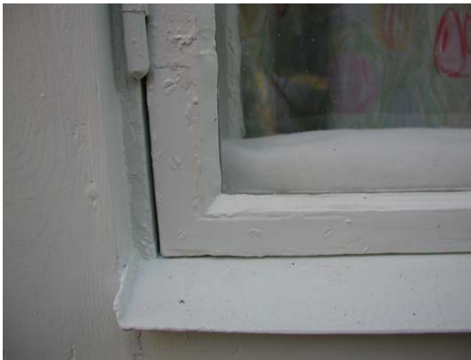
Figur 5. överst t.v. Lagning av hörnparti samt nytt hörnjärn. Digitalfoto VLM.
