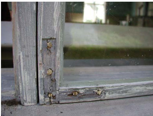
Figur 3. Skadat parti av fönsterbåge då hörnjärnet skruvats bort. Digitalfoto VLM.
