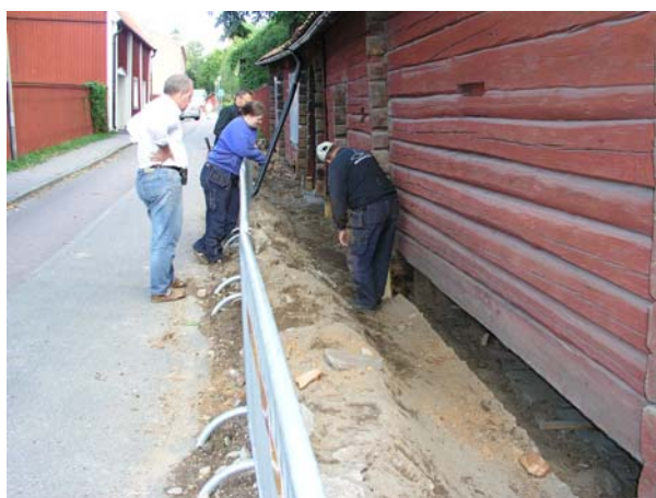
Figur 3, överst t.v. Interiörbild från utbyte av flera stockvarv vid inkörsporten. Digitalfoto: VLM. Figur 4, överst t.h. Borttagning av golv i den f.d. affärsboden i uthuslängan. Foto: VLM B103.962. Figur 5, nederst t.v. Utbyte av stockvarv mot Ablöfsgatan. Foto: Skultunabyggen. Figur 6, nederst t.h. Utbyte av stockvarv mot Ablöfsgatan. Foto: Skultunabyggen.
