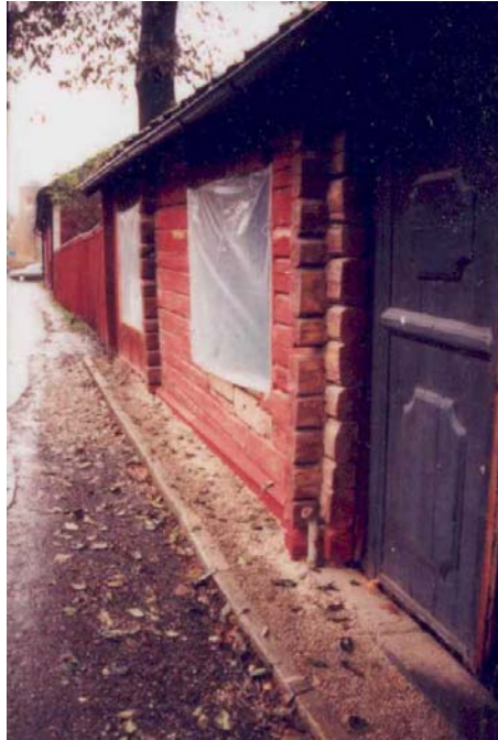
Figur 11, t.v. Fasaden mot Ablöfsgatan mot sydväst, efter utbyte av syllstockar. Marken utmed byggnaden är dränerad och grusad. Asfalten borttagen utmed byggnaden. Foto: VLM B103983:34.
