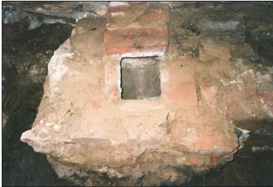
Figur 8. Detalj av muren med ventilationshålet där den kalla källarluften strömmade upp (foto U. Alström).
