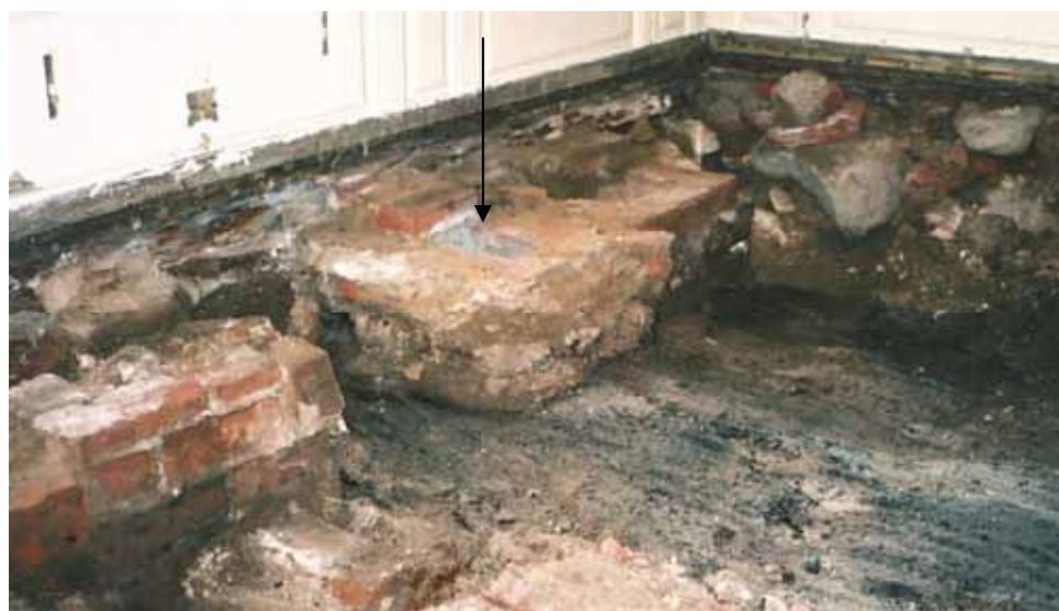
Figur 7. Del av muren med en av luftkanalerna markerad med en pil (foto U. Alström).
