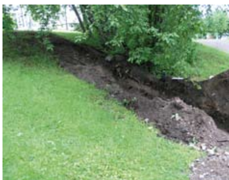
Figur 6. Den västra delen av schakt 3 togs upp i en kraftig östsluttning. Fotograferat från sydost. Foto: Anna-Lena Hallgren, VLM.
