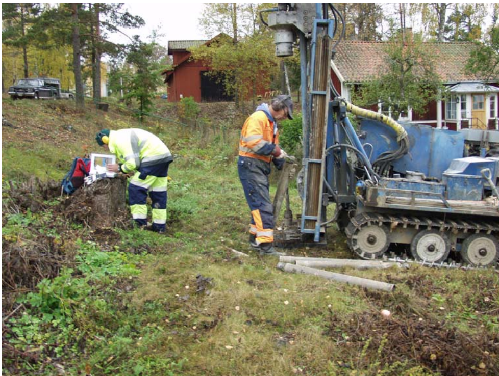
Figur 7. Arbetsbild. Borrningen vid GV15 framför Knechtschaket. Fotograferad av Anna Lihammer, oktober 2006.
