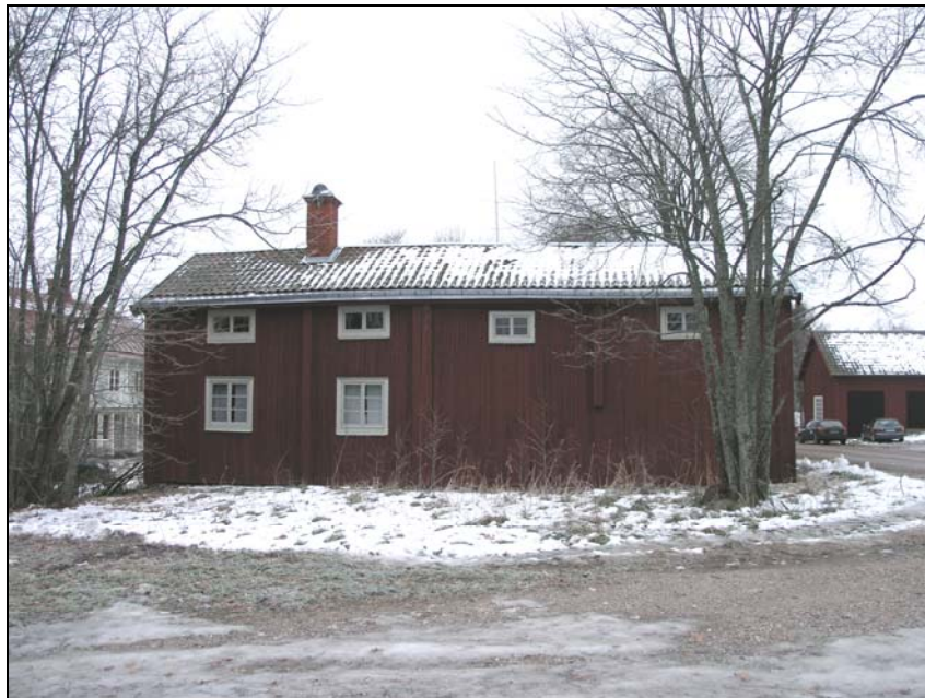
Figur 13 .Överst: Östra fasaden efter renoveringen. Foto: Kulturmiljövård Mälardalen.
