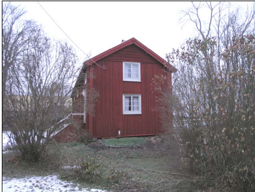
Figur 15. Överst: Skarvning av panel på den östra fasaden. Foto: Kulturmiljövård Mälardalen.
