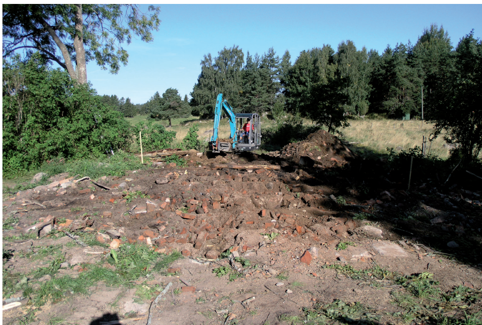
Figur 2. Schaktning inför uppförandet av det nya huset. Stora delar av den höjd på vilken huset är planerat visade sig vara uppbyggd av fyllnadsmassor i form av tegel och grundstenar. På krönet av höjden återfanns stora mängder raseringsmassor från en rivet byggnad. Fotograferat från söder. Foto: Joakim Kjellberg.
