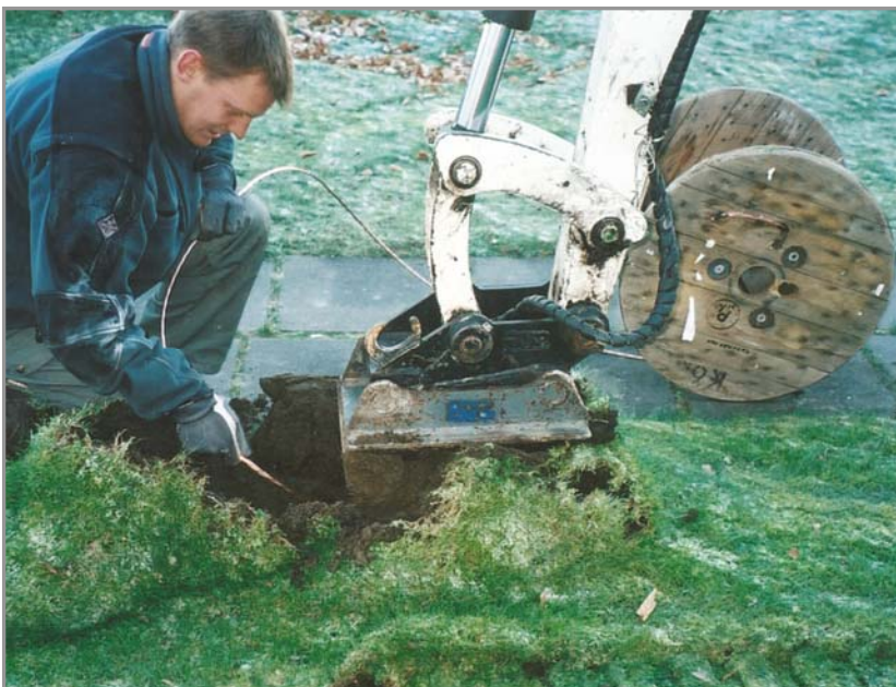
Figur 11. Kabelplöjning vid Kolbäckes kyrka (foto Ulf Alström).
