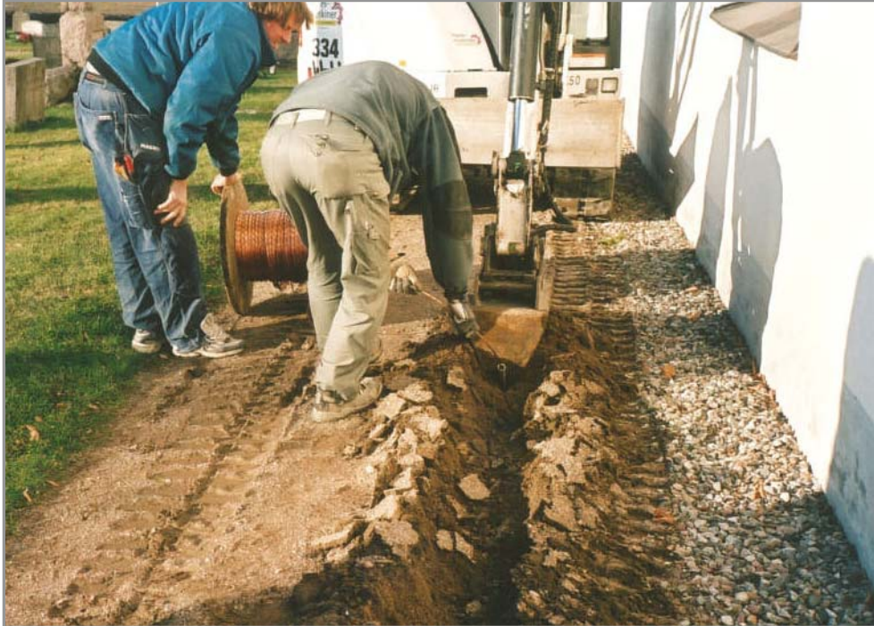
Figur 10. Nedläggning av kabeln med hjälp av tjälkrok vid Kolbäck kyrkas södra vägg (foto Ulf Alström).
