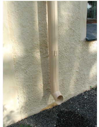
Figur 40, rad två t.b: Ny takavvattning i koppars på tornet. Digitalfoto VLM.
