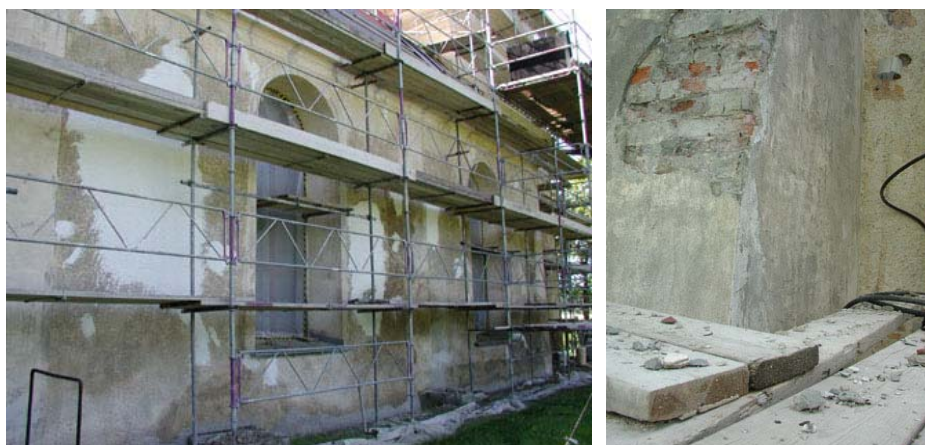
Figur 35. Putslagning på norra sidan. Digitalfoto VLM.
