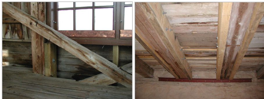
Figur 26. Förstärkning av konstruktionen under fönster i lanterninvåningen. Man har även satt ett kopparbleck i fönstret. Digitalfoto VLM.
