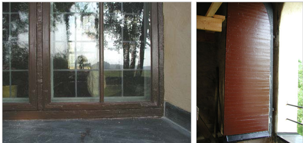
Figur 31, rad ett t.v: Ommålade fönsterbågar och karmar. Digitalfoto VLM.
