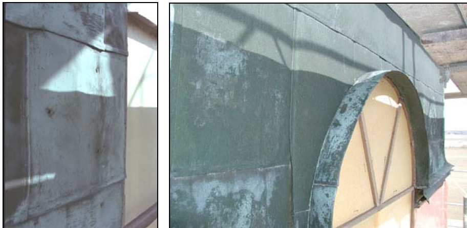
Figur 16. Detaljbild enkelfalsning av äldre kopparplåt på lanternin. Foto VLM 104115:13.
