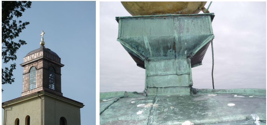
Figur 20. Lanterninen omtäckt med ny kopparplåt samt korset nyförgyllt. Digitalfoto VLM. Figur 21. Äldre koppartäckning direkt under korset och kulan på lanterninen. Foto Oscar Mässing.
