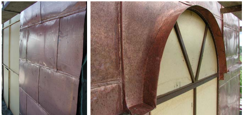
Figur 22. Detalj av falsning av ny kopparplåt på lanternin. Digitalfoto VLM. Figur 23. Ny koppartäckning vid överdel fönster. Digitalfoto VLM.
