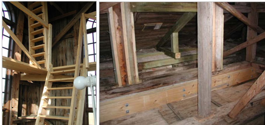
Figur 24. Nya trappor upp till lanterninens taklucka. Digitalfoto VLM.
