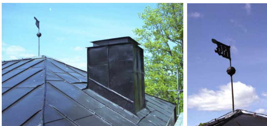
Figur 10, t.v: Omtäckt skorsten Långhusets östra del. Foto VLM 104058:7.
