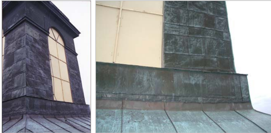
Figur 12. Äldre plättäckning på lanternin. Foto: VLM 104095:10.
