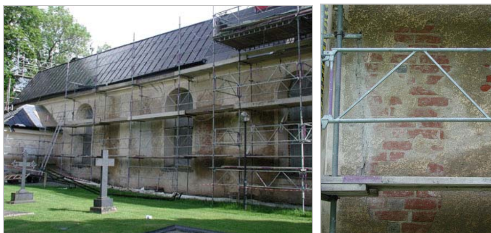
Figur 33. Nedknackning av puts på norra sidan. Digitalfoto VLM.
