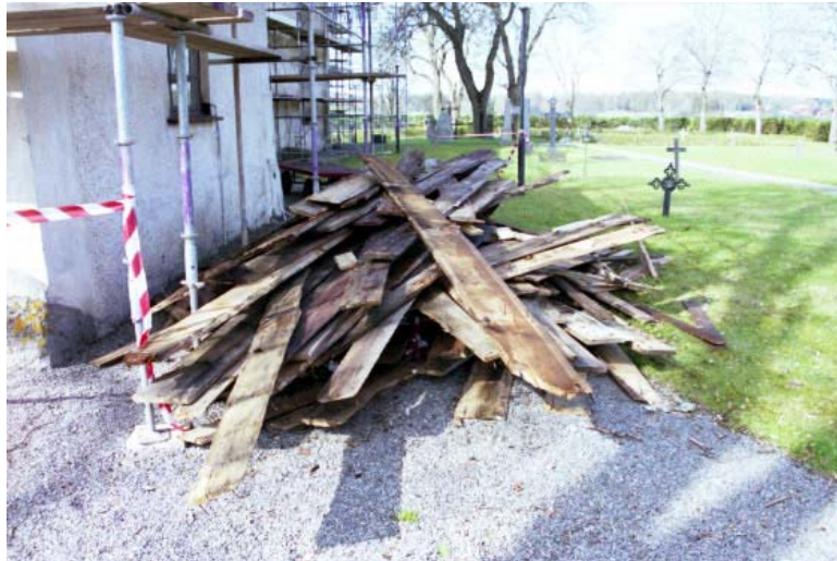
Figur 30: Bräder från det gamla undertaket. Foto VLM.
