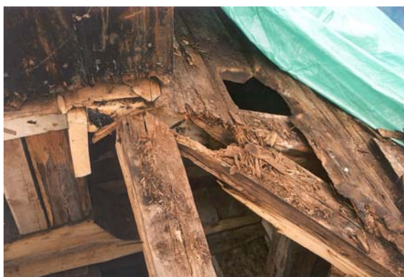
Figur 6, t.v. Rötskador i tornkransens nordöstra del. Den snedställda bjälken är helt genomrötad. Foto: KM.
