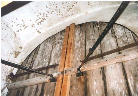
Figur 16, t.v. Förstärkning av ljudluckor i tornet. Foto: KM.
