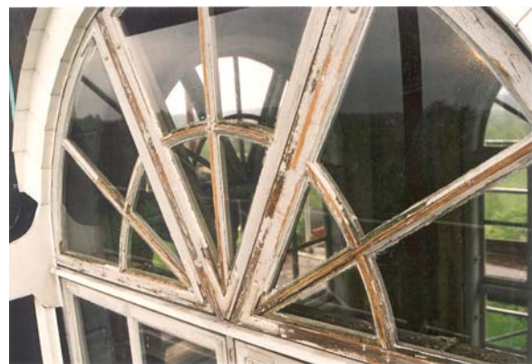
Figur 15, t.h. Karmen åtgärdad med infällt trä samt målat med linoljafärg. Foto: KM.
