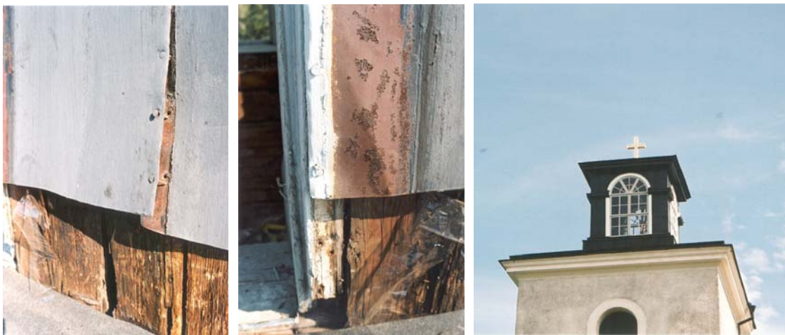
Figur 12, t.v. Äldre järnplättäckning på lanterninen fäst med klippspik. Foto: KM.
