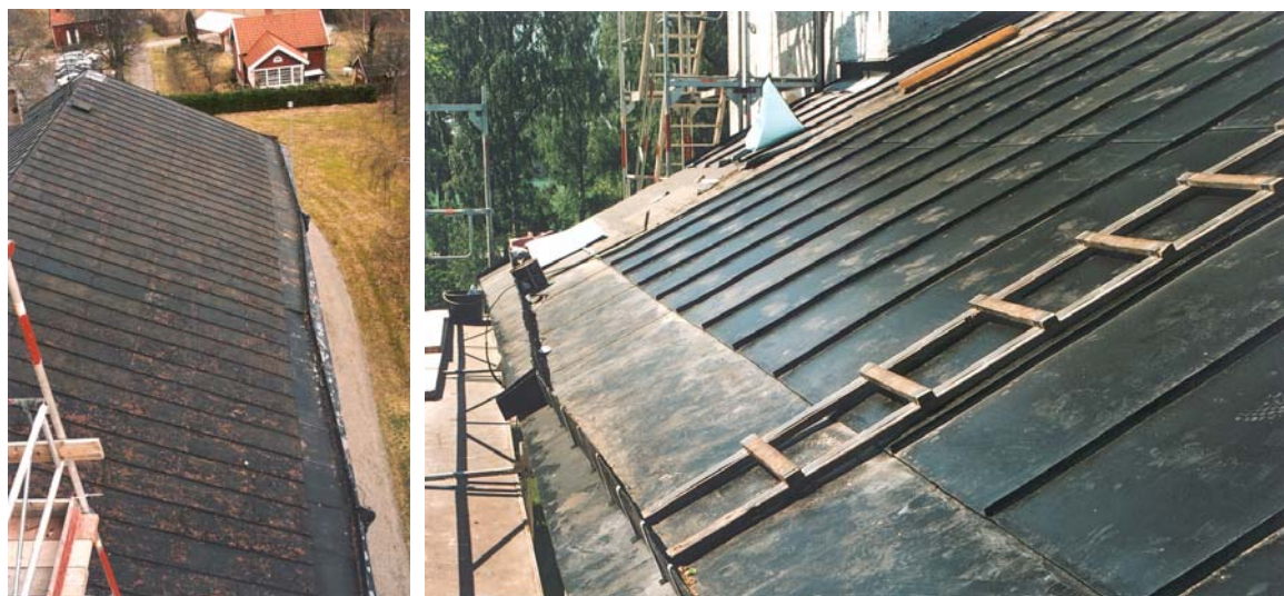
Figur 4, t.v. Taktäckningen på långhusets sydsida före omläggningen. Foto: KM.
