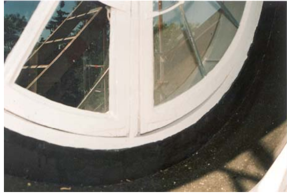
Figur 15, t.h. Karmen åtgärdad med infällt trä samt målat med linoljafärg. Foto: KM.
