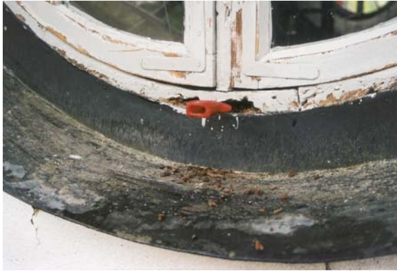
Figur 14, t.v. Svåra rötskador i nedre del av runt tornfönster. Foto: KM.
