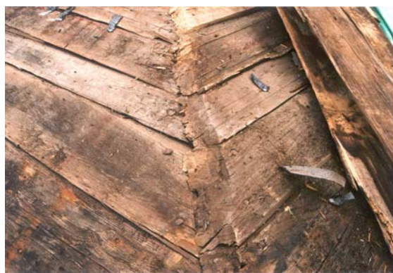
Figur 6, t.v. Rötskador i tornkransens nordöstra del. Den snedställda bjälken är helt genomrötad. Foto: KM.
