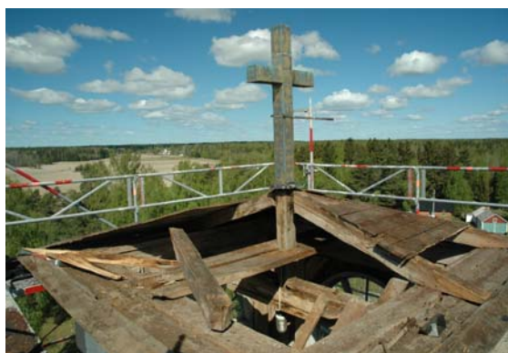
Figur 8, t.v. Tidigare provisoriska åtgärder med papp för att skydda stammen under tornkransen från läckage. Foto:KM.
