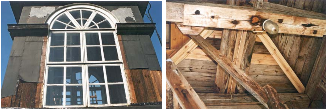
Figur 10, t.v. Äldre plättäckning på lanterninen. Under gesimsen finns en äldre svartplåt och över en nyare galvad plåt. Foto: KM.
