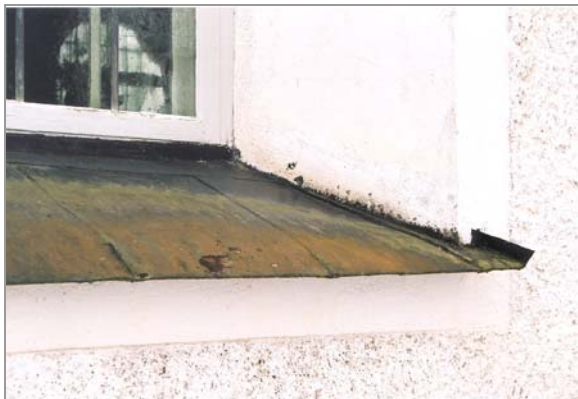
Figur 18, t.v. Rostskadade solbänkar i gammal järnplåt. Foto: KM.
