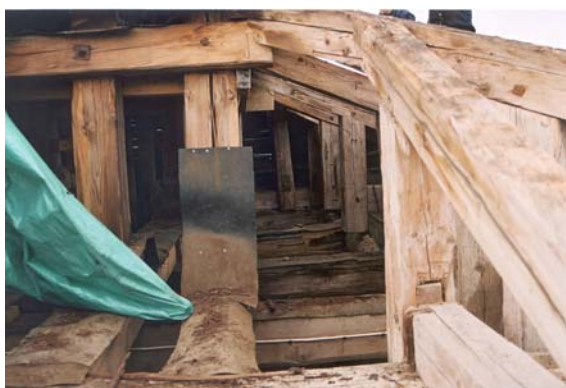
Figur 8, t.v. Tidigare provisoriska åtgärder med papp för att skydda stammen under tornkransen från läckage. Foto:KM.
