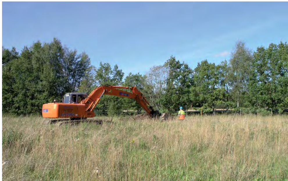
Figur 4. Anna Lihammer övervakar när grävmaskinen skiktvis gräver bort matjorden för att få fram den orörda marknivån med anläggningar. Fotograferat från söder. Foto: Maud Emanuelsson.
