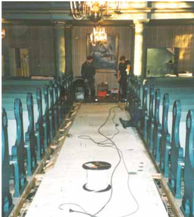
Figur 10. Kabelarbete inne i Malma kyrka. Delar av golvet borttaget efter bänkkvarteren inför kabeldragningen (foto Ulf Alström).
