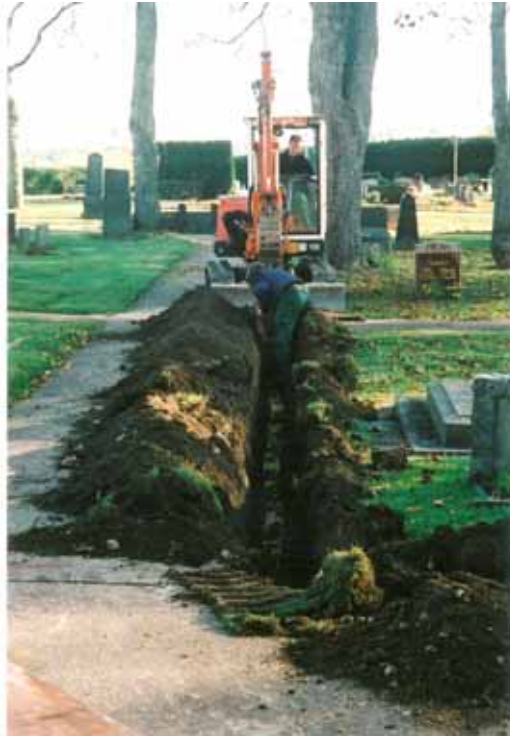
Figur 6. Grävning för elkabel öster om sakristian, oktober 2006 (foto Ulf Alström).
