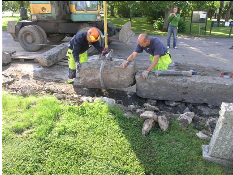
Figur 5. Inpassning av stenblocken på den södra muren.
