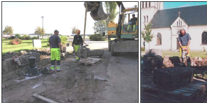
Figur 7. Arbete med stenläggning.
