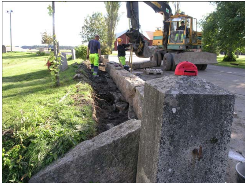
Figur 6. Baksidan av stenmuren utgrävd.
