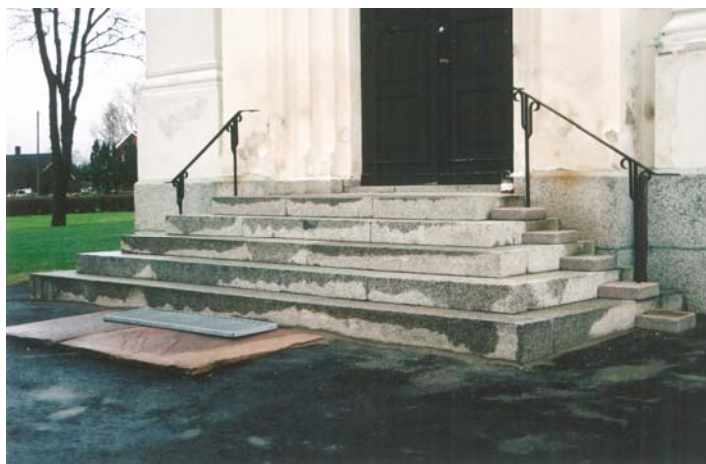
Figur 11. Trappan efter omlägningen
