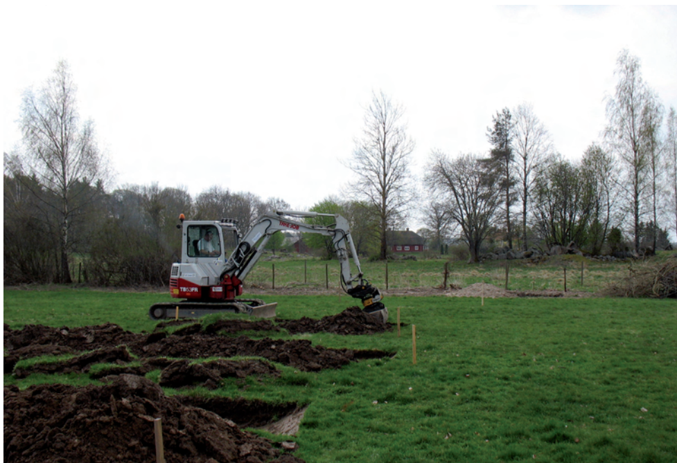
Figur 7. Med hjälp av larvbandsdriven grävmaskin upptogs sammanlagt 11 schakt. Här inom ytan för den planerade poolen. I bakgrunden syns ett rött bostadshus samt skymtas ett gult dito. De tillhör huvudgården Ullvi. Fotograferat från norr av Maud Emanuelsson.
