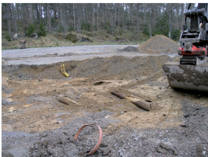
Figur 28. På etableringsplatsen hade matjorden ersatts av ett bärlager av sand och grus. Här schaktas det påförda lagret bort för att frigöra den underliggande boplatsen. Foto: Anna-Lena Hallgren, KM.
