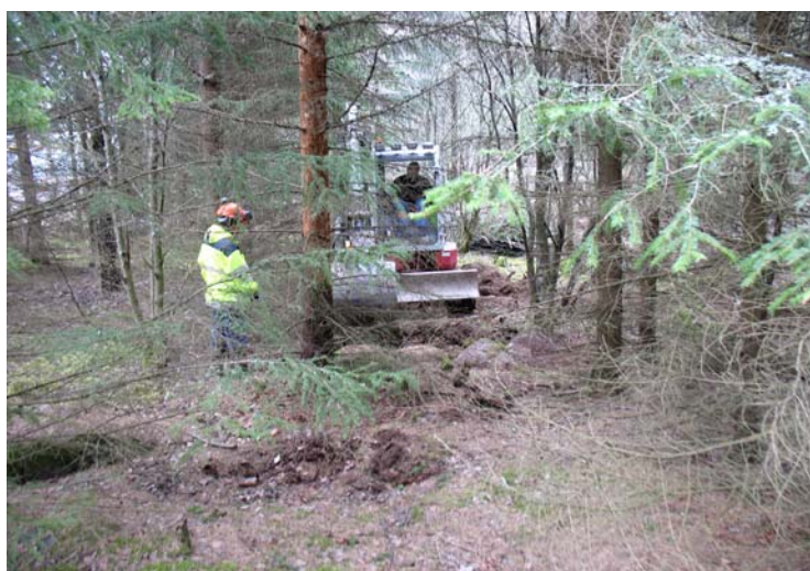
Foto 1. Schaktning i skogsmark, stensträngen friläggs. Foto Jan Ählström.
