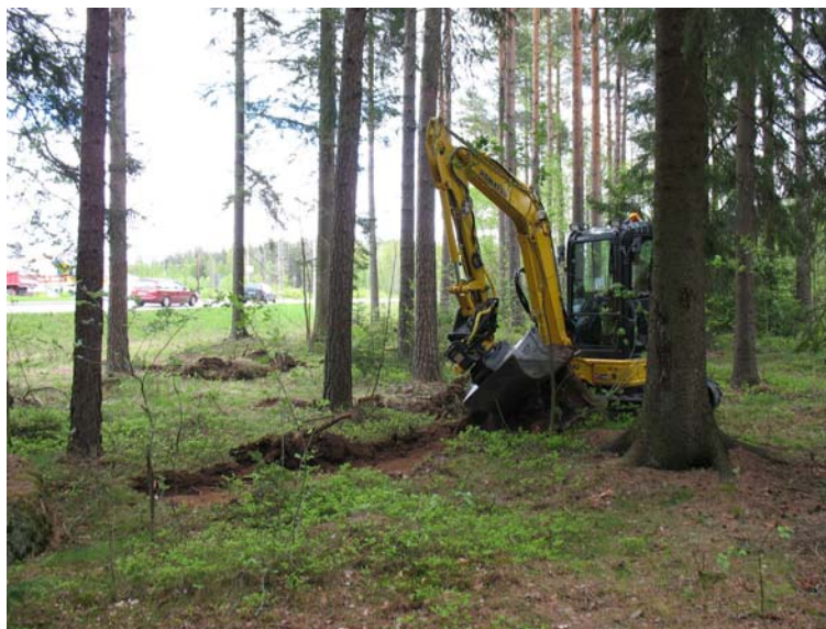
Figur 3. Schaktning i den nordöstra delen av ytan, rondellen vid ICA-Grytan ans i bakgrunden. Foto J Åhlström.
