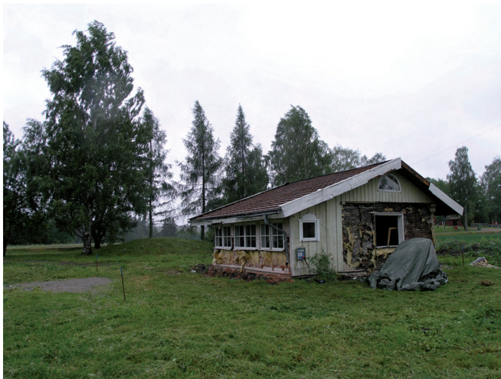
Figur 2. Undersökningsområdet låg till vänster om samt under det befintliga bostadshuset. På fotografiet är undersökningsområdet för den första antikvariska kontrollen utsatt med blåmarkerade käppar. Efter att huset nedmonterats kunde den kompletterande undersökningen genomföras. I bakgrunden syns skärvstenshögen RAÄ 506. Fotografierat från öster av Maud Emanuelsson, KM.
