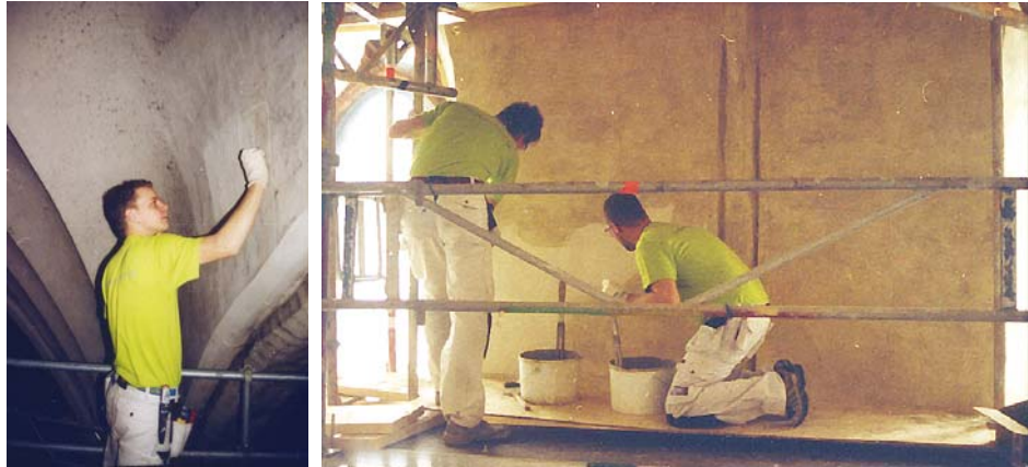
Figur 12 t.v. Rengöring med Wischabsvamp efter att ytorna dammsugits. Figur 13 t.h. Avfärgning med gotlandskalk.
