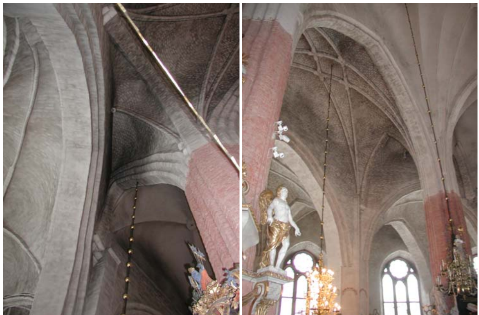
Figur 7. Valv 10 före rengöring. Figur 8. Valv 4 före rengöring.
