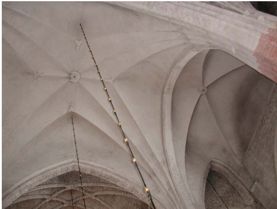
Figur 5. Valv 1 och 2 före rengöring. Som fotot visar hade dessa två valv en betydligt ljusare kulör än omgivande valv.
