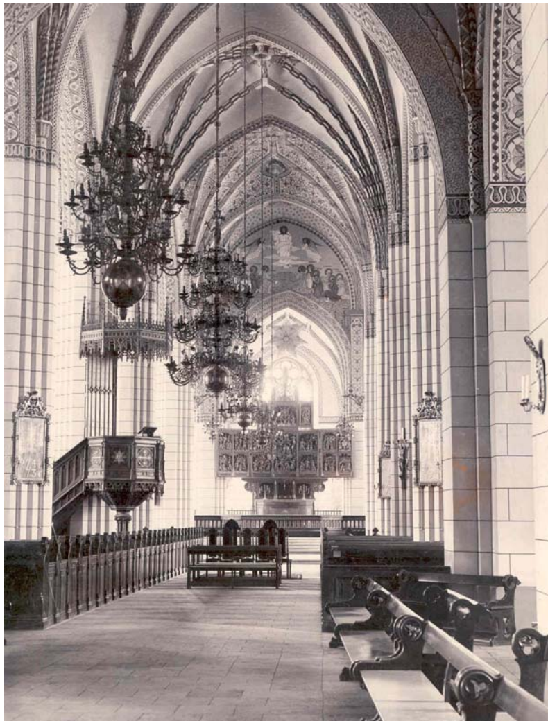
Figur 4. Västerås domkyrka under tidigt 1900-tal, efter Agi Lindgrens renovering. Såväl valvribbor som pelare och gördelbågar är dekorationsmålade, liksom valven över koret. Foto i VLM arkiv.
