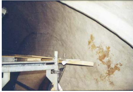
Figur 16 t.v. Missfärgning av puts i valv 13.
