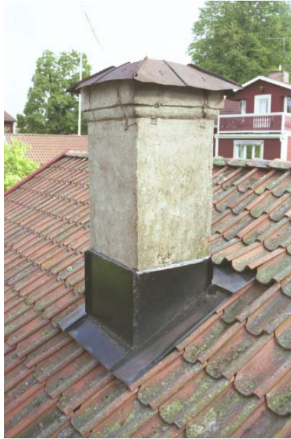
Figur 12. Skorsten med delvis äldre beslag samt omtäcket tak. Foto: Anders Eriksson, VLM 104021:8.
