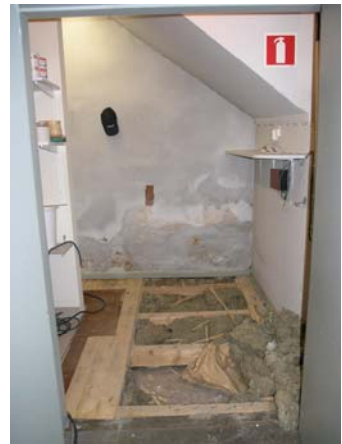
Figur 18. Dragningsarna av nya ledningar in till kyrkan gjordes genom de befintliga kanaler mellan pannrum och kyrkorum som tillkommit vid renoveringen 1904.
