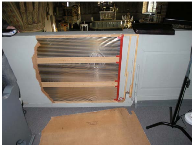
Figur 5. Borttagning av masonite på läktarens baksida. Bakomliggande värmeslingor.
