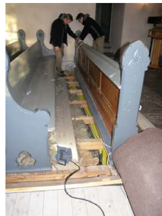
Figur 6. Den gamla plastsöckeln framför eldragningarna byttes mot en i trä.
