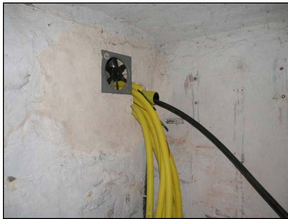
Figur 14. Nyupptaget bål i sakristians grund för inkommande rör för el till källaren under sakristian.
