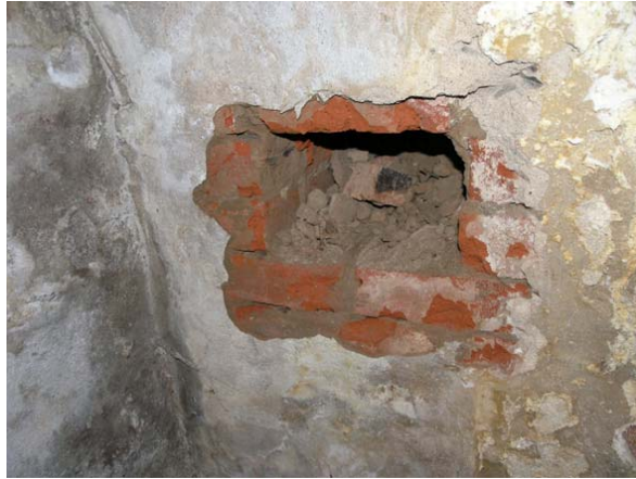
Figur 16. Upptagning av hål i murstocken från källaren.
