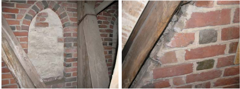
Figur 3. Tegelblindering på kyrkans västra gavel mot vilken tornet idag är byggt. Figur 4. Parti av den gamla yttermuren sedd från tornet, med åsstrukna fogar.
