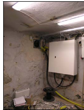
Figur 14. Nyupptaget bål i sakristians grund för inkommande rör för el till källaren under sakristian.
