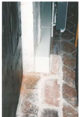
Figur 10. Upptaget tegel framför gravkoret tillbakalagt. Två tegelstenar vilka sprack vid upptagningen har bytts ut mot handslaget, återanvänt tegel.
