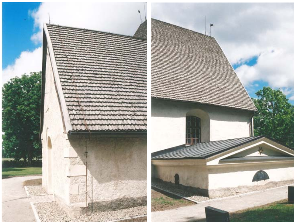
Figur 26. Ny åskledaranläggning med nedledare av koppar på vapenhusets tak.
