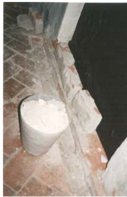
Figur 8. Upptagning av stenar i koret för ledningsdragning förbi luckan till gravkoret
