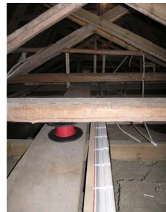
Figur 17. Nyttillkommen sockel på läktaren för att dölja nydragna ledningar.
