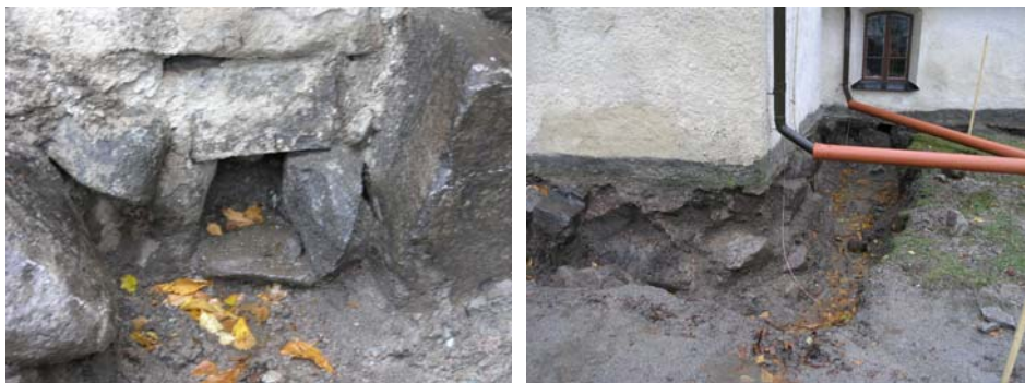
Figur 28. Äldre öppning i grunden på norra långhusväggens östra del som ev härstammar från de dräneringsförsök som gjordes under 1800-talets första hälft.
