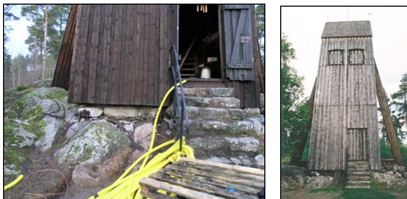
Figur 22. Indragning av kablar lagda i rör fram till klockstapeln.
