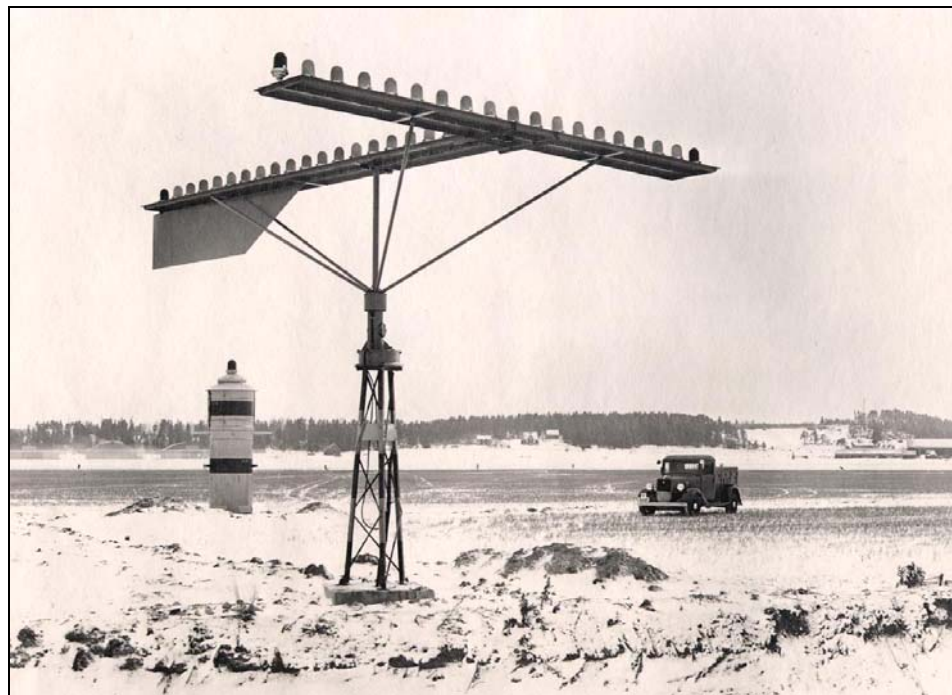
Figur 51. Vindindikator med lampor för blått ljus på Hässlö flygfäls år 1935. Foto: AGA.
