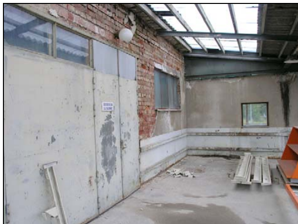
Figur 18. Lastbryggan på norra fasaden med stora putsläpp och andra skador.
