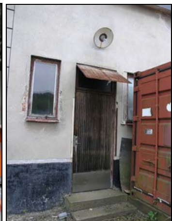
Figur 18. Lastbryggan på norra fasaden med stora putsläpp och andra skador.
