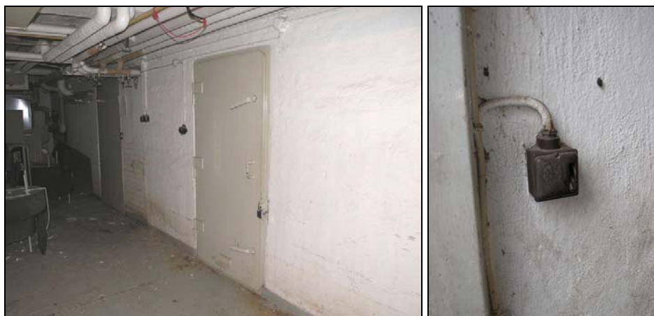
Figur 49. Dörr till skyddsrum i källarvåningen.
