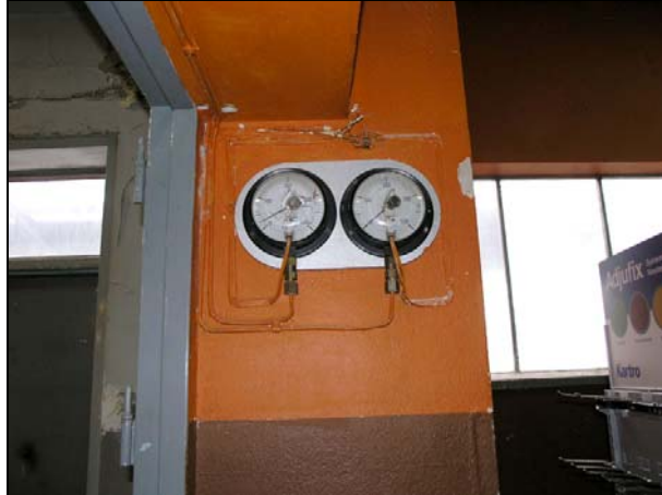
Figur 24. Tryckmättningsutrustning, placerad centralt i byggnaden, är en av få detaljer som tycks återstå av den tekniska utrustningen.
