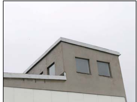
Figur 22. På södra fasaden avtecknar sig de två byggnadsetapperna tydligt. Bland annat skiljer sig takfot och takavvattning åt, men även stötfogen mellan byggnadsdelarna är tydlig.
