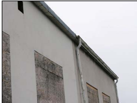
Figur 22. På södra fasaden avtecknar sig de två byggnadsetapperna tydligt. Bland annat skiljer sig takfot och takavvattning åt, men även stötfogen mellan byggnadsdelarna är tydlig.
