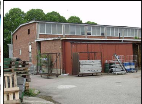
Figur 33. Södra fasadens lastbrygga med originaldörrar beklädda med karosseripanel.
