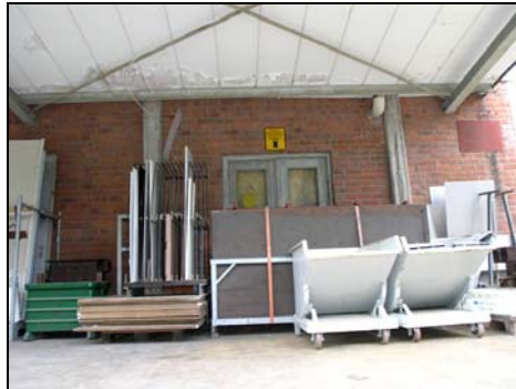
Figur 33. Södra fasadens lastbrygga med originaldörrar beklädda med karosseripanel.
