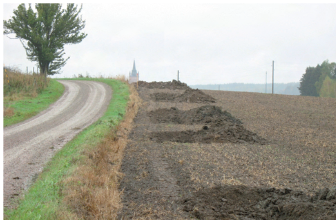
Figur 11. Det parti av delsträckan där ledningen passerar en höjdrygg på vilken bland annat gravgruppen RAÄ 33 är belägen. Fotograferat från norr. De två bilderna i figur 10 och 11 är tagna från ungefär samma ställe, på platsen för schaktet 63 (se figur 13). Foto: Anna-Lena Hallgren.
