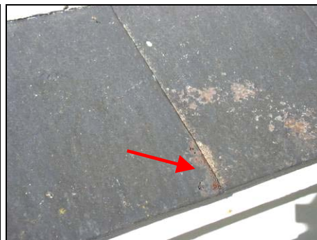
Figur 11. Plåtavtäckning under frontespis med plåtar i litet format. Foto: Helén Sjökvist.
