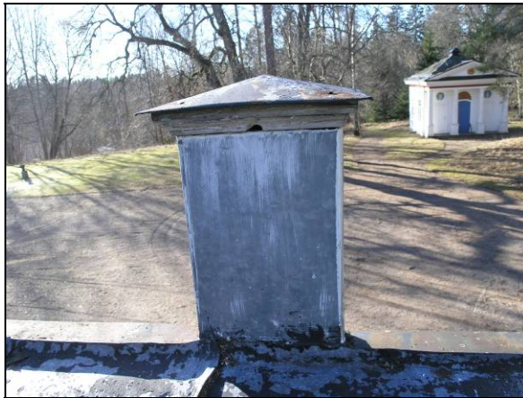
Figur 31. Då plåtintäckningen avlägsnades på några av balusterdockorna konstaterades att det på framsidan fanns spår efter att man huggit bort någon form av dekorativt element. Foto: Helén Sjökvist.
