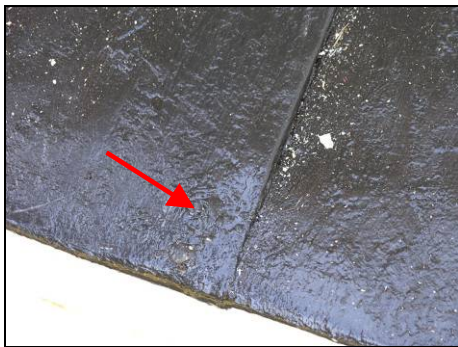
Figur 13. Pilen markerar ett av de lödda hålen. Foto: Helén Sjökvist.
