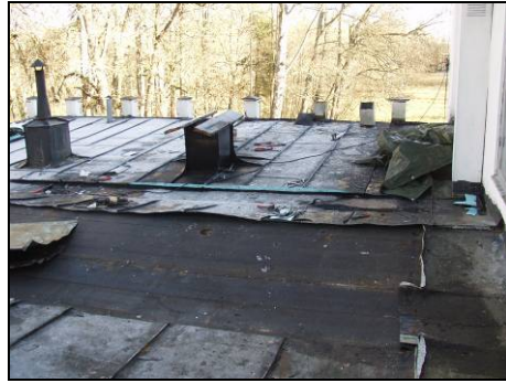
Figur 29. Ny plåtintäckning av skorsten. Foto: Helén Sjökvist.
