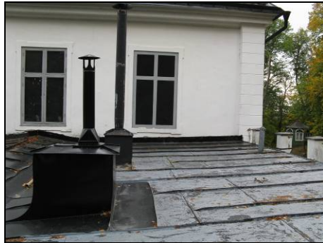
Figur 27. Ståndskeivan mot fasaden byttes under 2008 för att råda bot på läckageproblemen. Foto: Helén Sjökvist.
