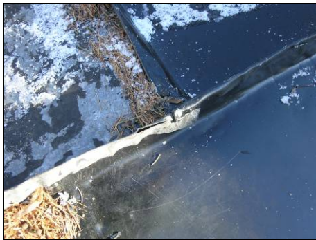
Figur 33. Spricka i fals mellan nytt och gammalt. Foto: Helén Sjökvist.
