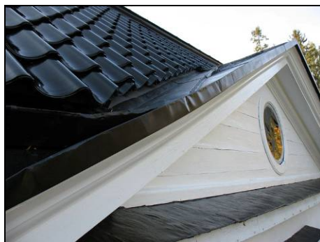
Figur 18. Ny plåttäckning på frontespisen. De avskurna tegelpannorna har fått de sågade ytorna målade med svart färg från tegeltillverkaren. Foto: Helén Sjökvist.
