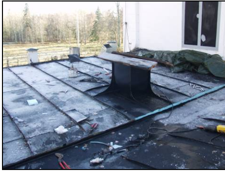
Figur 29. Ny plåtintäckning av skorsten. Foto: Helén Sjökvist.
