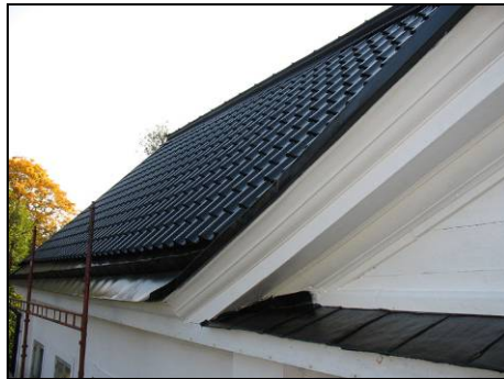
Figur 16. Taket omlagt och den nya listen inmålad tillsammans med frontespisen. Foto: Helén Sjökvist.
