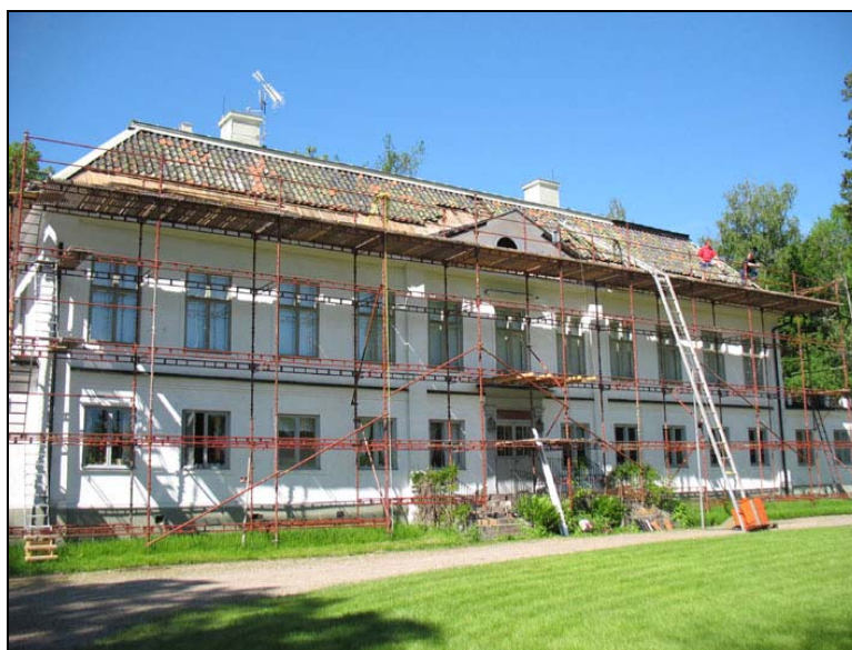
Figur 6. Bernshammars herrgård under pågående omläggning av taket. Foto: Helén Sjökvist.
