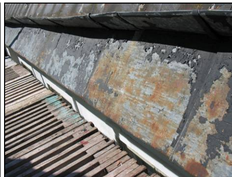
Figur 9. Plättäckningen över frontespisen före omtäckningen. Foto: Helén Sjökvist.
