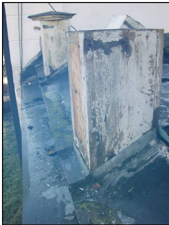
Figur 31. Då plåtintäckningen avlägsnades på några av balusterdockorna konstaterades att det på framsidan fanns spår efter att man huggit bort någon form av dekorativt element. Foto: Helén Sjökvist.
