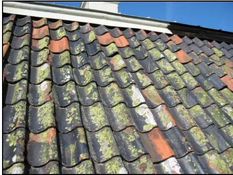
Figur 7. Taket var före omläggningen belagt med ett äldre svartglaserat tegel vilket i viss mån kompletterats med annat oglaserat handslaget tegel. Foto: Helén Sjökvist.
