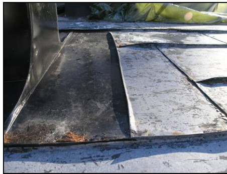
Figur 33. Spricka i fals mellan nytt och gammalt. Foto: Helén Sjökvist.
