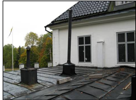
Figur 27. Ståndskeivan mot fasaden byttes under 2008 för att råda bot på läckageproblemen. Foto: Helén Sjökvist.
