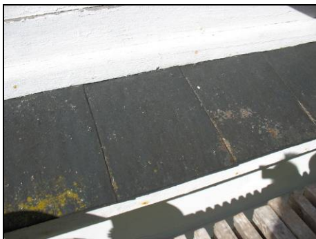
Figur 11. Plåtavtäckning under frontespis med plåtar i litet format. Foto: Helén Sjökvist.
