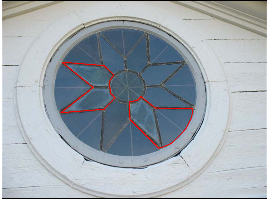
Figur 15. Det runda fönstret har genomgått en omfattande renovering. De röda linjerna markerar exempel på originalglas. Foto: Helén Sjökvist.
