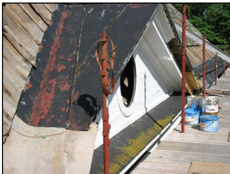
Figur 9. Plättäckningen över frontespisen före omtäckningen. Foto: Helén Sjökvist.
