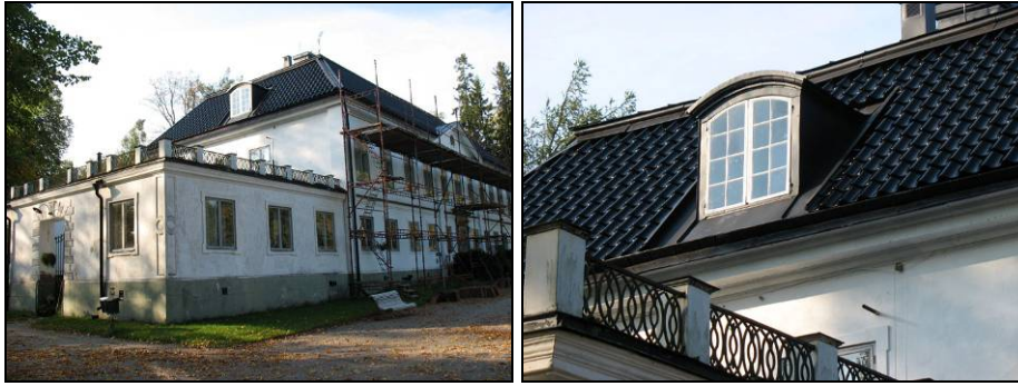
Figur 20. Västra takfallet efter omläggningen. Foto: Helén Sjökvist.
