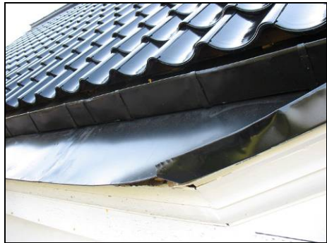
Figur 16. Taket omlagt och den nya listen inmålad tillsammans med frontespisen. Foto: Helén Sjökvist.
