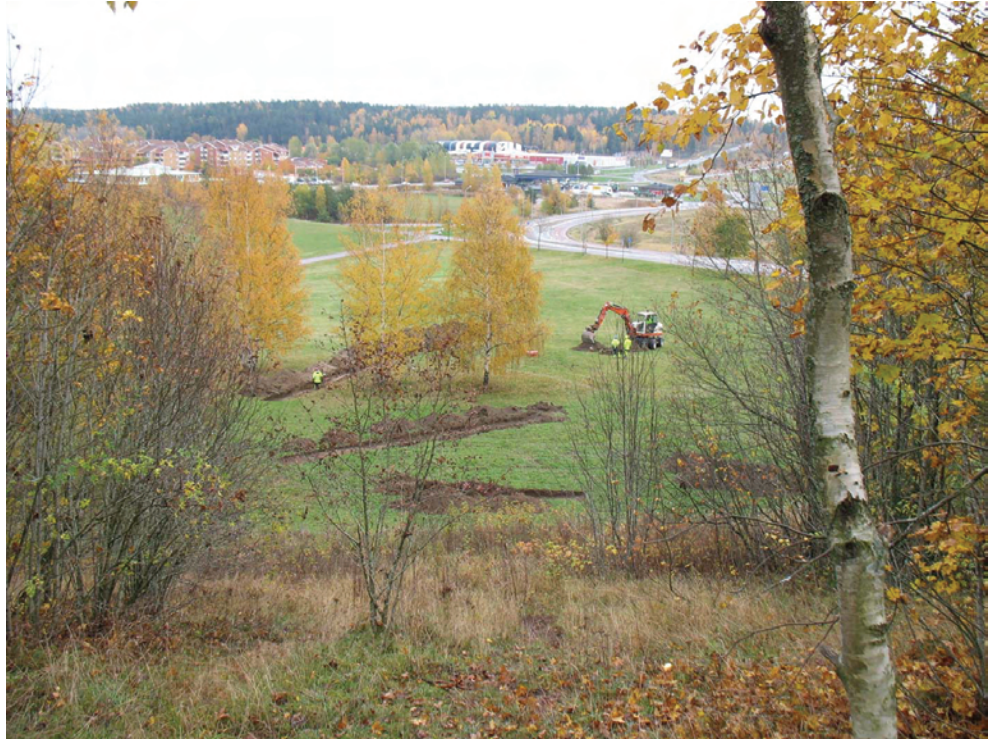
Figur 4: Vy över undersökningsområdet under schaktningen. Fotograferat av Jan Äblström från höjdpaketet i sydväst.
