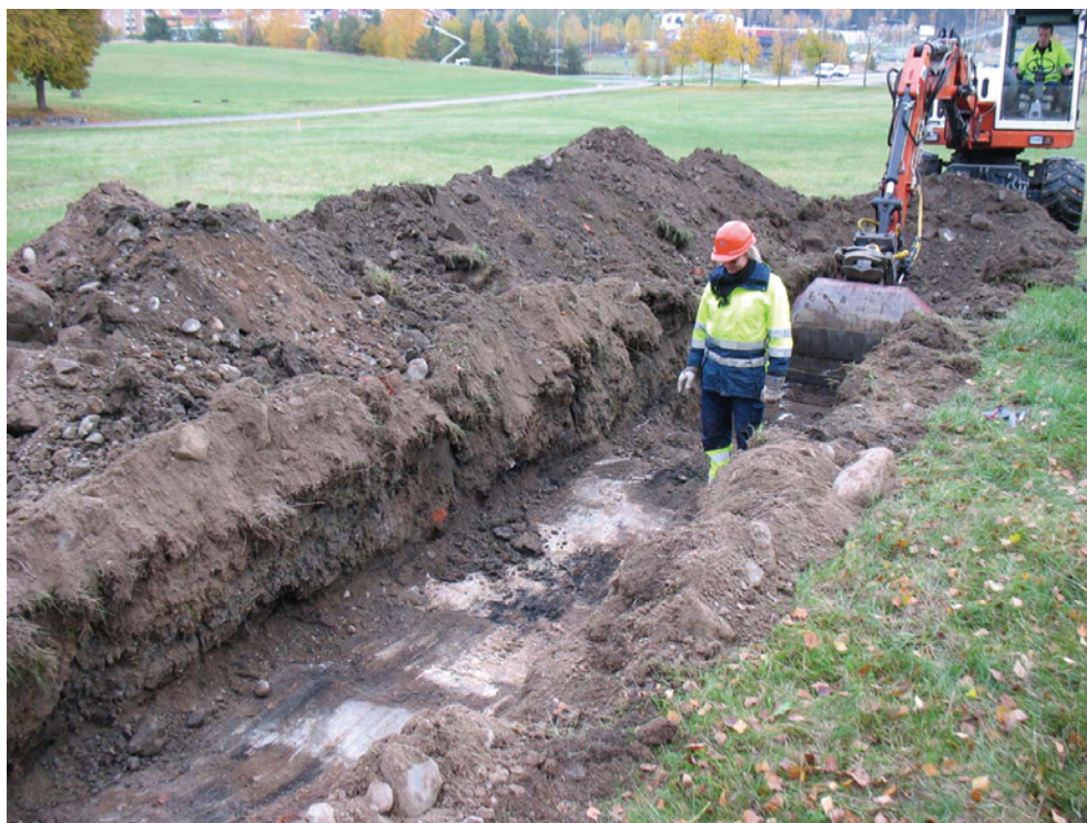
Figur 6: Kristina Jonsson stående på betonggolvet som framkom i schakt 14. Foto från SV av Jan Ablström.
