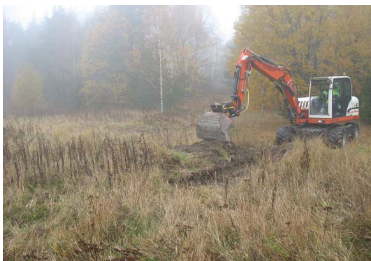
Figur 3. Schaktning i den gräsbevuxna delen av utredningsområdet. Foto J. Åhlström.
