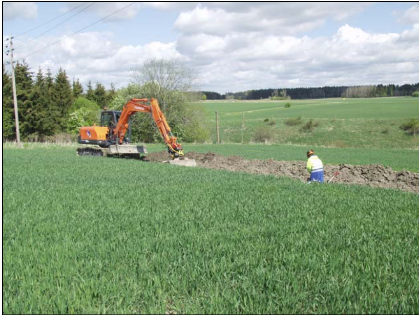
Figur 6. Schaktning av S17, fr SV. Fota A Egebäck, KM.
