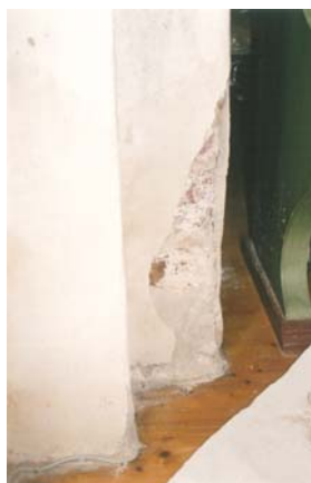
Figur 15. Putsbortfall på pelare på sydväggen. Foto: Helén Sjökvist.
