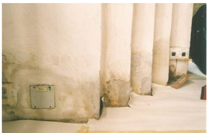
Figur 15. Putsbortfall på pelare på sydväggen. Foto: Helén Sjökvist.
