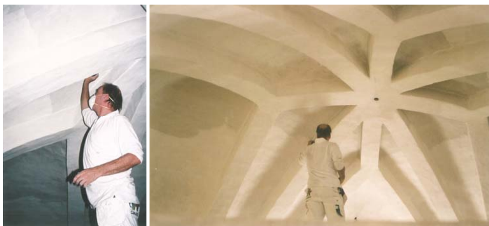
Figur 9. Rengöring av valvet i koret. Foto: Helén Sjökvist.
