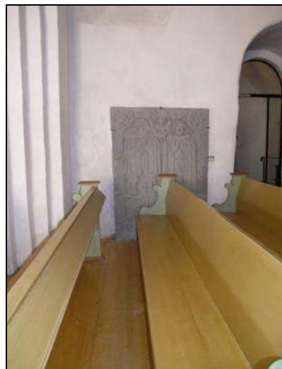
Figur 26. Fuktvandring i gravhäll på södra väggen. Foto: Helén Sjökvist.
