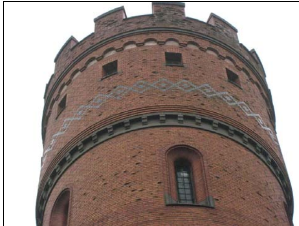
Figur 9. Tegelskadorna är omfattande. Stora frostsprängningar finns i synnerhet i tornets övre del. Foto: Helén Sjökvist.
