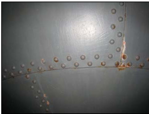
Figur 7. Den nitade cisternen med vissa rostangrepp. Foto: Helén Sjökvist.
