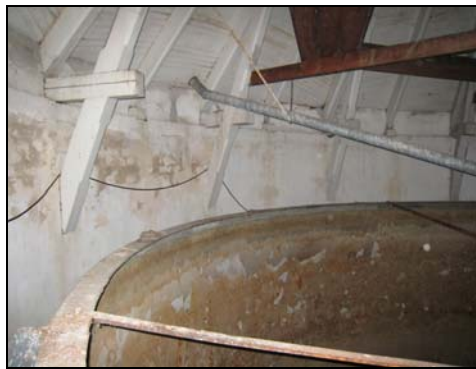
Figur 7. Den nitade cisternen med vissa rostangrepp. Foto: Helén Sjökvist.
