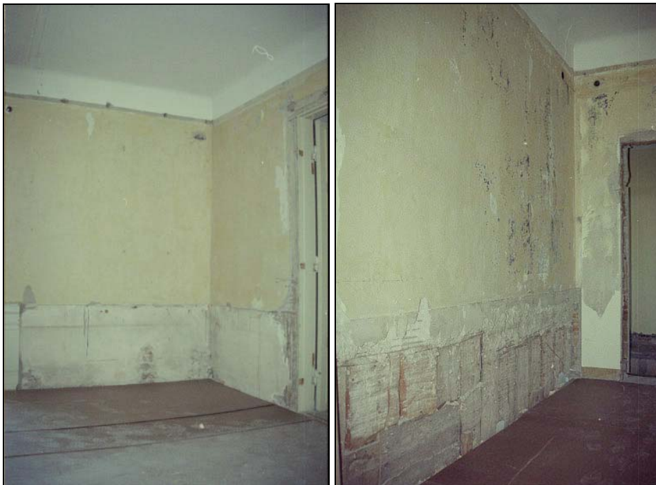
Figur 25 och 26. Pågående renovering. Nedmonterade paneler och lister. Vassmattan bakom putsen ansas. Foto: Anders Eriksson VLM 104002:7-8.
