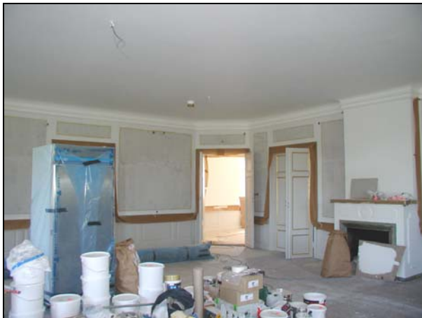
Figur 43. Pågående renovering i salongen. Foto: Anders Eriksson VLM. Figur 44. Pågående renovering i salongen. Foto: Anders Eriksson VLM.
