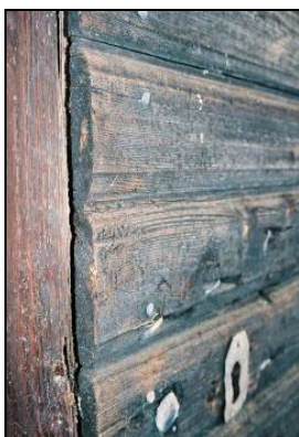
Stolperverkskonstruktionen i hus 16, vinden
