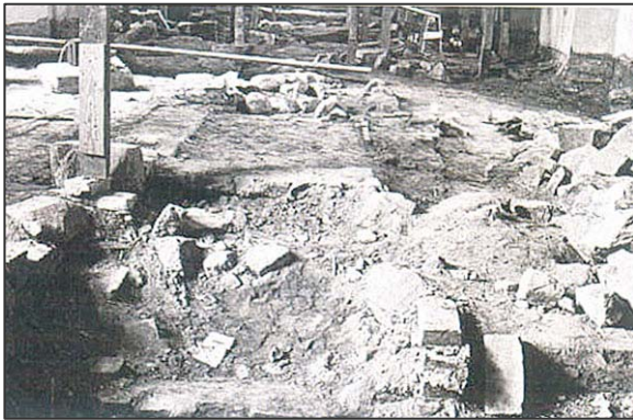
Figur 3. Bild från renoveringen av Harakers golv 1935 innan grovt grus lades på. (Foto VLM:S arkiv. Återgiven i Hammariskiöld 2004).
