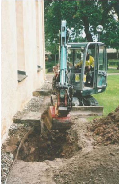
Figur 8. Schaktningsarbete vid kyrkans norra långhusvägg. (Foto U. Alström).
