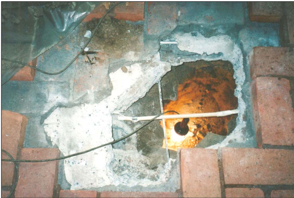
Figur 9. Provgropen i långhusets nordvästra del. Överst låg golvtegel. Därefter två lager betong. Under detta låg hård lera med enstaka benfragment. (Foto U. Alström).
