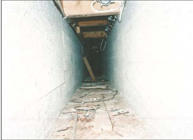
Figur 12. Gjuten kulvert i betong efter långväggen i Harakers kyrka. (Foto U. Alström).
