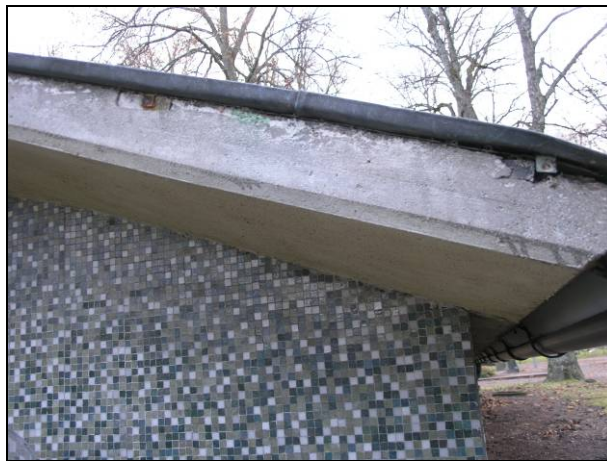
Figur 12. Infästning av takplåten mot takkonstruktionen i betong, norra fasaden. Reglarna kan anas i betongens överkant. Nederkanten är avfasad vilket ger ett bearbetat intryck. Foto: Helén Sjökvist.
