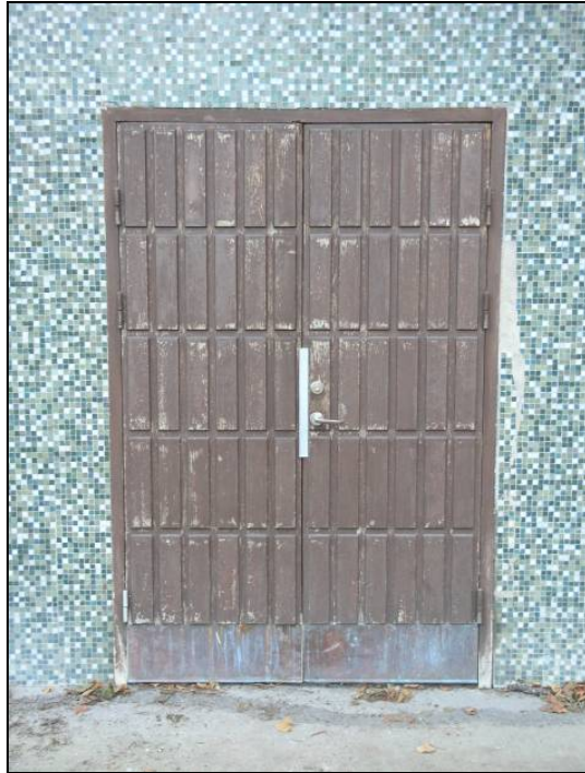
Figur 11. Entré med brunmålade dörrblad. Foto: Helén Sjökvist.
