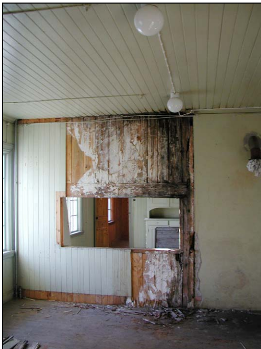
Figur 18. Svampangrepp vid serveringsluckan sett från matsalen. Figur 18. Inplastning av vägg och golv under hussvampssanering med värme vid serveringsluckan..
