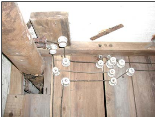
Figur 31. Exempel på äldre ledningsdragning med porslinsknoppar i källaren.
