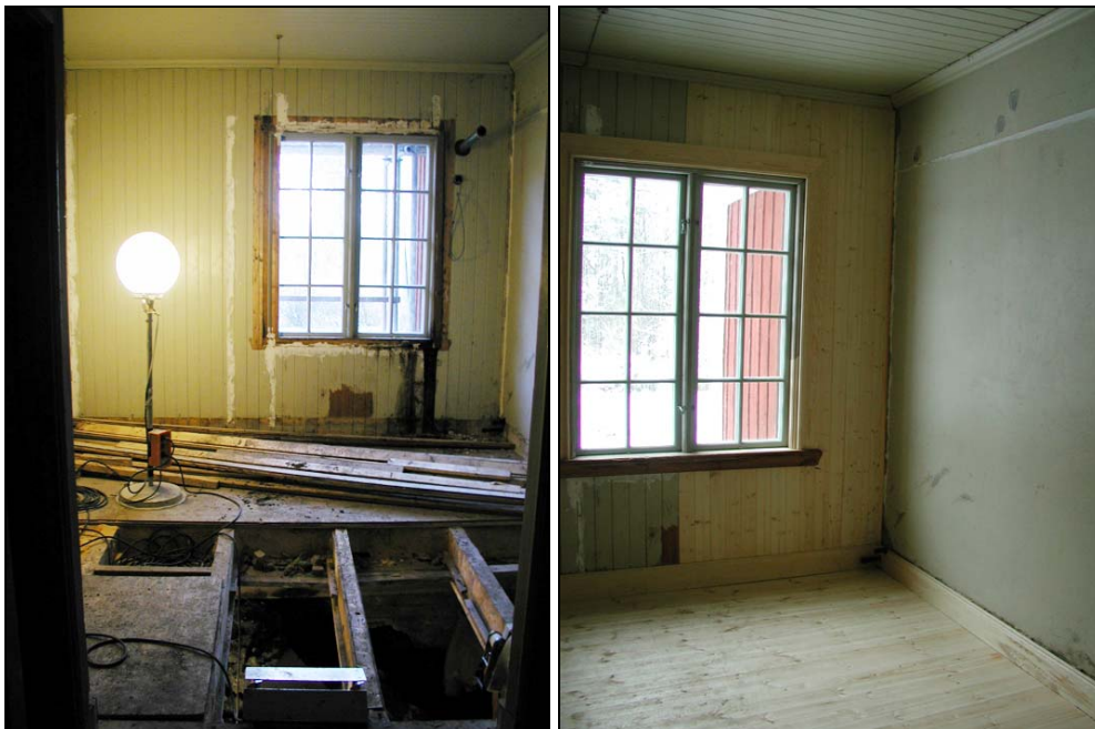
Figur 29. Upptagning av golv i det gamla pannrummet.
