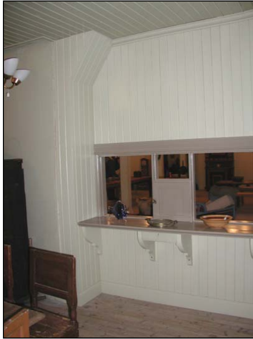
Figur 24. Panelen återställd efter bussvampssanering, sett från serveringsrum. Det spontade virket hylades upp speciellt för att få rätt bredd samt skarvades med en generalskarv i taket.
