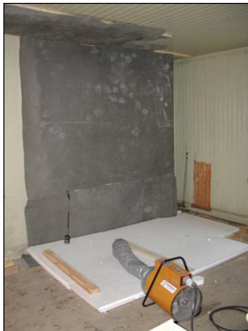
Figur 18. Svampangrepp vid serveringsluckan sett från matsalen. Figur 18. Inplastning av vägg och golv under hussvampssanering med värme vid serveringsluckan..
