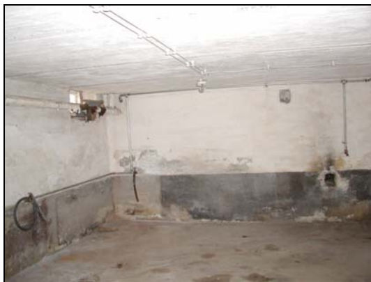
Figur 31. Exempel på äldre ledningsdragning med porslinsknoppar i källaren.
