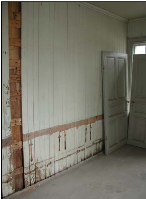
Figur 26. Rötskador i panel det gamla tvättrummet.
