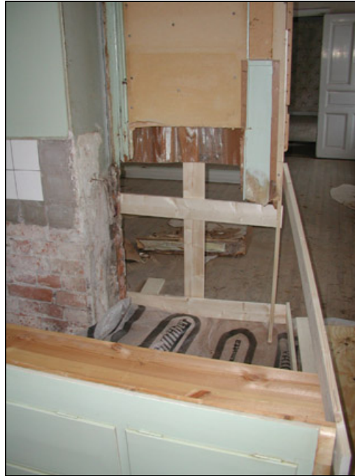
Figur 20. Inplastning av vägg och golv under hussvampssanering med värme vid serveringsluckan. Cellplasten på golvet skall isolera för att värmen skall hållas kvar i materialet.
