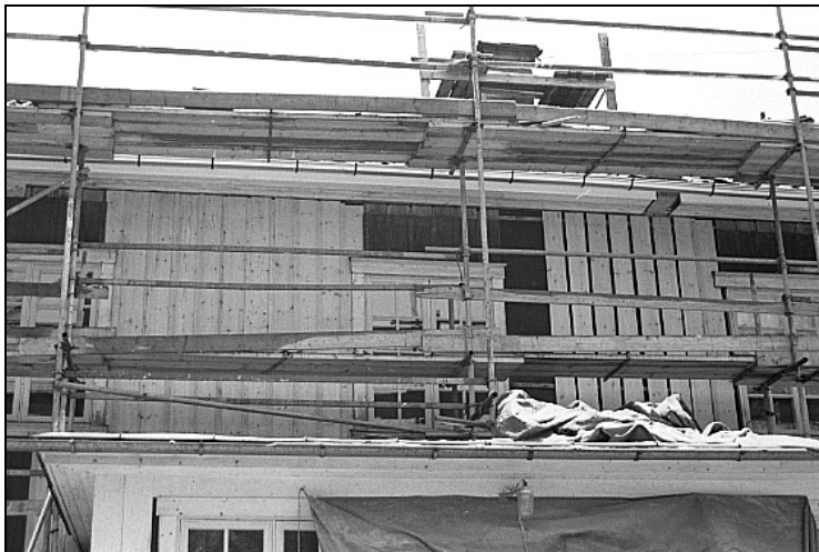
Figur 38. Panelbyte på baksidans fasad.
