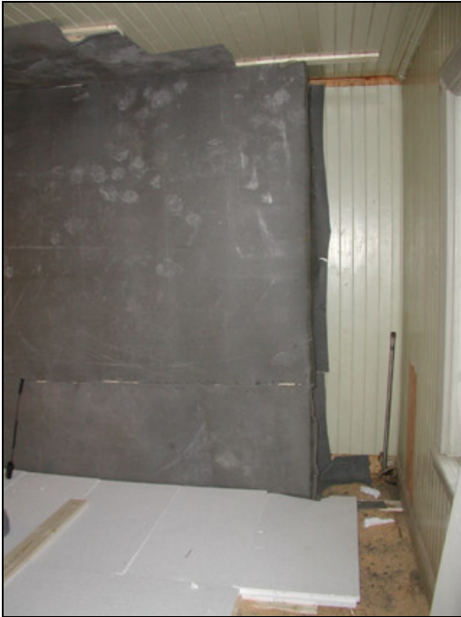
Figur 20. Inplastning av vägg och golv under hussvampssanering med värme vid serveringsluckan. Cellplasten på golvet skall isolera för att värmen skall hållas kvar i materialet.
