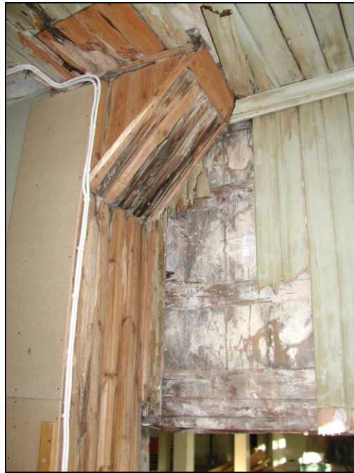
Figur 16. Hussvampssaneringen påbörjad vid serveringsluckan, sett från serveringsrummet. Figur 17. Kraftigt svampangrepp över serveringsluckan.
