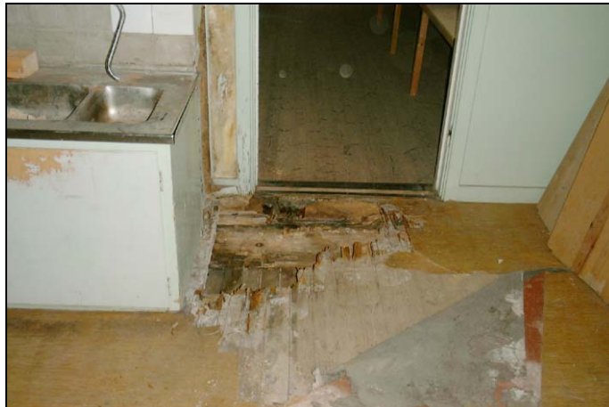
Figur 22. Hussvampssanering i övre köket. Nedre delen av väggpartiet bakom köksinredningen har kapats.
