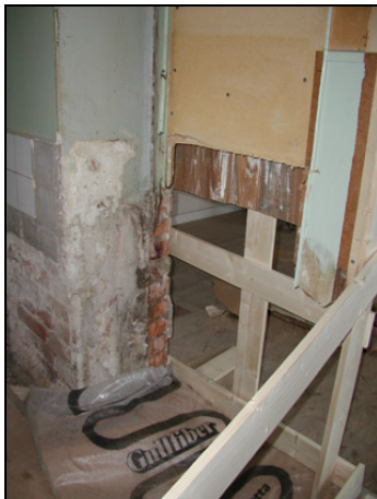
Figur 22. Hussvampssanering i övre köket. Nedre delen av väggpartiet bakom köksinredningen har kapats.
