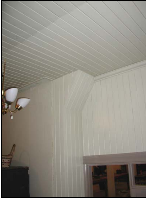
Figur 24. Panelen återställd efter bussvampssanering, sett från serveringsrum. Det spontade virket hylades upp speciellt för att få rätt bredd samt skarvades med en generalskarv i taket.
