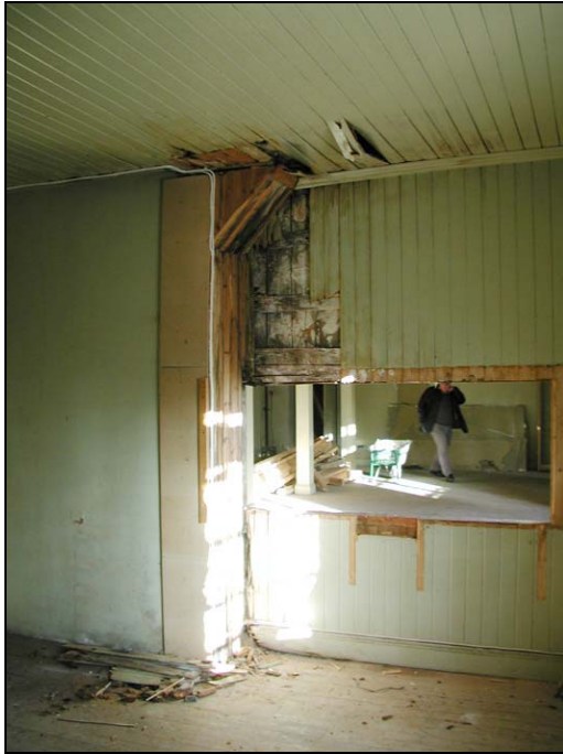
Figur 16. Hussvampssaneringen påbörjad vid serveringsluckan, sett från serveringsrummet. Figur 17. Kraftigt svampangrepp över serveringsluckan.
