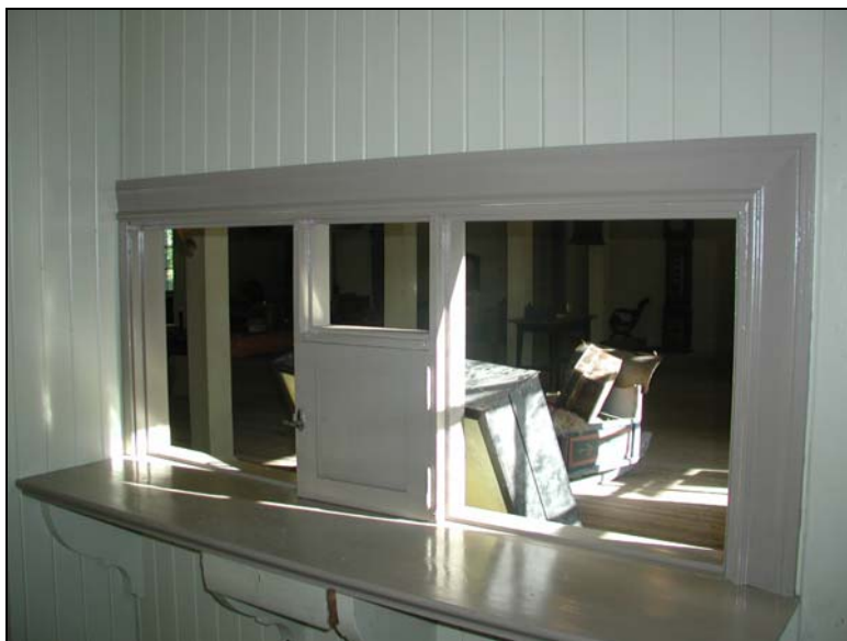
Figur 4. Serveringsluckan sanerades från hussvamp samt fick delvis nya lister.
