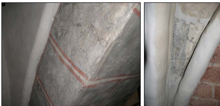
Figur 17. Travé 5 med äldre puts med kvadermålning på gördelbåge mot söder före rengöring. Foto: Helén Sjökvist.
