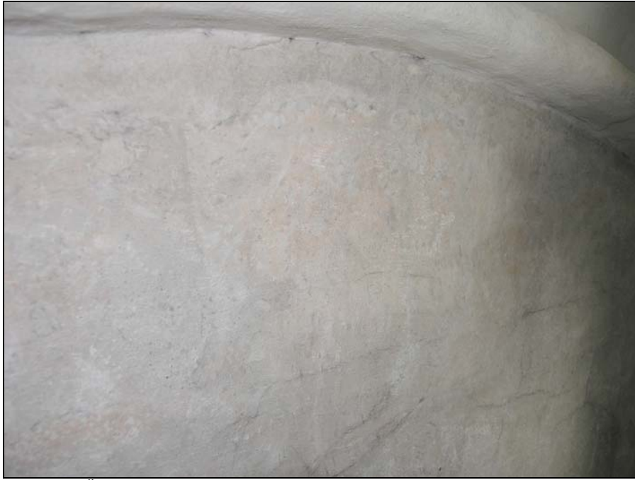
Figur 19. Äldre puts i sköldbågen mot söder med spår av en ljus rosa färg. Foto: Helén Sjökvist.
