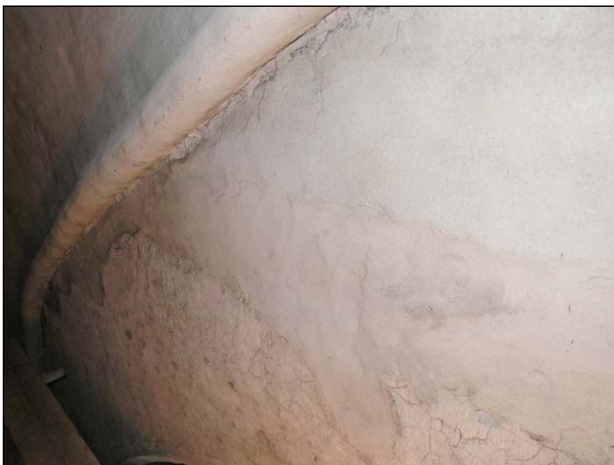
Figur 14. Nyare och äldre puts möts i gördelbågen mot söder. Foto: Helén Sjökvist.
