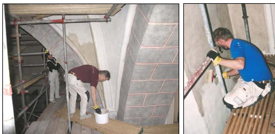
Figur 5. Konservering samt lavering pågår i travé 5. Foto: Helén Sjökvist.
