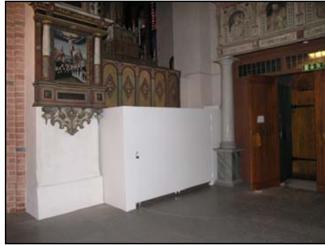
Figur 32. Detaljbild av förråd byggt av skivmaterial som skruvats mot en regelstomme.
