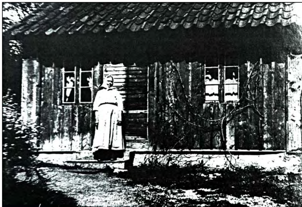
Figur 42. Axel Jobanssons mor utanför den gamla undantagsstugan vid Kalvstorp, 1925. Stugan är brädfodrad med breda, kilsågade bräder och taket täcks med enkupigt tegel. Fönstren har inga omfattningar och dörren är mycket enkel.
