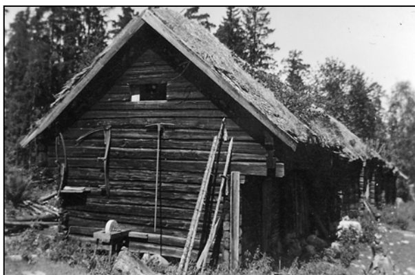
Figur 20. Vitmossens äldre ekonomibyggning med räfsa och lie på gaveln. När bilden togs är ovisst, men med tanke på takets kondition har byggnaden lämnats öde.
