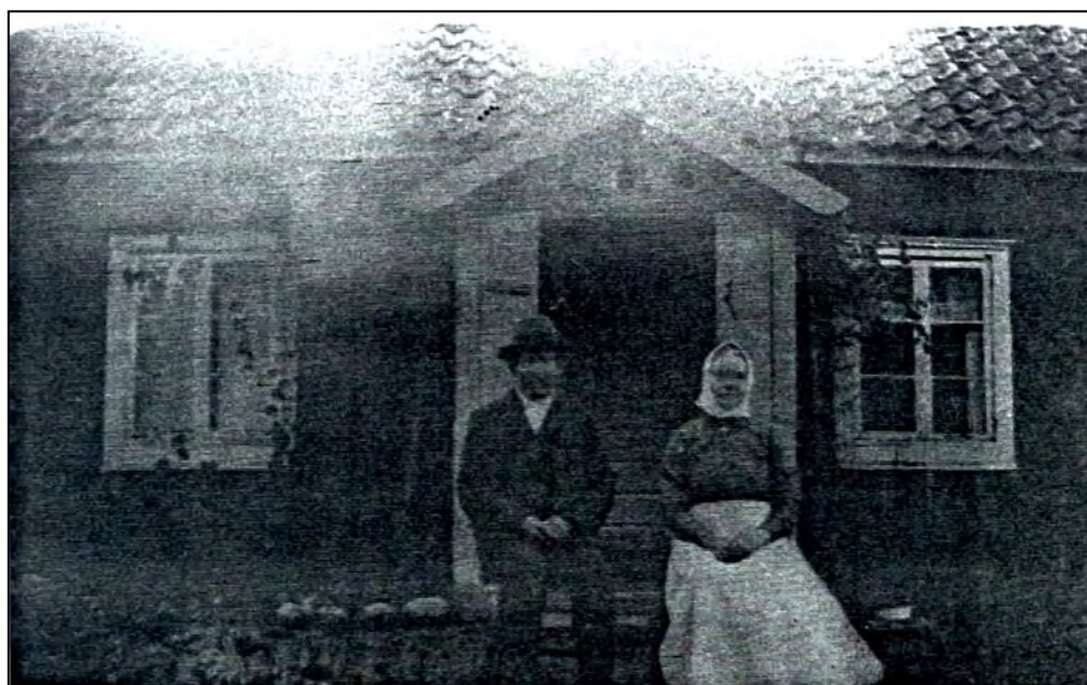
Figur 43. Axel Jobanssons föräldrar utanför den nyare stugan vid Kalvstorp. Stugan är lite mer påkostad än den gamla stugan på torpet. Den har en liten förstukvist och omfattningar kring fönstren.
