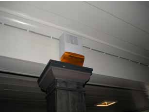
Figur 4. Sala sockenkyrka, sydingång med diodskylt. Figur 5. Sala sockenkyrka, siren med blixtljus på västsidan av bjälke under läktare.
