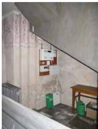
Figur 6. Sala sockenkyrka. Installationerna under läktartrappan är uppsatta på en skiva för att minska antalet fästpunkter. Figur 7. Sala sockenkyrka, rör för samplingsystemet draget strax under nocken.
