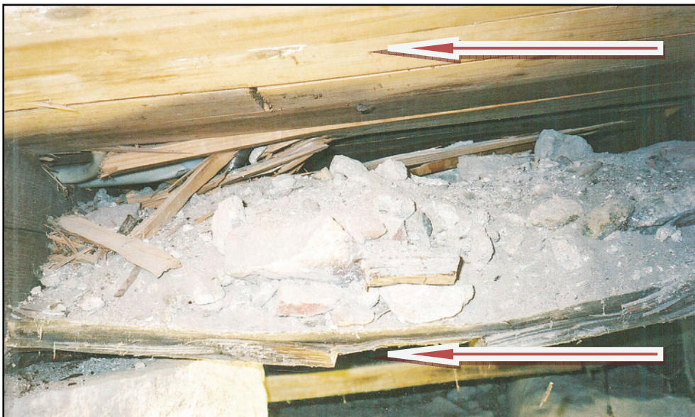
Figur 7. Bilden visar de båda golvnivåerna med diverse pålagt skräp mellan dessa. Den övre pilen visar det nuvarande golvet från 1906-07. Den nedre visar det äldre trägolvet som har en osäker datering, men som borde vara yngre än kyrkbranden 1764. (Foto U. Alström.)
