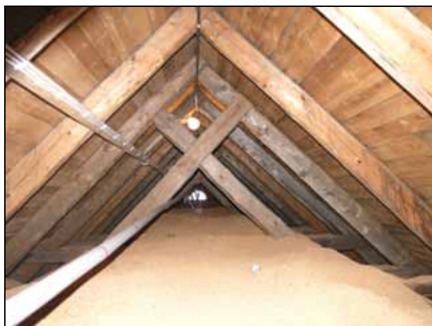
Figur 3. Vind och takstol med sågspånsisolering före ytterligare åtgärder. Foto: Helén Sjökvist.
