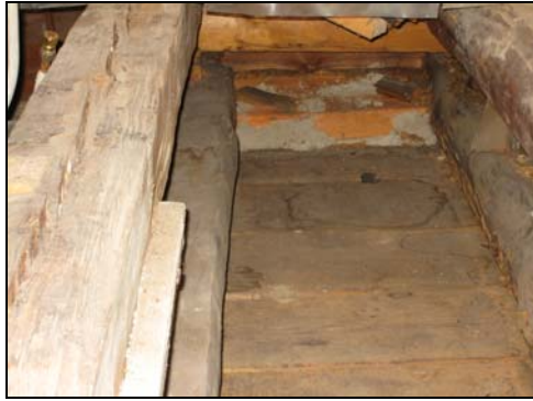
Figur 20. Bjälklag och undre trossbotten sedd mot yttervägg. Foto: Helén Sjökvist.
