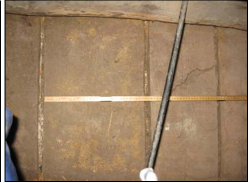
Figur 20. Bjälklag och undre trossbotten sedd mot yttervägg. Foto: Helén Sjökvist.
