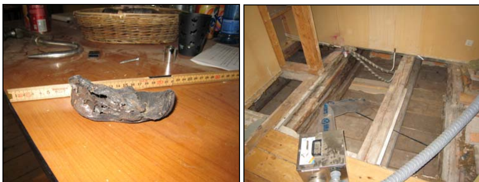
Figur 18. Barnsko i skinn som hittades i trossbotten. Foto: Helén Sjökvist.
