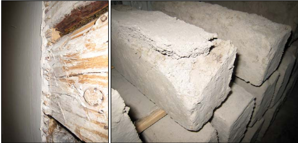
Figur 6. Timmerväggarna med smala, trekantiga trälistor för att jämna ut mellan timmervarven samt vassmatta för att ge putsfäste. Foto: Helén Sjökvist.
