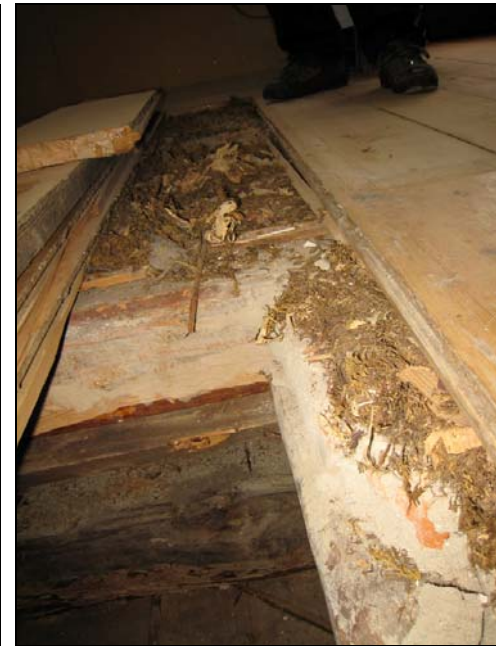
Figur 22. Övre våningens bjälklag med en övre trossbotten med brandbotten av tegel samt en undre trossbotten med lättare material. Foto: Helén Sjökvist.
