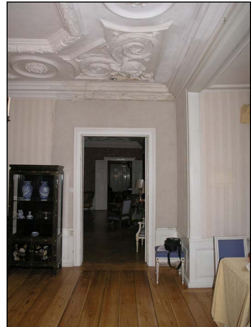
Figur 13. Omslipat golv med neddrivna spikskallar. Foto: Helén Sjökvist.
