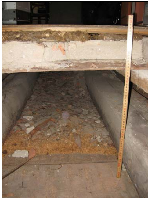
Figur 22. Övre våningens bjälklag med en övre trossbotten med brandbotten av tegel samt en undre trossbotten med lättare material. Foto: Helén Sjökvist.
