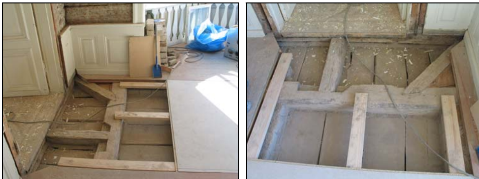
Figur 8. Bjälklag och trossbotten i salongen efter borttagandet av lertegel. Foto: Patrick Björklund.
