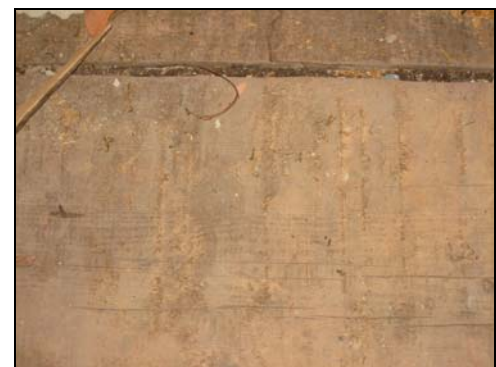
Figur 25. Spår efter kran- eller ramsågning i bräder. Foto: Helén Sjökvist.
