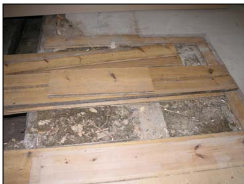
Figur 24. Fyllning i övre trossbotten. Foto: Helén Sjökvist.
