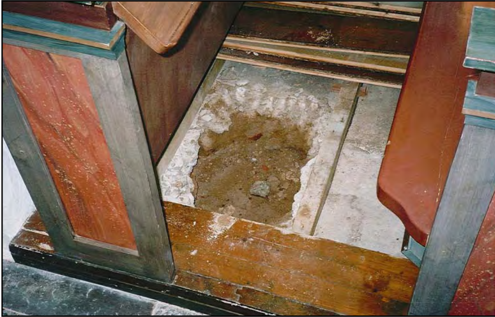
Figur 7. Provgrop 6 i norra bänkkvarteret. Under betongen fanns sandblandad lera. (Foto U. Alström.)
