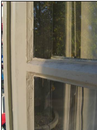
Figur 19. Kompletterat kitt. Foto: Helén Sjökvist.
