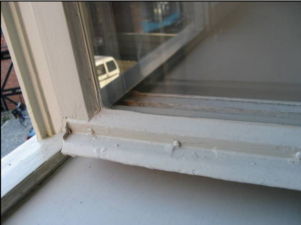
Figur 20. Droppblecken är demonterade och återmonterade. Foto: Helén Sjökvist.
