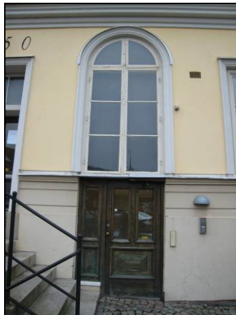
Figur 11. Originalfönsterbåge på norra sidan före åtgärder. Foto: Helén Sjökvist.
