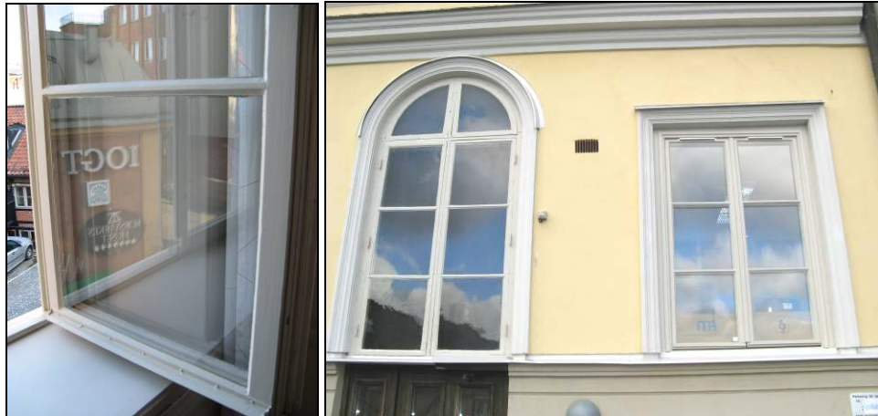
Figur 21. Omkittad och ommålad båge norra fasaden. Foto: Helén Sjökvist.
