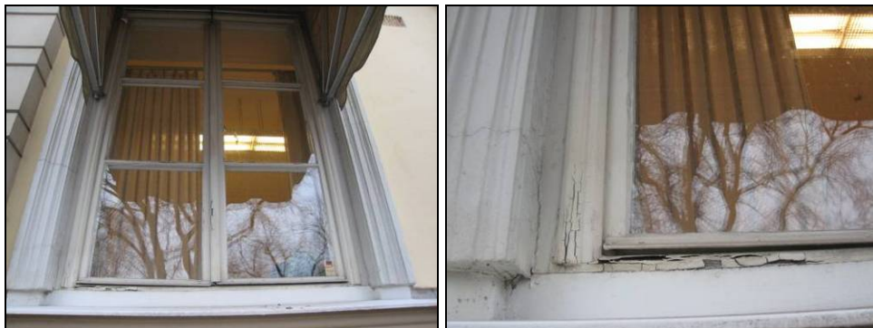
Figur 7. Sydfasadens nedervåning, tredje fönstret från öster räknat. Foto: Helén Sjökvist.
