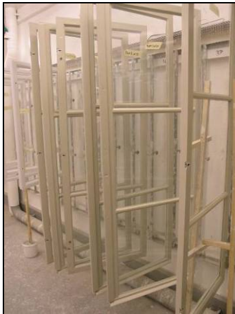
Figur 17. Bågarna åtgärdades på verkstad. Foto: Helén Sjökvist.
