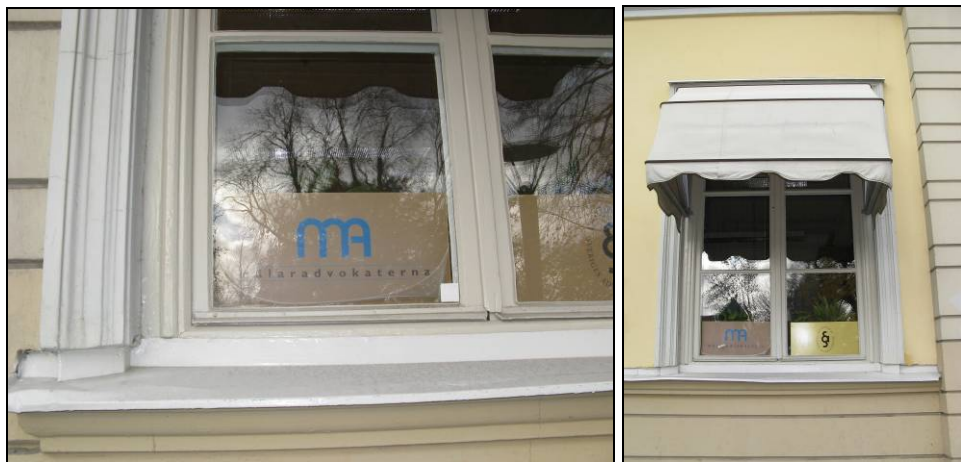
Figur 23. Fönster södra fasaden efter åtgärder. Foto: Helén Sjökvist.
