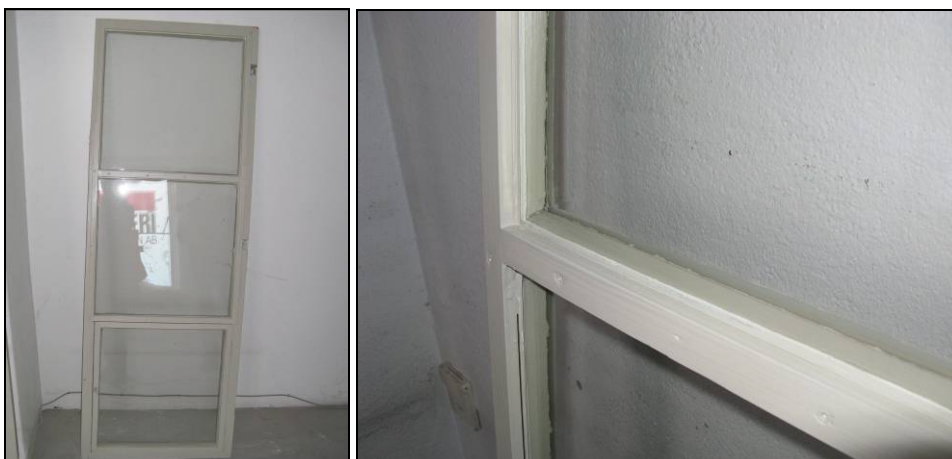
Figur 29. De gamla ytterbågarna i arkivet har kompletterats med en isolerglasruta på insidan. Foto: Helén Sjökvist.
