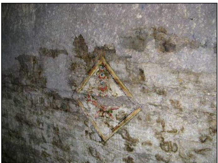
Figur 25. Norra väggen med pappersmassa som kompletterar i lakunerna. Jämför med figur 8 och 9. Foto: Helén Sjökvist.
