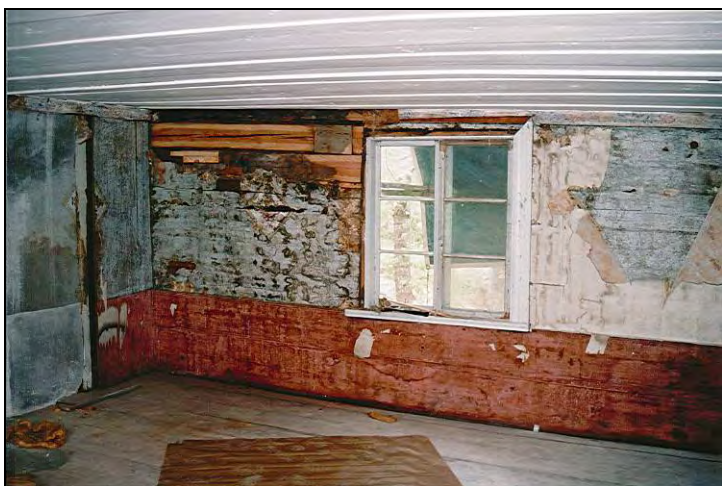
Figur 8. Norra väggen före konserveringsinsatser. Timmerlagningar utförda i det nordvästra hörnets övre stockvarv. Foto: Helén Sjökvist.
