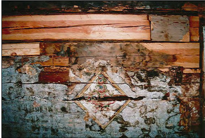
Figur 9. Närbild av timmerlagningarna i det nordvästra hörnet. Foto: Helén Sjökvist.
