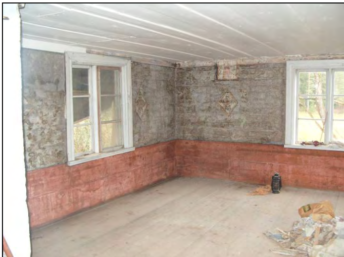
Figur 24. Nordöstra delen av rummet färdigställt. Observera i det övre vänstra hörnet de lakuner på norra väggen som ilagats med pappersmassa. Foto: Ann Olander.
