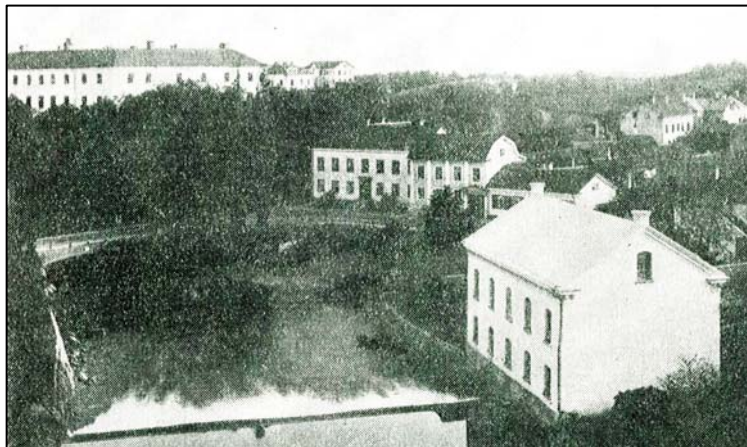
Figur 4. Är detta den dammarn som omtalas i 1700-1800 talens källor? Den stora vita byggnaden till höger i bild är Wickbolmska kvarnen. Förmodligen är dammvallen anlagd för driften av kvarnen Foto från norr. (Bild från Öberg 1946).
