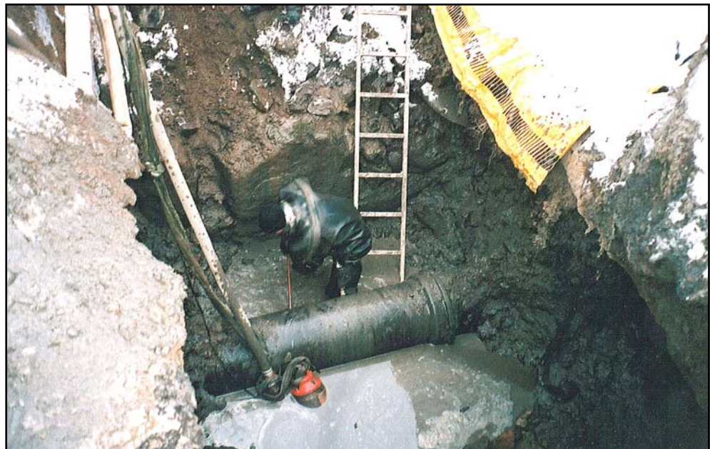
Figur 7. Bilden visar det järnrör som lades ner cirka 1890. Bakom mannen med våtdräkt syns delar av det norra fundamentet av hospitalsbron bestående av meterstora tuktade stenar i kallmur. (Foto U. Alström.)
