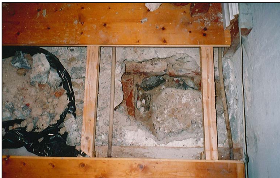
Figur 9. Provplats 9 intill kyrkans södra vägg. Under betongen skymtar tegelgolvet. (Foto U. Alström.)
