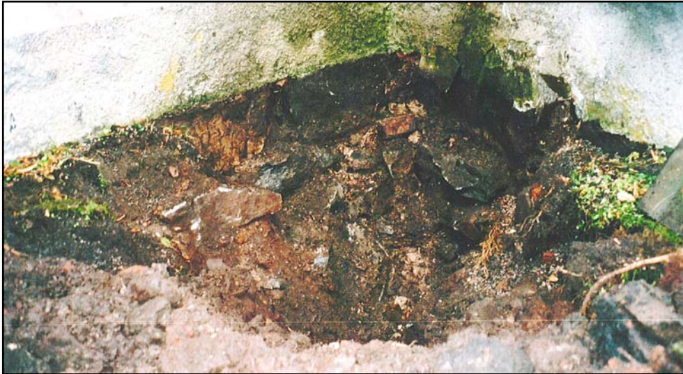
Figur 7. Provplats 3 hade en stenkista under stupröret. I gropen noterades även rödfärgad jord som färgats av regnvattnet från det rödfärgade spåntaket. (Foto U. Alström.)
