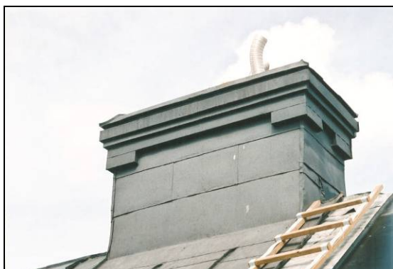
Figur 20. Skorstenarnas profilerade plåttäckning före omtäckning.
