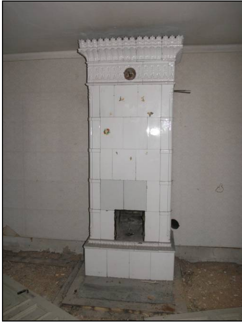
Figur 53. Kakelugn före nedplockning.
