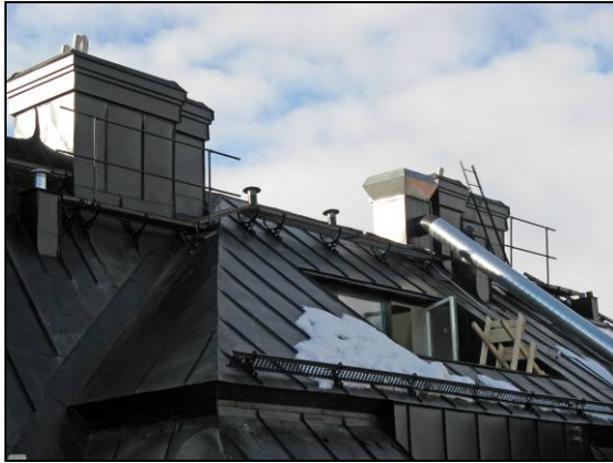
Figur 24. Övre takfall mot öster med bandtäckning och ny takterass.
