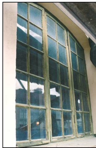
Figur 27. Ett av de fönster till pigkammarna som byttes ut. Fönstret hade tre bågar.
