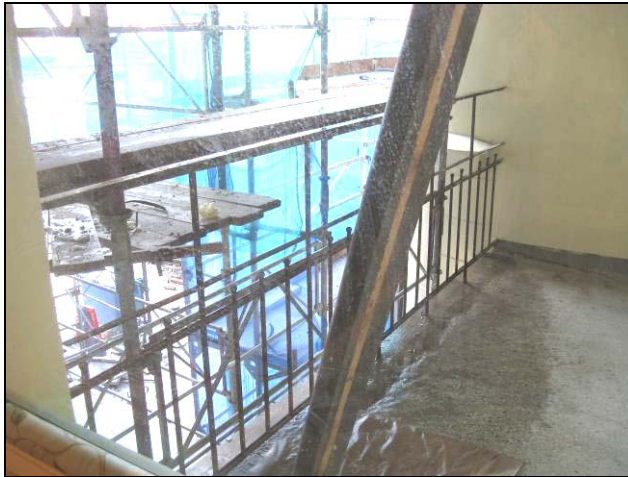
Figur 33. Upptagning av öppning i murverk för ny balkong.
