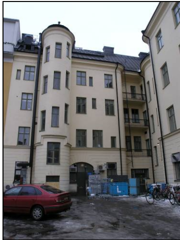
Figur 9. Fasaden mot norr är även den utsmyckad på samma sätt som mot gatan med hörntorn och dekorativa balkonger.
