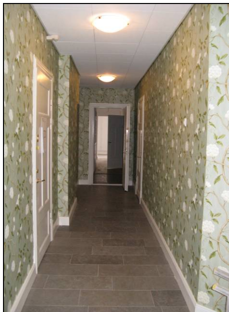
Figur 73. Ny korridor med nya lägenhetsentréer från korridoren. Taket sänkt i korridoren för att inrymma ventilation till lägenheterna. Nytt kalkstensgolv.
