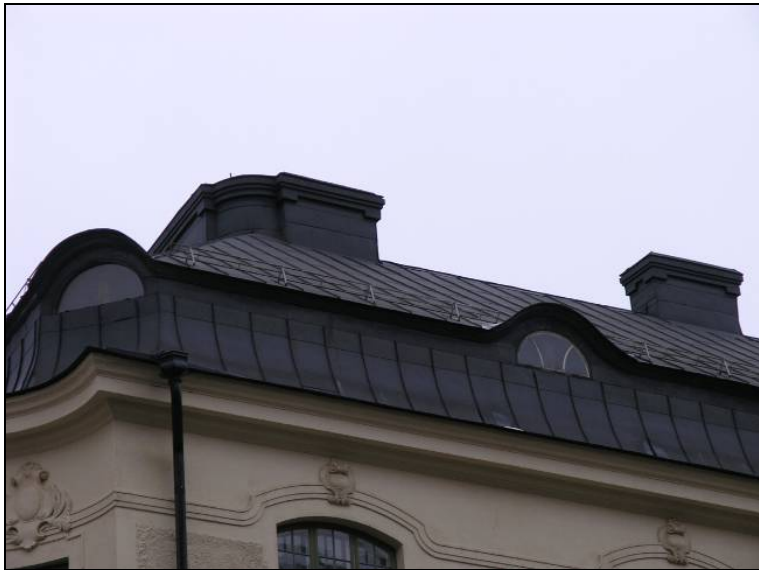
Figur 7. Takfallet mot Stora gatan. Tvärfalsarna är ej förskjutna. Takkuporna är utanpåliggande och försedda med med lunettfönster. Skorstenarnas inklädning är profilerad. Trattarna till takavvattningen tycks även de vara i originalutförande.
