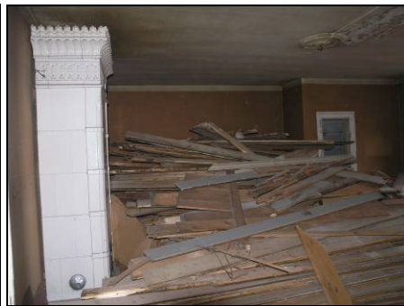
Figur 55. En av pigkammrarna med rivna väggar. Fönstret byttes ut för att klara utrymningskraven.
