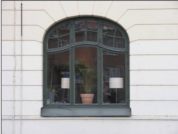
Figur 14. Fönster i bottenvåningen mot Karlsgatan. Typisk jugendform med korgbågig överdel, organiska former och småspröjsade övre rutor.
