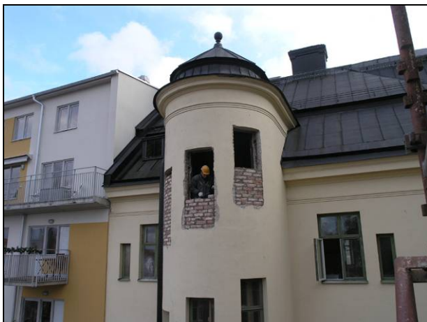
Figur 49. Fönsteröppningar murades igen för att få fönstersättningen att fungera med de nya bjälklagen. Återvänt tegel från det rivna trapphuset användes vid murning.
