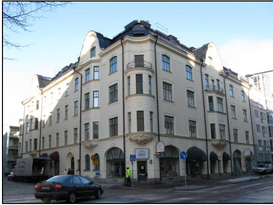
Figur 32. Fasaden efter ombyggnaden med igensatta lunettfönster.
