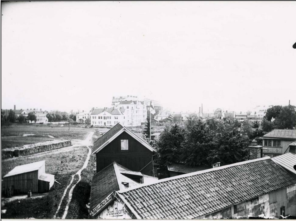
Figur 3. Stora och lilla Officershuset syns i bakgrunden och Tennjutargården i förgrunden. Som framgår av bilden låg den aktuella byggnaden i gränslandet mellan stad och land då den uppfördes. Fotografi från 1911. VLM arkiv.
