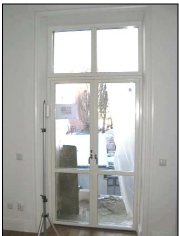
Figur 35. Nya öppningar togs upp i fasaden för att få in nya balkonger.
