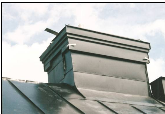
Figur 21. Skorstenarnas profilerade plåttäckning efter omtäckning. Vissa detaljer har gått förlorade.
