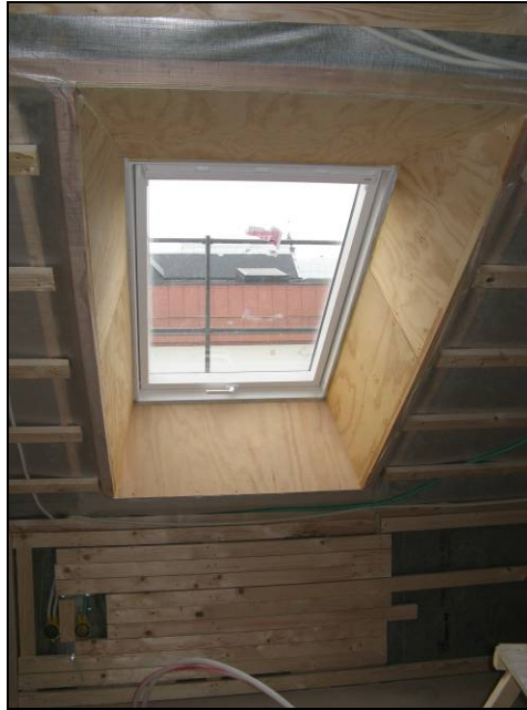
Figur 60. Pågående inredning av vinden med nypiptaget fönster och isolerat takfall.
