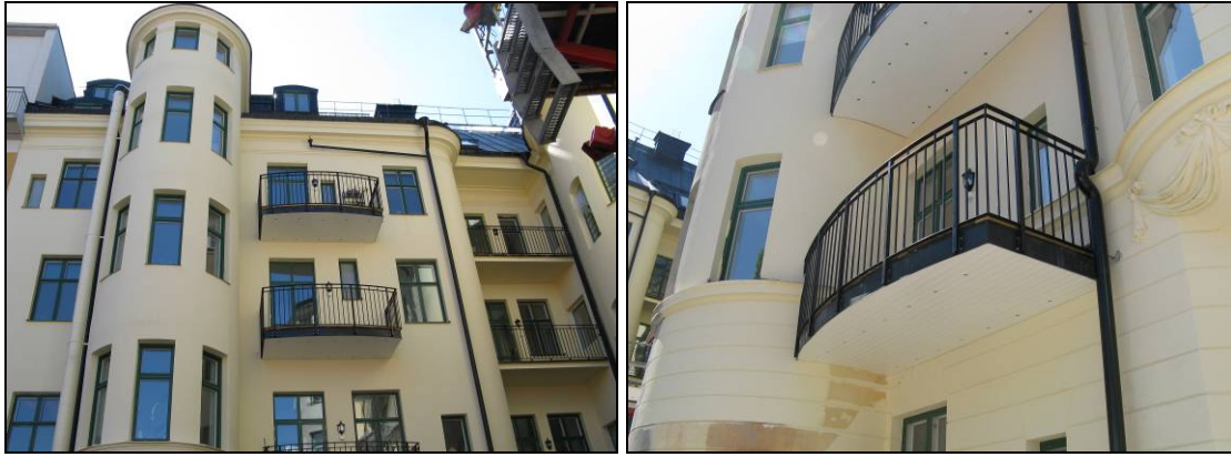
Figur 37. Nyttillkomna balkonger till vänster samt nya räcken till befintliga balkonger till höger. Figur 38. Nyttillkommen balkong.
