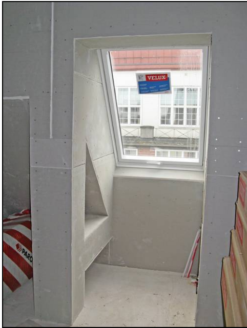
Figur 59. Pågående inredning av vinden med nypiptaget fönster.
