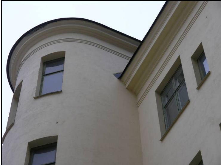
Figur 13. Profilerad takfot mot gården.
