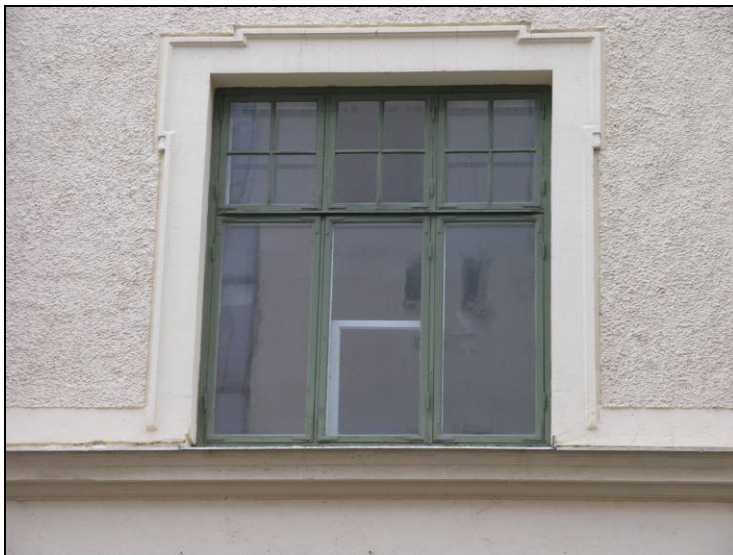
Figur 15. Fönster till andra våningsplanet med korspost, sex lugter och en typisk jugendform. Omfattningen är slätputsad med en profilering i ytterkant.
