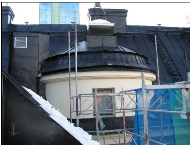
Figur 43. Påbyggnad av stora trapphuset.
