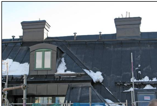
Figur 22. Nedre takfallet lades om med plåtar med endast något förskjutna falsar.
