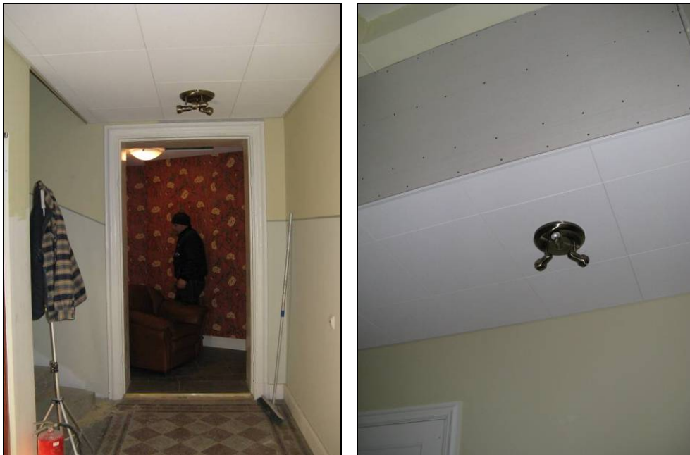
Figur 39. Vilplan på fjärde våningen med innanförbyggande ny entré till flera lägenheter (jämför figur 40). Figur 40. Ventilationen har medfört att taket sänkts även i trapphuset (jämför figur 42).
