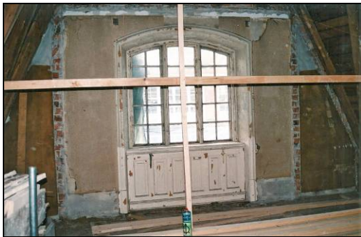
Figur 55. En av pigkammrarna med rivna väggar. Fönstret byttes ut för att klara utrymningskraven.
