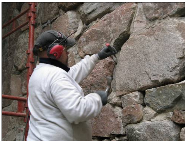
Figur 27. Det fanns omfattande inslag av humus och mossa i fogarna före restaureringen. Foto: Helén Sjökvist.
