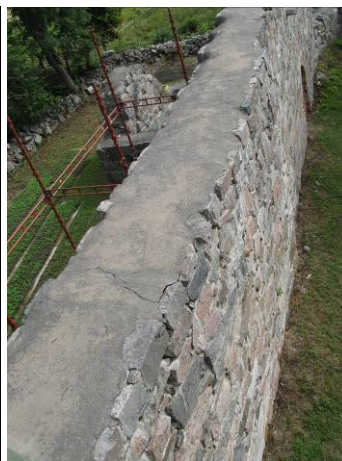
Figur 21. Fogrensning av mur på norra långhusväggens insida, västra delen. Foto: Helén Sjökvist.
