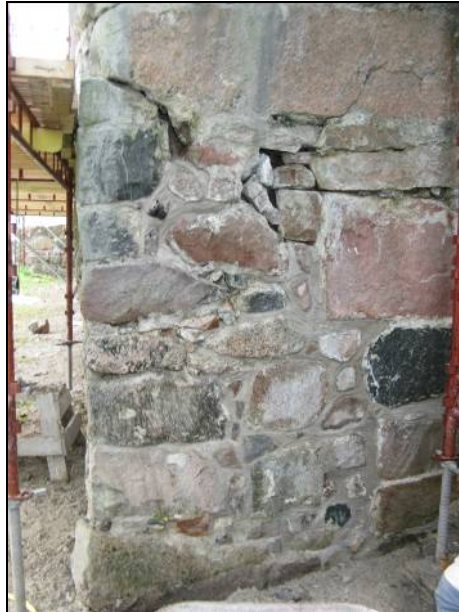
Figur 19. Långhusets yttre vägg, nordvästra hörnet. En sättningsskada gjorde att en omfattande spricka uppträdde. På bilden pågår fogrensning. Foto: Helén Sjökvist.
