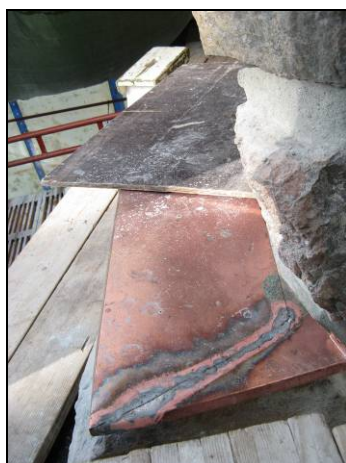
Figur 57. Kopparplåten till avtäckningarna löddes för att uppnå bättre passform till underlaget. Foto: Helén Sjökvist.
