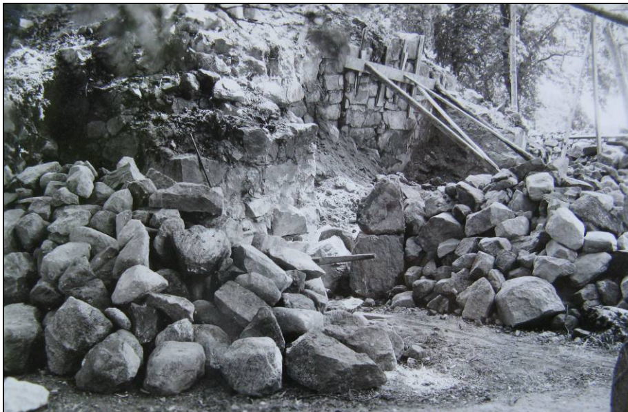
Figur 11. Västra gaveln sedd från nordväst under rekonstruktionsarbetet. Foto: VLM arkiv.
