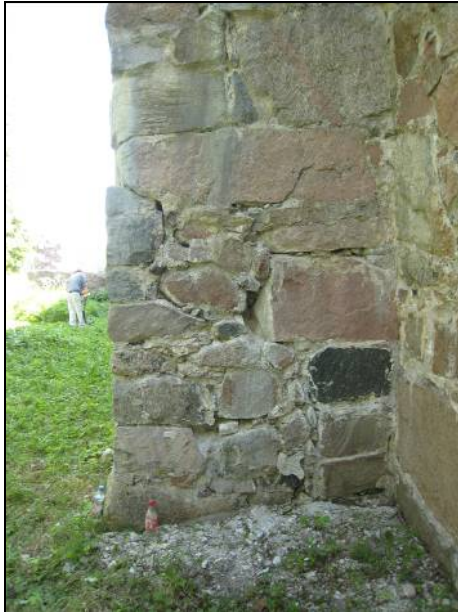
Figur 19. Långhusets yttre vägg, nordvästra hörnet. En sättningsskada gjorde att en omfattande spricka uppträdde. På bilden pågår fogrensning. Foto: Helén Sjökvist.
