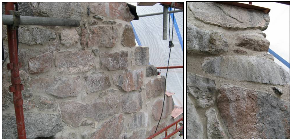
Figur 49. Ommurat parti på gavelröstets östra sida, mot norr. Foto: Helén Sjökvist.
