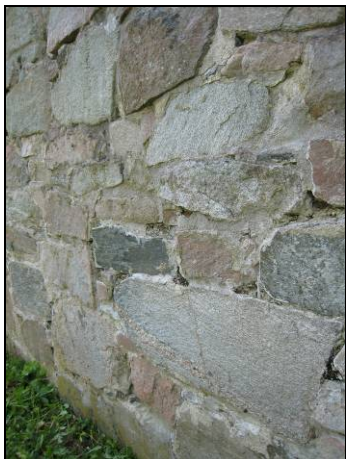
Figur 27. Det fanns omfattande inslag av humus och mossa i fogarna före restaureringen. Foto: Helén Sjökvist.
