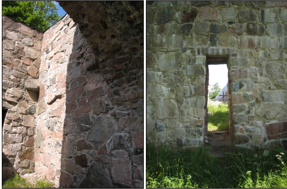
Figur 13. I tornets hörn finns upplagsstenar för bjälklaget. I det nordöstra och det nordvästra hörnet fanns dessa kvar vid restaureringen 1938-39. I det sydvästra hörnet lades en till i samband med restaureringsarbetet 1937. I det sydöstra utelämnades detta moment.
