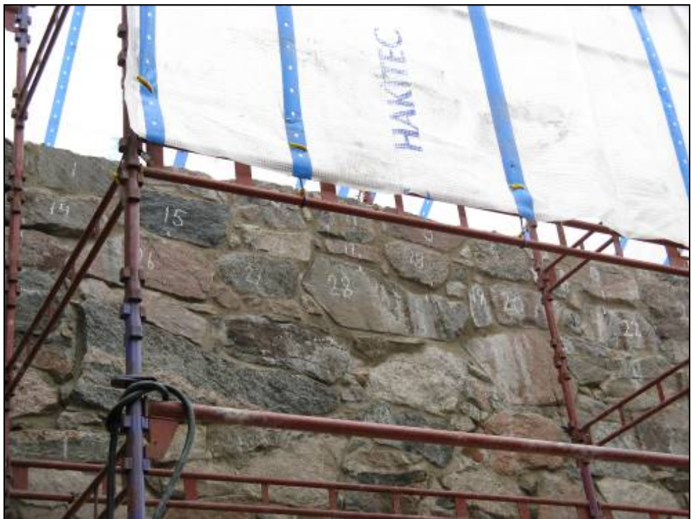
Figur 24. Parti i väster av norra murens övre del sedd från långhuset. Övre delen av muren har murats om i detta parti. Stenarna som nummerats har blivit ommurade. Jämför med figur 18. Foto: Helén Sjökvist.
