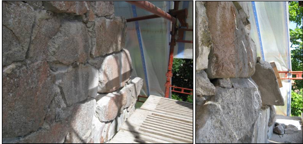
Figur 45. Gavelröstets östra sida, mot norr. De yttersta stenarna låg löst och måste säkras. Foto: Helén Sjökvist.
