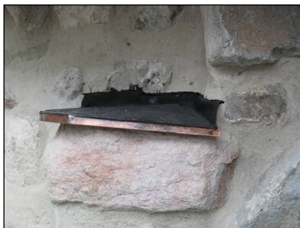
Figur 55. Avtäckning med kopparplåt i öppning i röstet. Foto: Helén Sjökvist.
