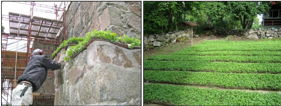
Figur 59. Sedumläggning på tornets norra vägg. Foto: Helén Sjökvist.
