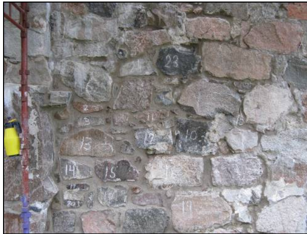
Figur 25. Norra långhusväggen sedd från långhuset, vid stötfog, sedd efter fogrensning. Ett parti med löst sittande stenar fick muras om. Foto: Helén Sjökvist.
