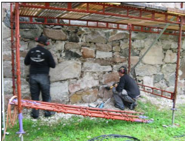
Figur 21. Fogrensning av mur på norra långhusväggens insida, västra delen. Foto: Helén Sjökvist.
