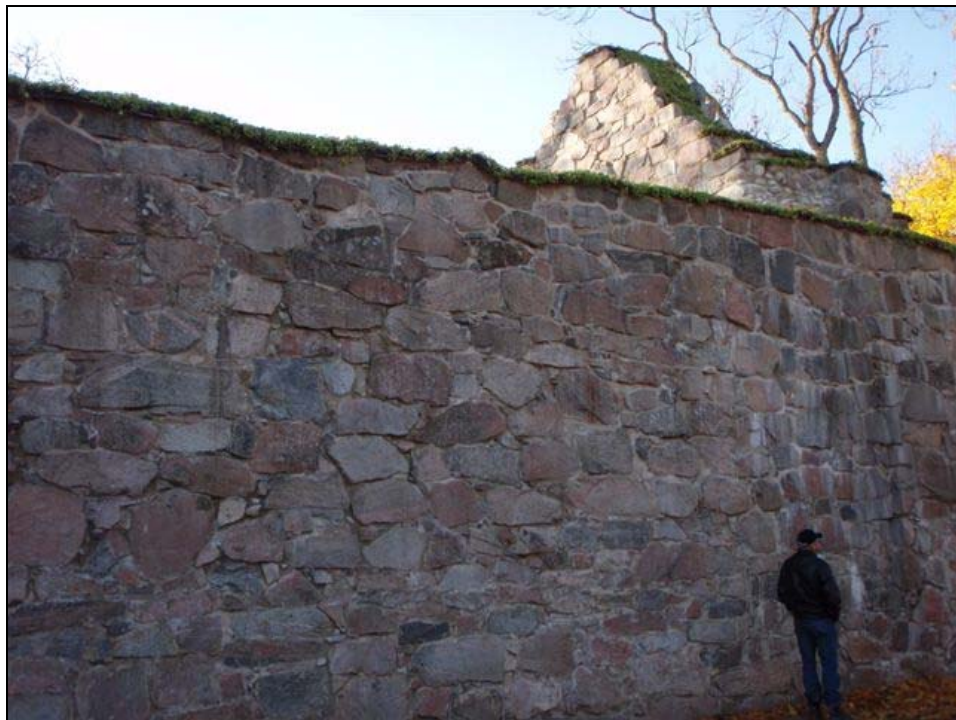
Figur 32. Norra längbusväggen färdigställd och täckt med sedum. Foto: Cecilia Lagerfalk-Rootb, Länsstyrelsen i Västmanlands län.
