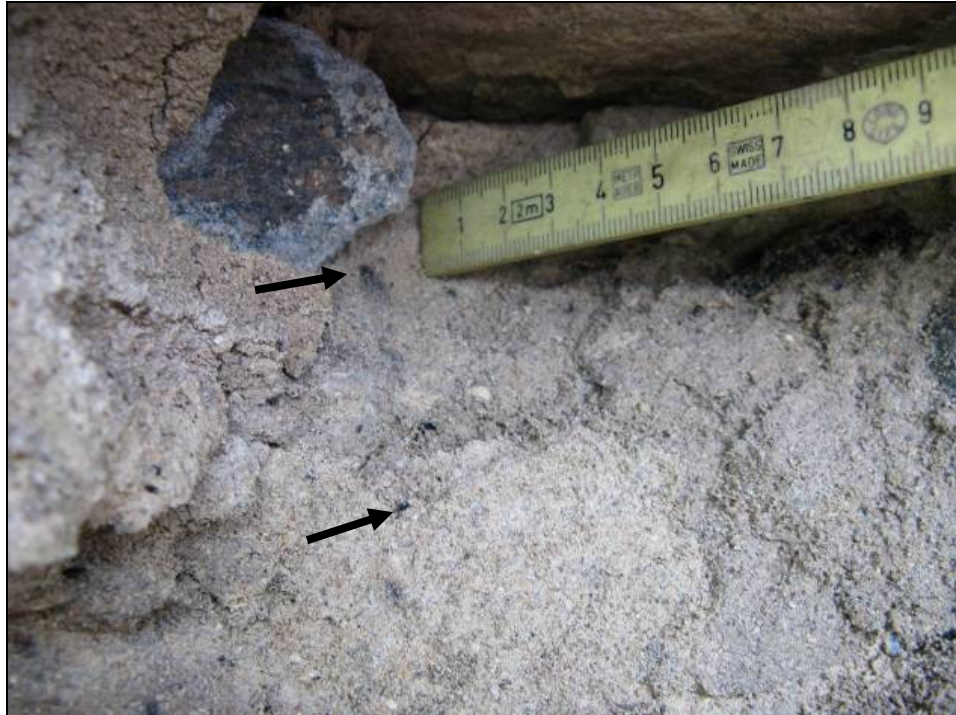
Figur 31. Pilarna pekar på några exempel på den omfattande kolförekomsten i bruket i den norra längbusväggen medeltida delar. Foto: Helén Sjökvist.
