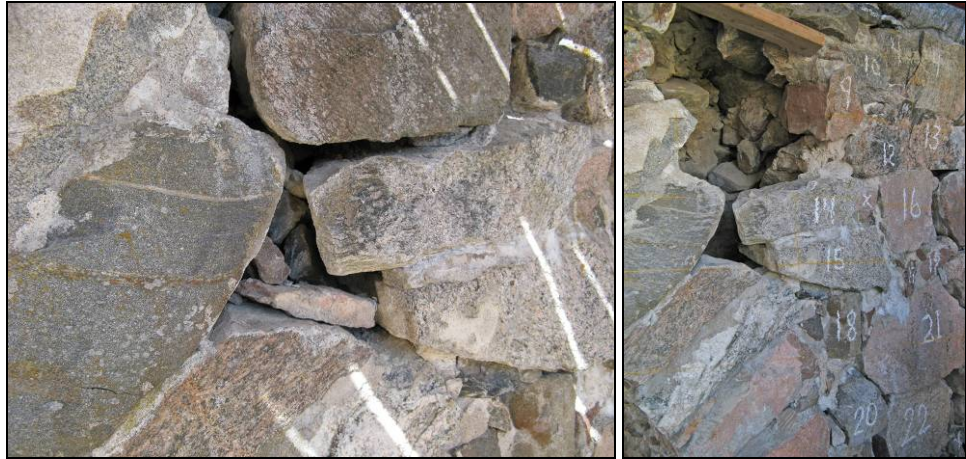
Figur 35. Västra gaveln norr om valvbågen. Lösa stenar med tomrum bakom. Foto: Helén Sjökvist.
