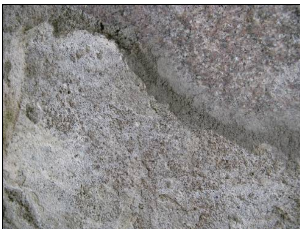
Figur 29. Bevarat putsparti på långhusets norra vägg. Foto: Helén Sjökvist.
