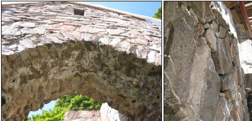
Figur 33. Valvbågen mellan torn och långhus före restaureringsåtgärder. Foto: Helén Sjökvist.
