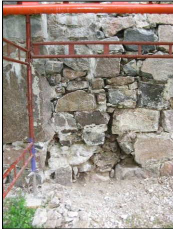
Figur 25. Norra långhusväggen sedd från långhuset, vid stötfog, sedd efter fogrensning. Ett parti med löst sittande stenar fick muras om. Foto: Helén Sjökvist.
