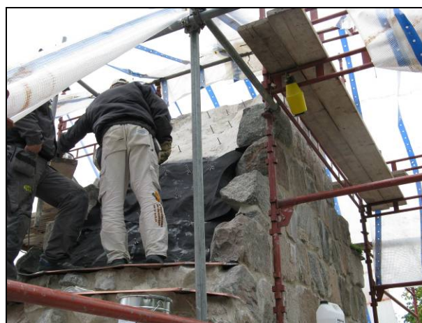
Figur 57. Kopparplåten till avtäckningarna löddes för att uppnå bättre passform till underlaget. Foto: Helén Sjökvist.
