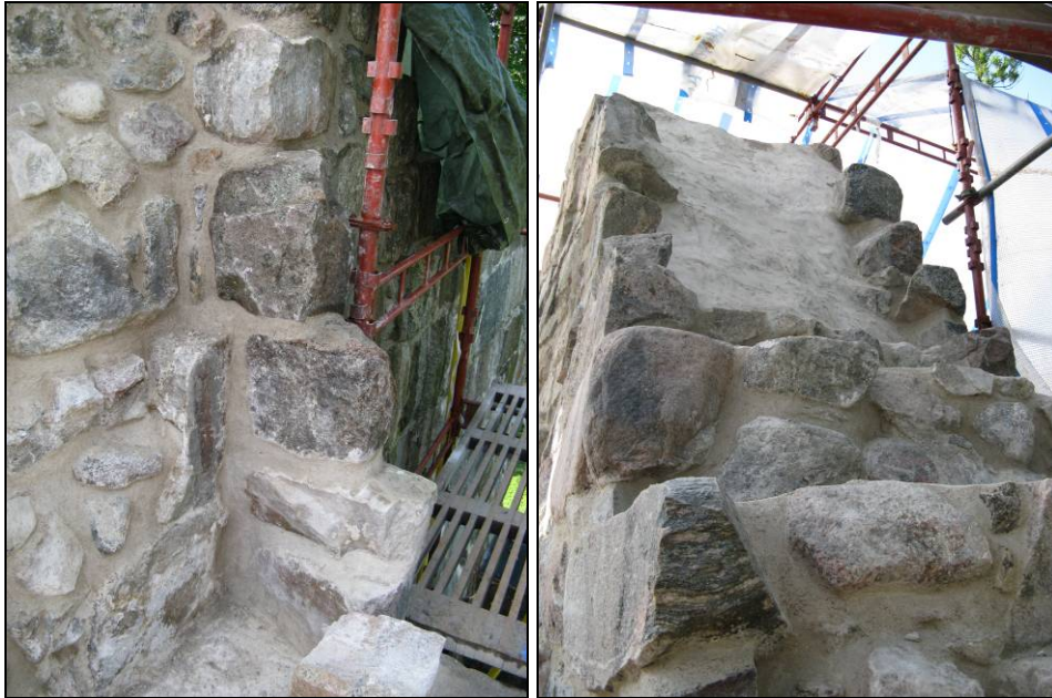
Figur 51. Gavelröstets anslutning till torn och långhusets norra vägg, efter restaurering. Muren har blivit mer accentuerad. Foto: Helén Sjökvist.
