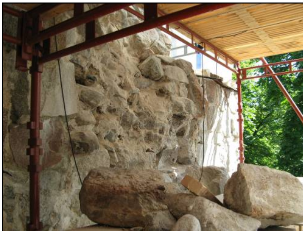
Figur 43. Bortrensning av löst sittande stenar i anslutningen mellan västra gaveln och tornet. Foto: Helén Sjökvist.
