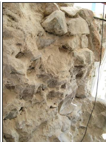
Figur 43. Bortrensning av löst sittande stenar i anslutningen mellan västra gaveln och tornet. Foto: Helén Sjökvist.
