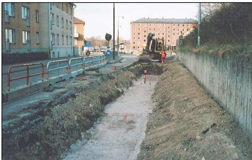
Figur 1. Del av fjärrvärmeschaktet i Torggatan fotograferat från öster. (Foto U. Alström.)
